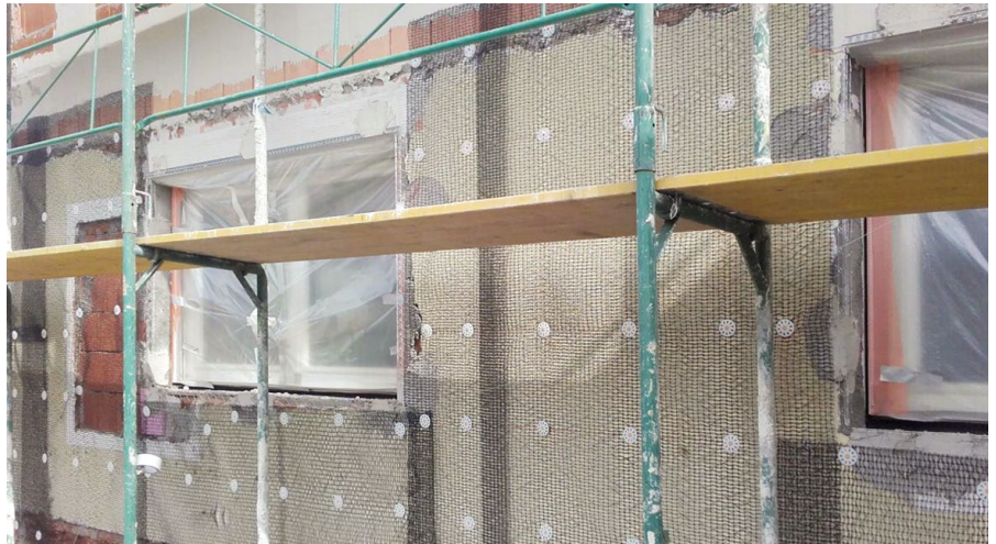
Bohren des Dübelloches und setzen des Dübels
