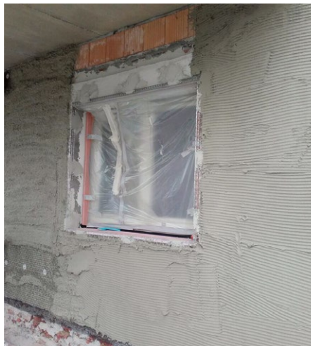
Putz maschinell aufbringen
