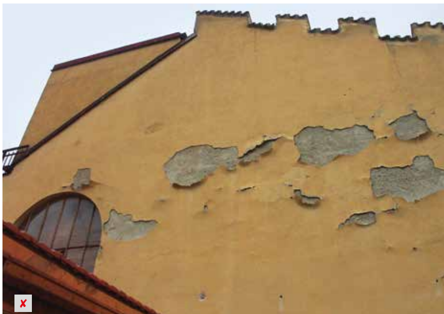
Rezultati renovacij s preveč zatesnjenimi ali pretogimi izravnalnimi masami
