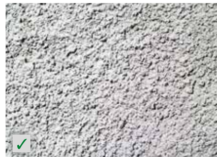
Grobe zaključne omete RÖFIX Renostar®, RÖFIX Renoplus®
