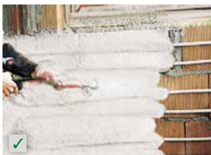
Stensko ogrevanje, vgrajeno v ometu RÖFIX Renoplus®
