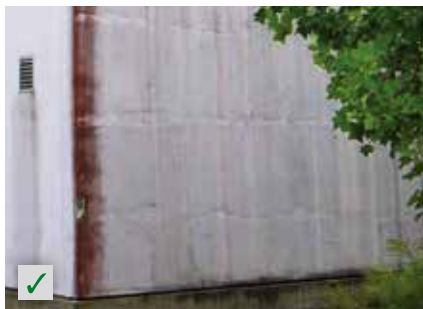
Alge na fasadah RÖFIX Renostar®, RÖFIX Renofino®
