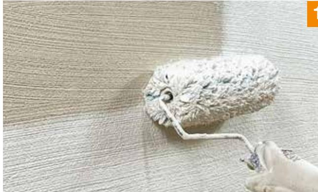
1. Nous recommandons d'appliquer une couche de fond sur la couche d'armature rendue rugueuse, avec Fixit 475 Couche de fond pour crépis minéraux, afin de garantir un pouvoir absorbant régulier du support.
