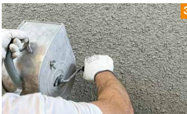
3. L'enduit à la tyrolienne 490 est projeté en oblique avec l'appareil Wormser pour éviter les marques d'échafaudage.
