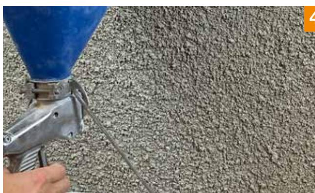
4. L'enduit à la tyrolienne 490 peut également être projeté au pistolet à entonnoir ou toute autre machine pour crépis à projeter.
