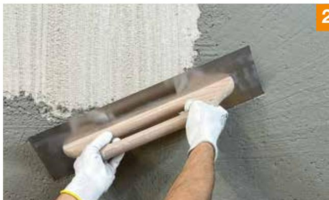
2. Une sous-couche de mortier adhésif Fixit 439 permet de réduire considérablement la consommation d'enduit à la tyrolienne 490. Cela améliore l'adhérence initiale lors du giclage avec l'appareil Wormser, et réduit le rebondissement des grains.
