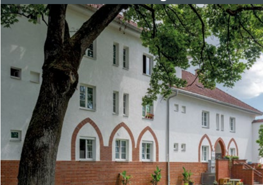
Die Wohnanlage Kaufleitnergründe in Linz wurde mit einem Wärmedämmverbundsystem mit harten Bekleidungen von Sto saniert.
