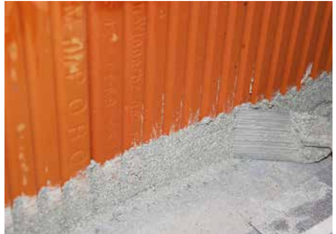
Klebefuge mit Klebemörtel bündig verstreichen (mind. bei jeder dritten Lage)
