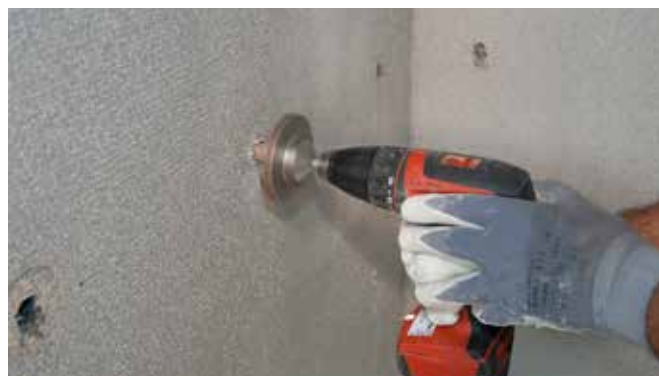
8 mm Dübelloch mit 18 mm Putzfräser aufweiten
