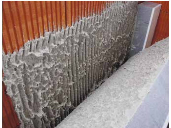
Kontrolle der Benetzungsfläche
