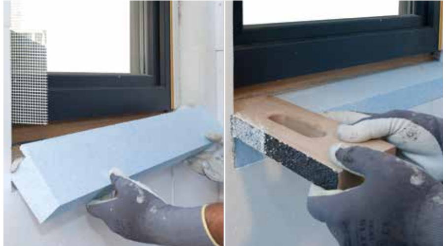
RÖFIX SOL-PAD Base einkleben und Nut für die Profilaufnahme einschleifen
