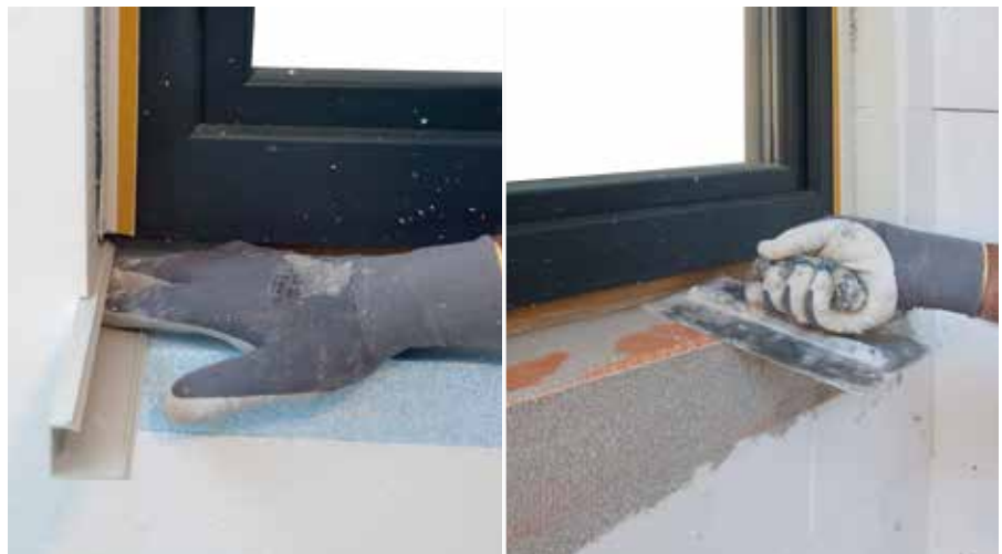
RÖFIX SOL-PAD Sohlbank- Anputzleiste mit RÖFIX MS POLYMER einkleben, dann den Aufnahmebereich der Fensterbank mit RÖFIX OPTIFLEX® 1K oder 2K dichtspachteln
