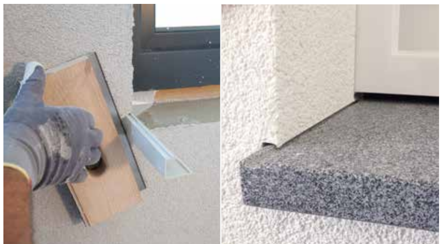
Mit dem RÖFIX SOL-PAD- Tool die RÖFIX SOL-PAD Anputzleiste mit 2 mm Überstand abschneiden und die Fensterbank montieren
