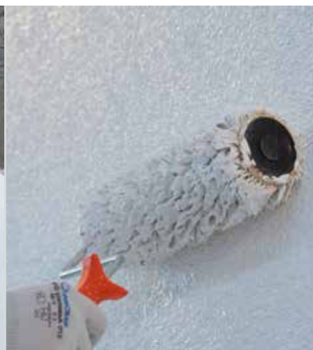
Zaključni premaz s silikatnimi barvami
