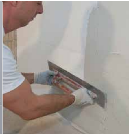
Armiranje plošč s specialno lepilno maso RÖFIX Renopor®
