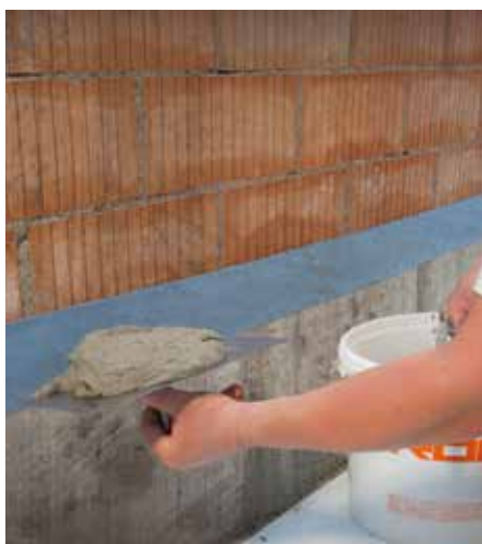
Trak za razpoke RÖFIX kot ukrep proti nastanku razpok
