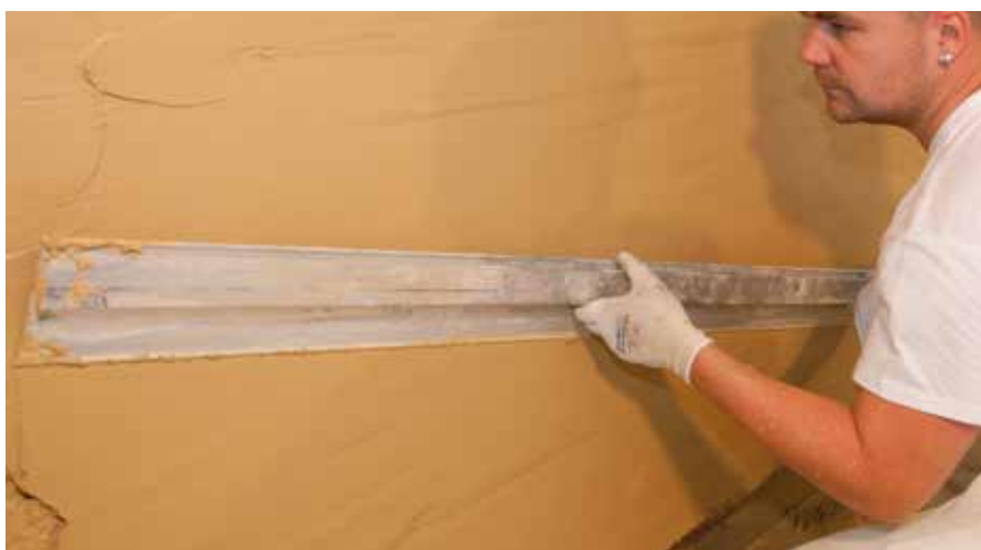
Poravnavanje glinenega ometa RÖFIX Geolehm®
