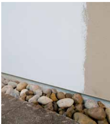
Izvedba podzidka s profilom
