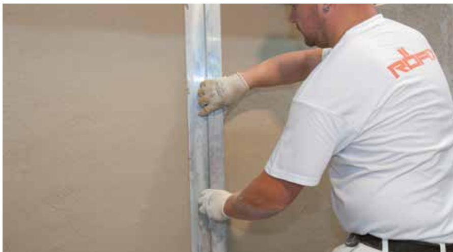
Poravnavanje izolacijskega ometa RÖFIX CalceClima® Thermo
