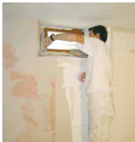
Montaža s klinastim elementom za zaključke RÖFIX Renopor®
