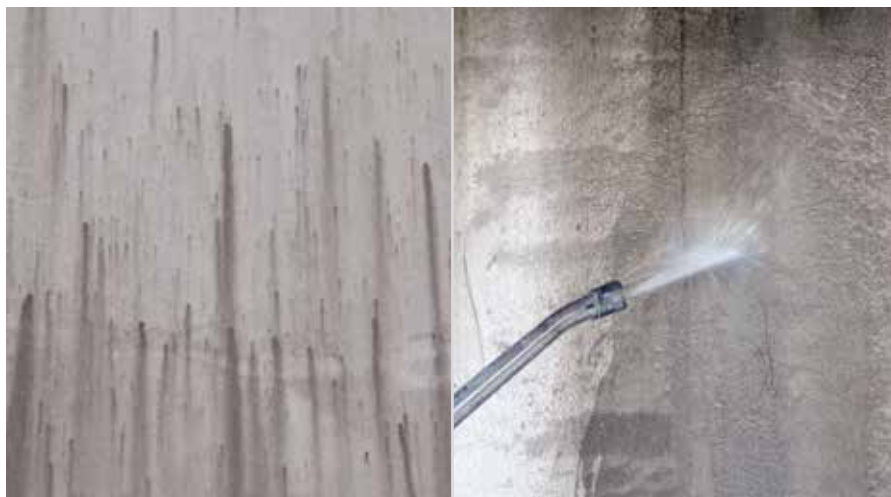
Fasadni omet, ki so ga napadle alge/glive
