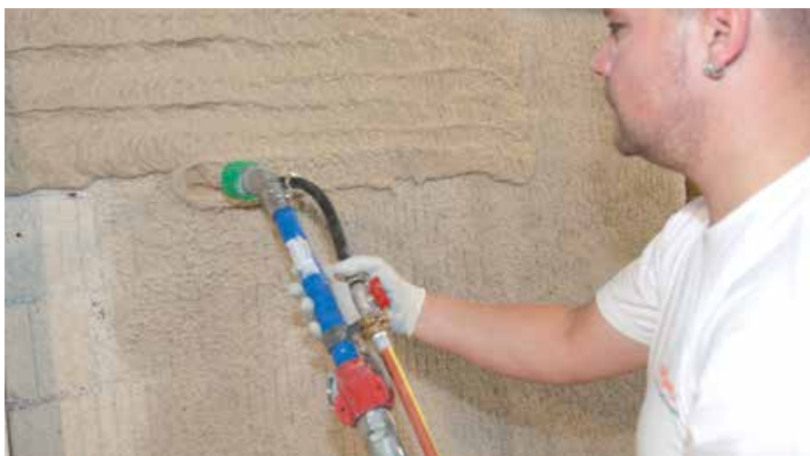
Nanašanje osnovnega ometa RÖFIX CalceClima® Ambiente
