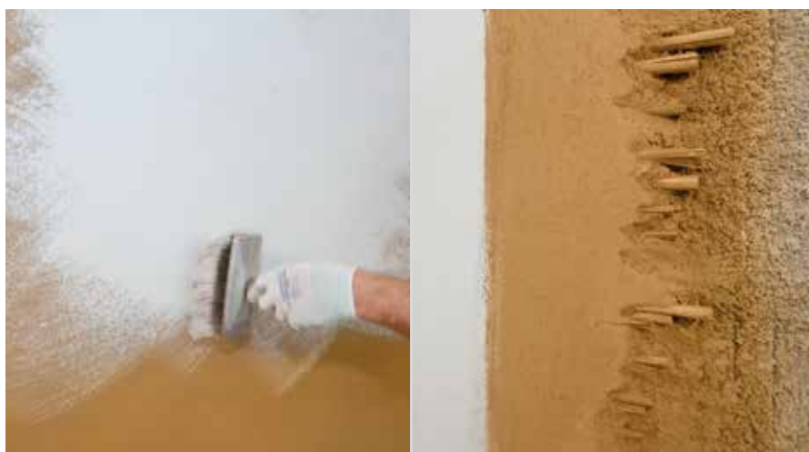
Barvni premaz z ekološko apneno barvo RÖFIX PE 819 SESCO
