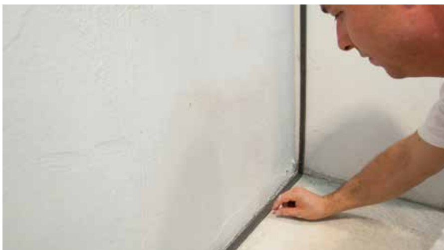
Montaža tesnilnega traku RÖFIX na talne, stenske in stopne priključke
