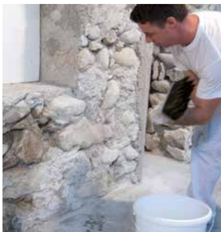
Nanese predpremaz RÖFIX Saniergrund s pleskarsko krtačo
