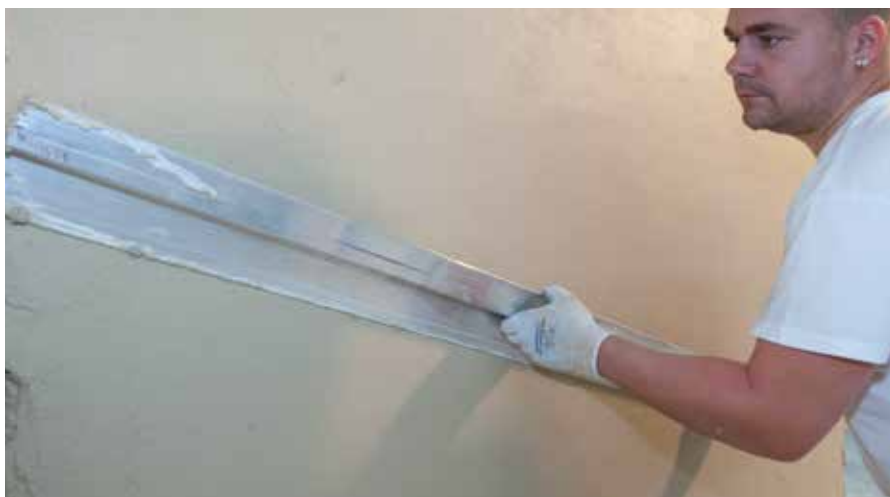
Porezovanje osnovnega ometa RÖFIX CalceClima® Ambiente
