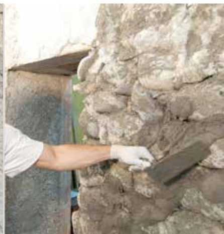
Zapolnimo z ometom/namečemo porozni osnovni omet RÖFIX 648
