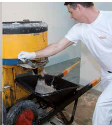
Gotova malta za izvedbo ometa
