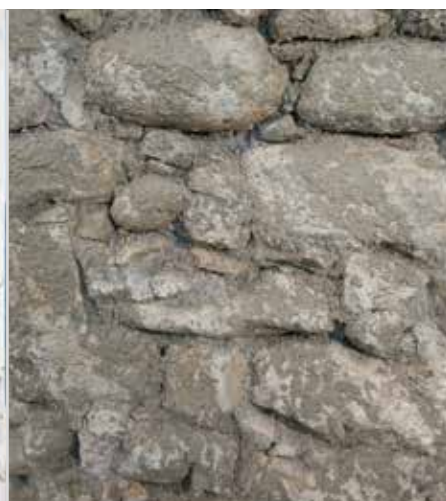
Namečemo sanacijski obrizg RÖFIX 671 s 60-odstotno pokrivnostjo
