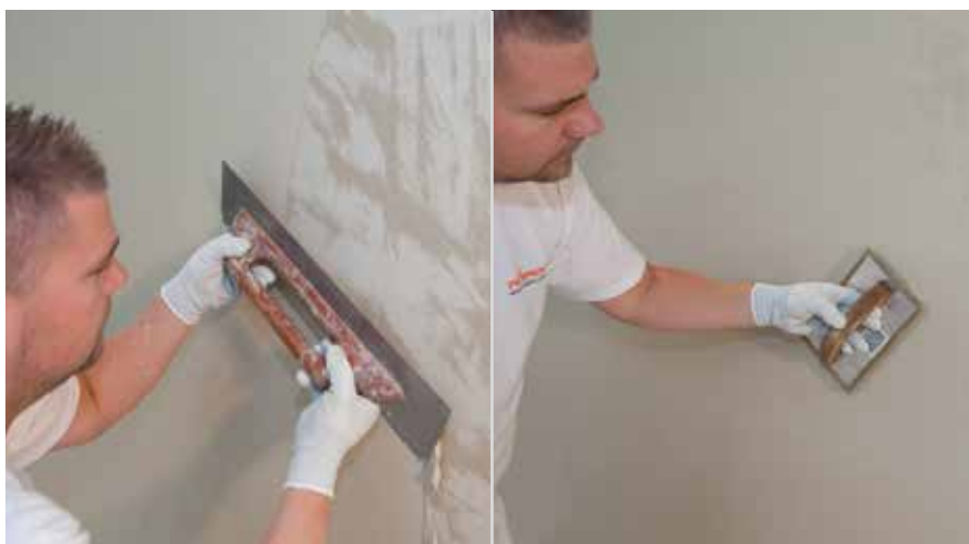
Nanos zaključnega ometa RÖFIX CalceClima® Fino
