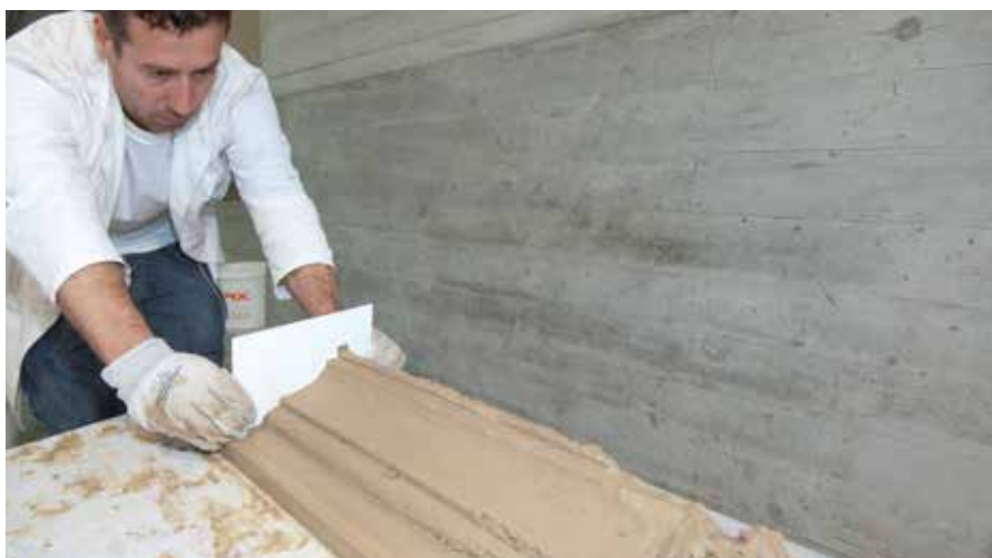
Posnemavanje vzdolžnih profilov s šablono
