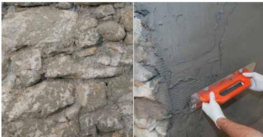
Sanacijski obrizg RÖFIX 671 s 60-odstotno pokrivenostjo | Sanacijski omet RÖFIX 640 v najmanjši debelini nanosa 20 mm
