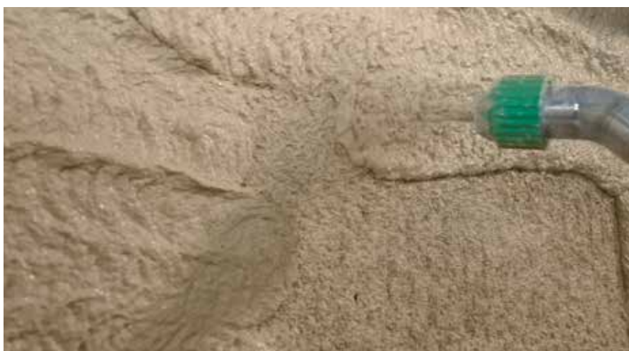
Nanašanje izolacijskega ometa RÖFIX CalceClima® Thermo
