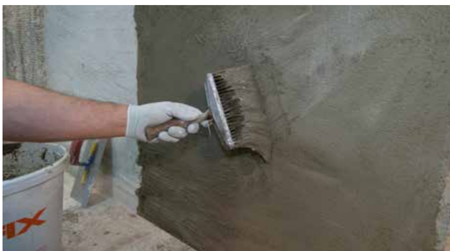
Tesnilni premaz RÖFIX 636 v debelini največ 3 mm na tesnilnem ometu RÖFIX 635
