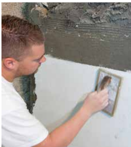
Zaribavanje in strukturiranje ometa RÖFIX 340/341
