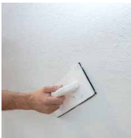
Strukturiranje s specialno lepilno maso RÖFIX Renopor®
