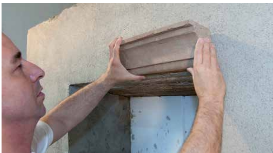
Montaža dekorativnih profilov
