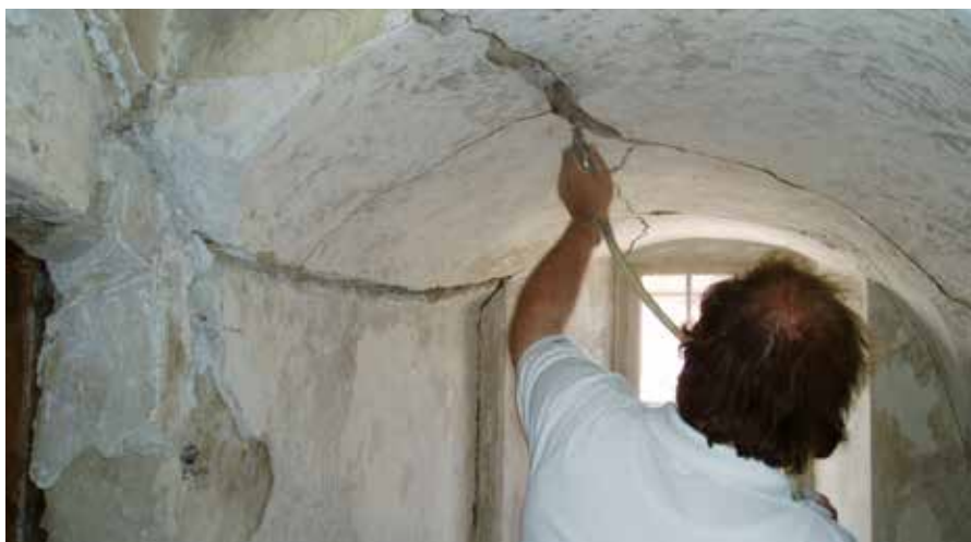
Injektiranje razpok v ometu
