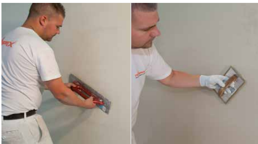
Nanos mineralnega pokrivnega ometa RÖFIX CalceClima® Fino
