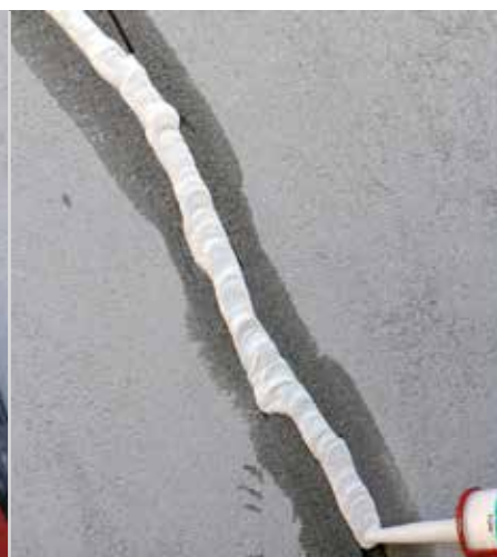
Fuga, zapolnjena z akrilnim kitom
