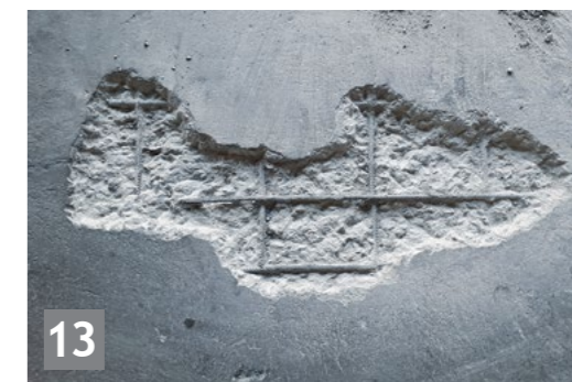
13 Ремонт і відновлення бетону
