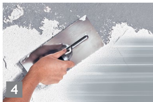
4 Декоративні фасадні штукатурки
