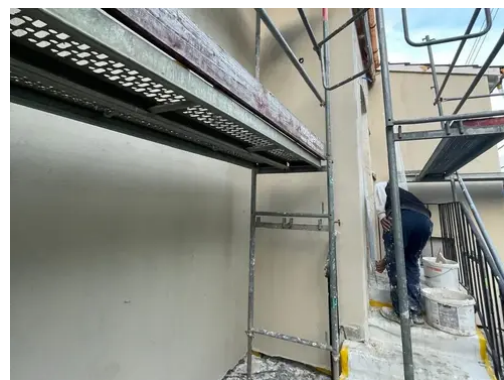
Travaux en cours
