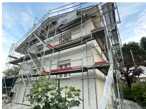
Travaux en cours
