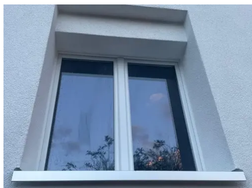
Fenêtre après travaux
