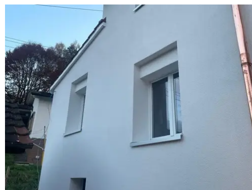
Façade après travaux
