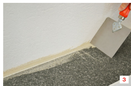
Contrôle de la surface de contact de collage
