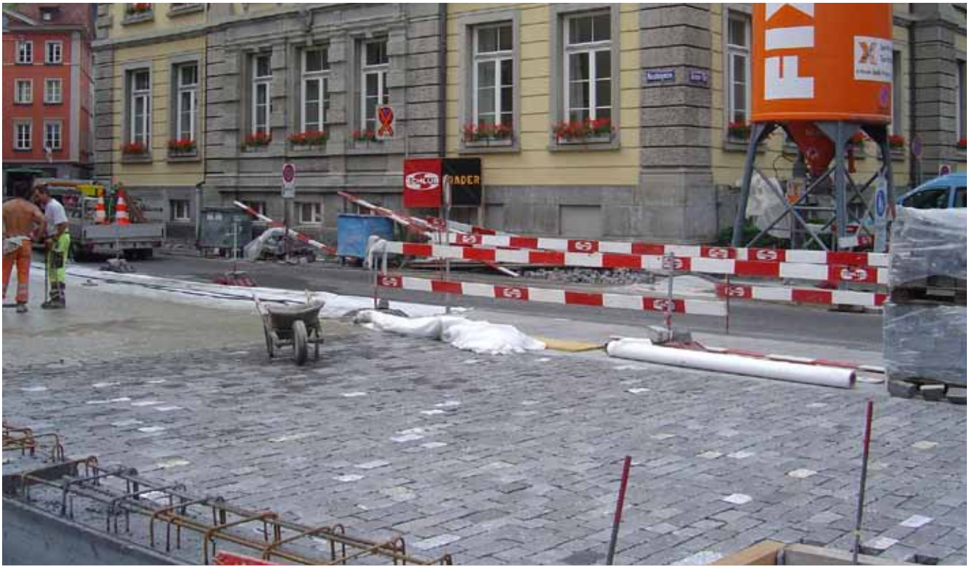
Neugestaltung Fontanaplatz, Chur Fixit 585 Vergussmörtel 0 – 3 mm, Frost- und Tausalzbeständigkeit hoch
