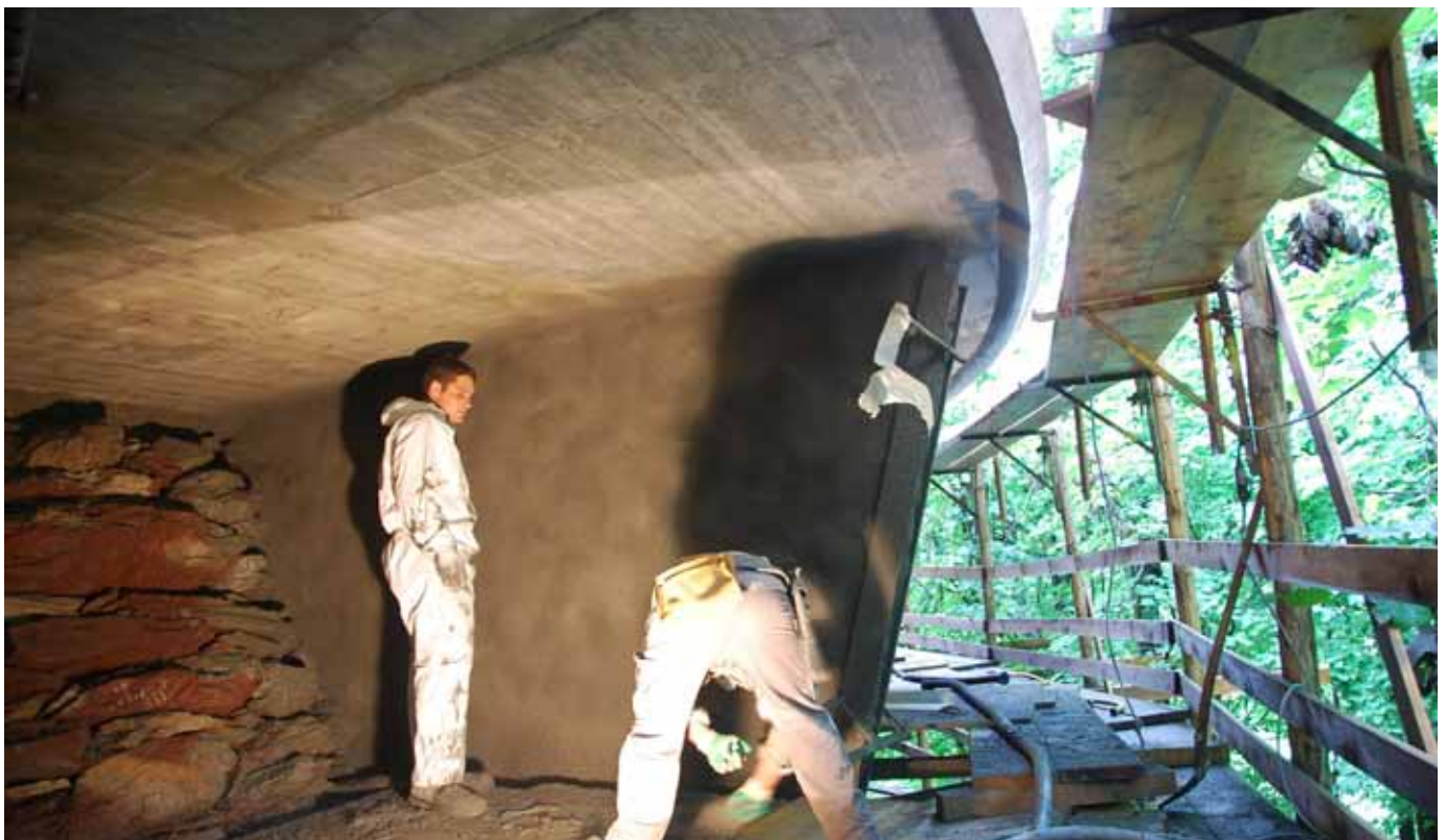
Lehnenbrücke, Flums Fixit 524 S Trockenspritzmörtel C30/37, silica vergütet, 0 – 4 mm
