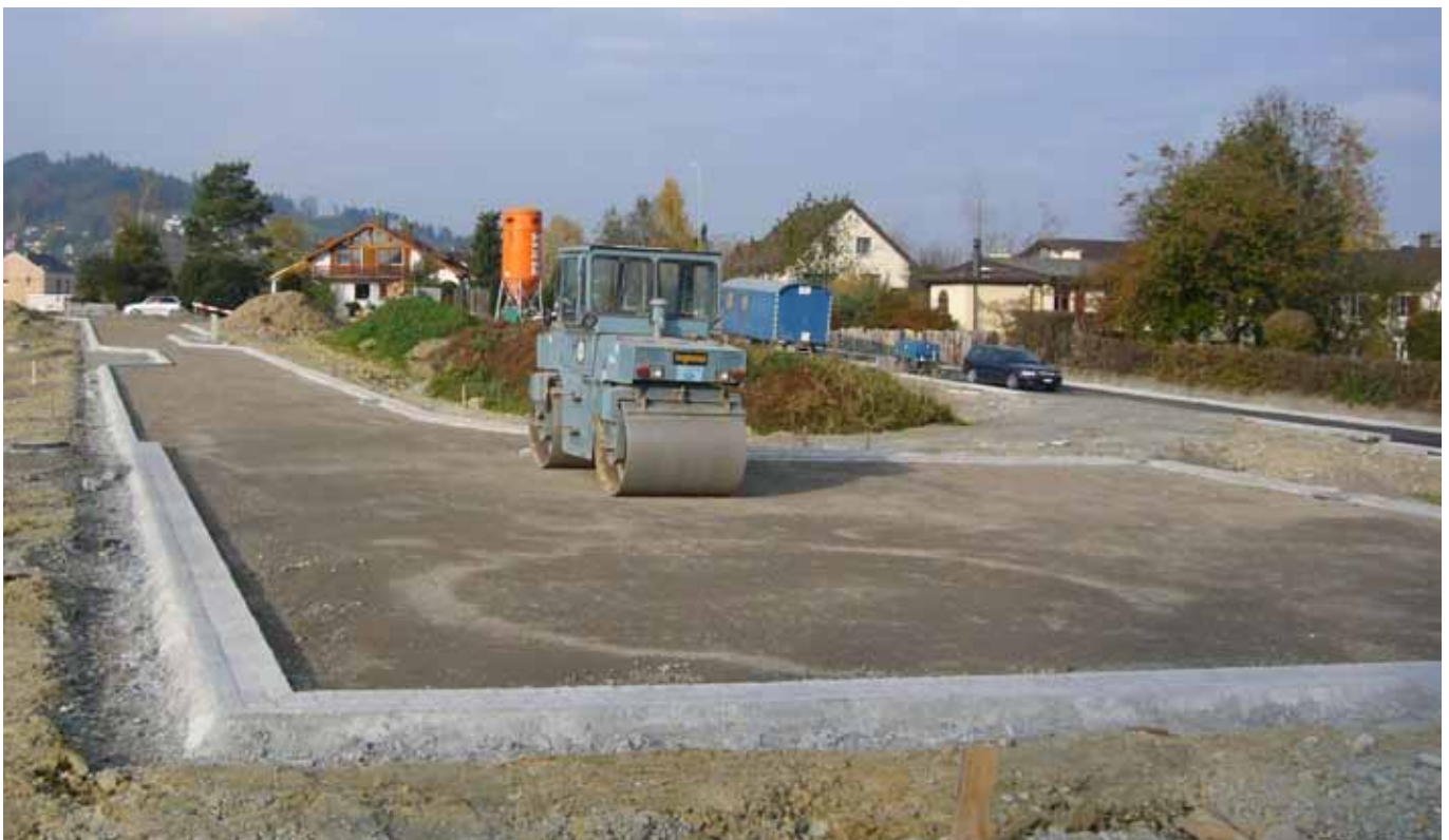
Erschließung Schiin, Uzwil Fixit 583 Bundsteinmörtel und Fixit 516 FT Trockenbeton C30/37, 0 – 16 mm
