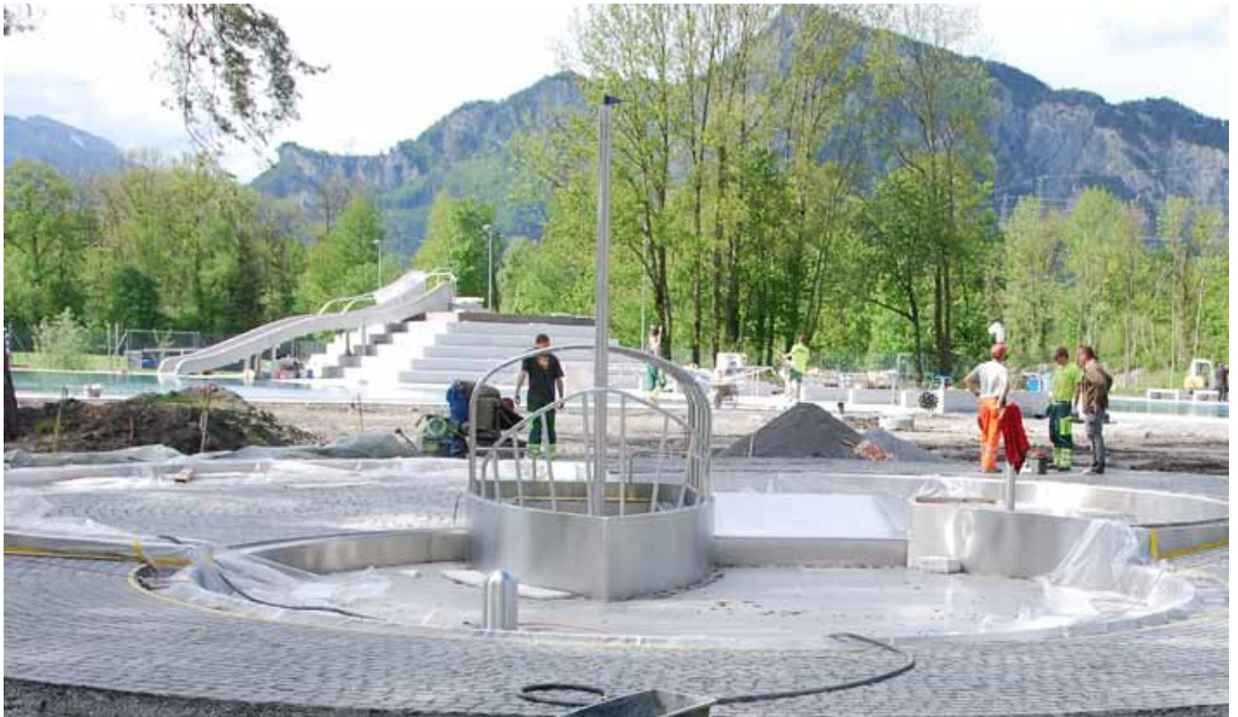
Giessenparkbad, Bad Ragaz Fixit 585 Vergussmörtel 0 – 3 mm und Fixit 583 Bundsteinmörtel 0 – 3 mm
