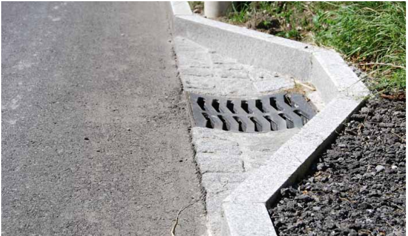
Schacht im Toggenburg Fixit 585 Vergussmörtel, Fixit 587 Schachtversetzmörtel
