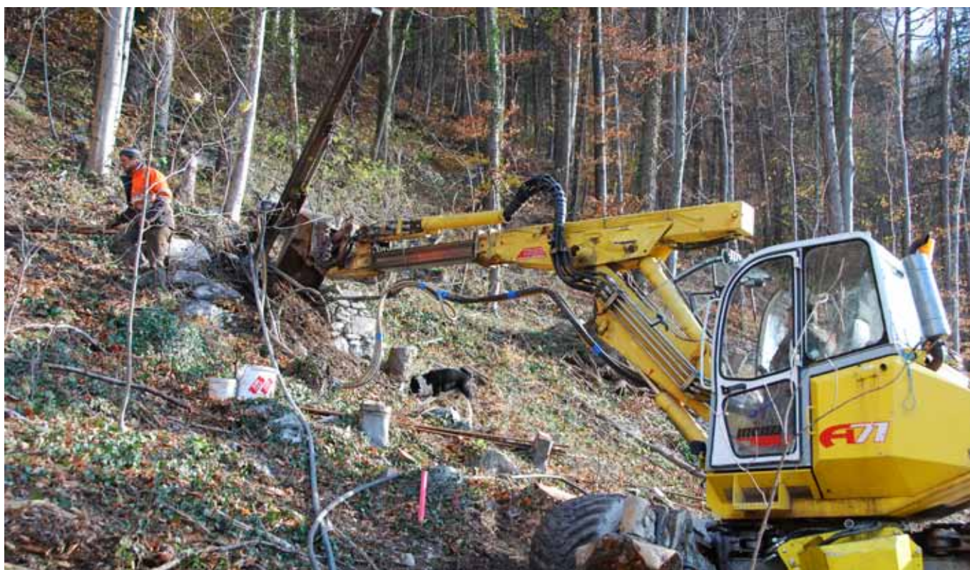
SSS Pasati, Sargans Fixit 532 Ankermörtel für Lawinerverbauungen
