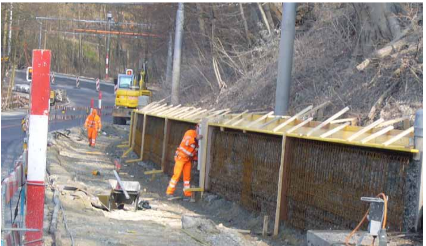
Mauersanierung Witikonstrasse, Zürich Fixit 528 A Trockenspritzbeton C30/37, alkalifrei beschleunigt, 0 – 8 mm
