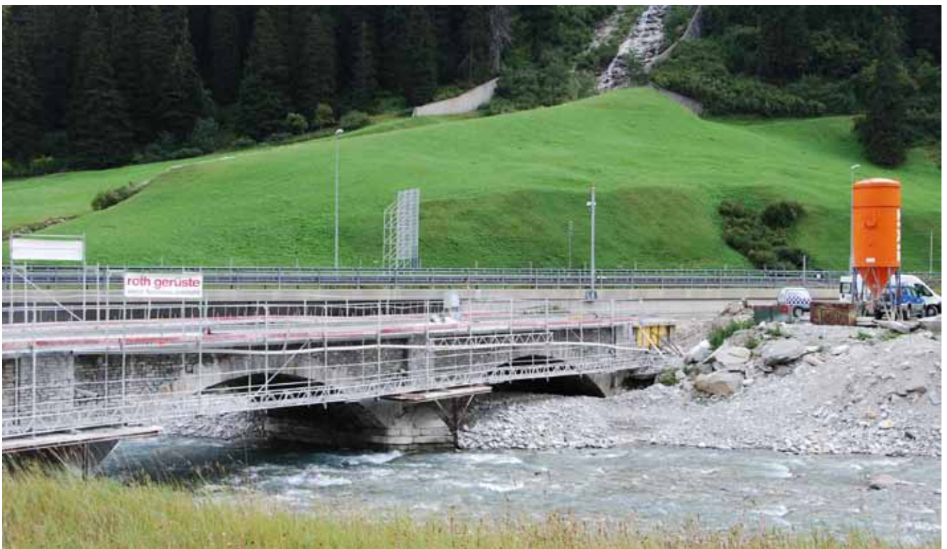
Hinterrheinbrücke Fixit 583 Bundsteinmörtel 0 – 3 mm, Frost- und Tausalzbeständigkeit hoch
