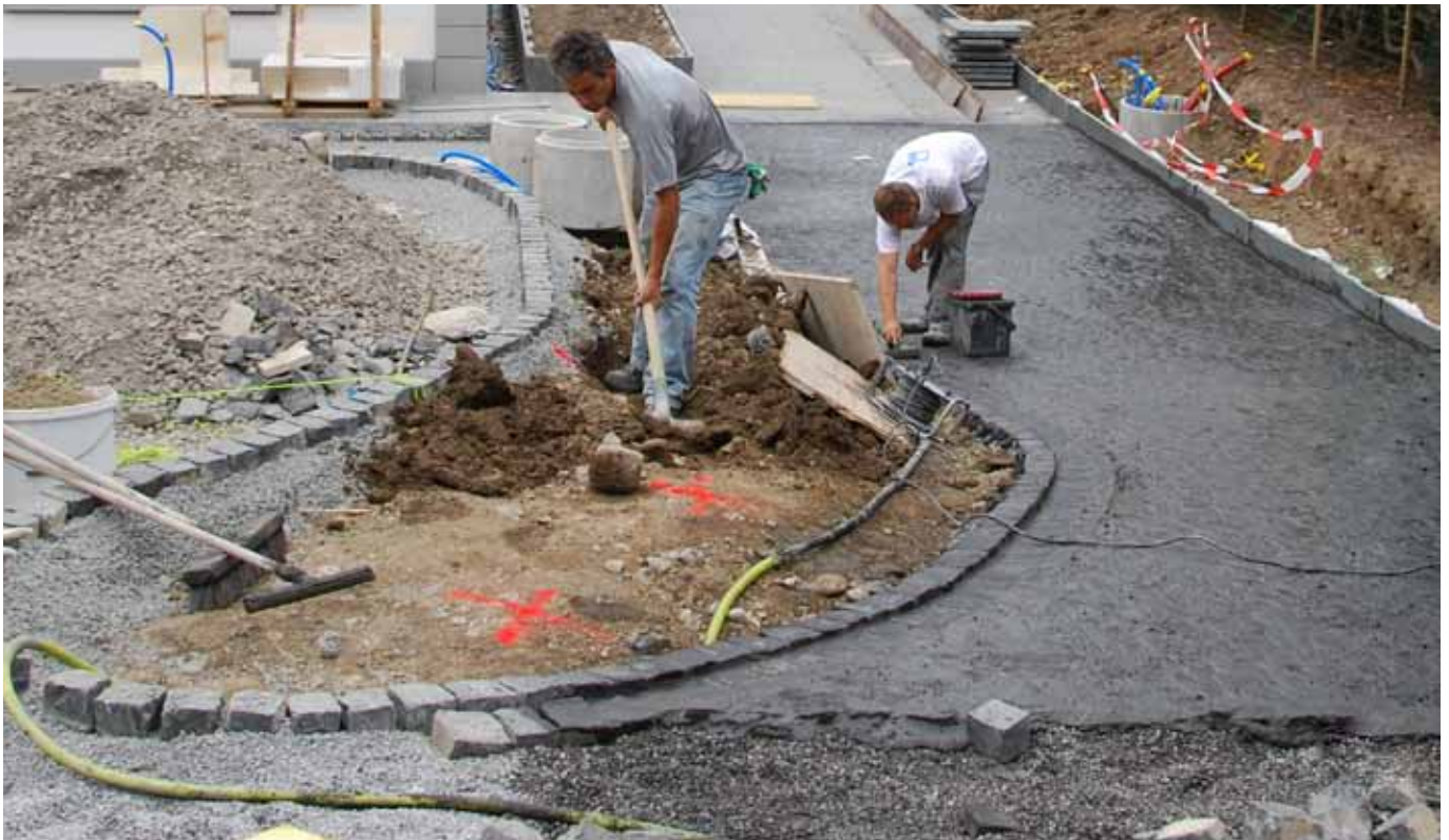
Gartenanlage Fixit 585 Vergussmörtel 0 – 3 mm schwarz eingefärbt
