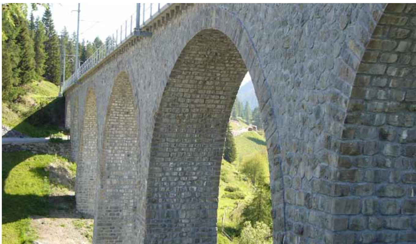
RhB Brücke Val-Susauna (Oberengadin) Fixit 560 Natursteinfugenmörtel 0 – 3 mm, frost- und tausalzbeständig
