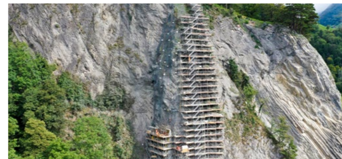
Stabilizácia skaly Axenstrasse, Sisikon UR
