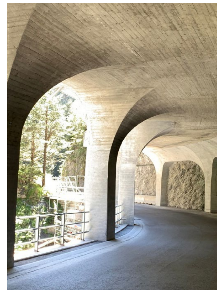
Rekonštrukcia galérie Viamala 1, Švajčiarsko
