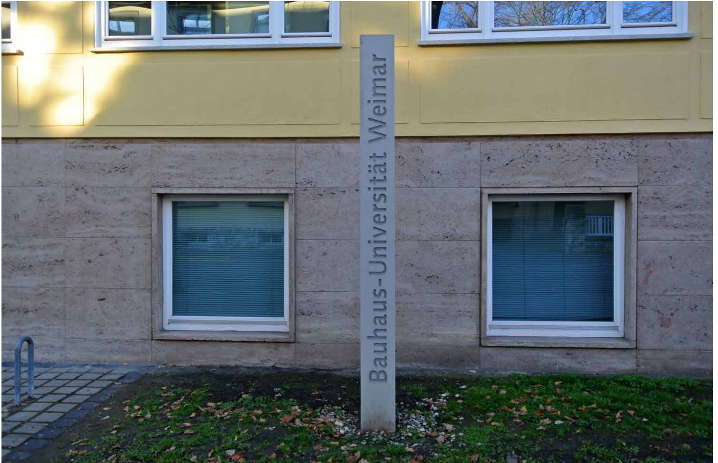
Trotz Fassadendämmung bleibt die ursprüngliche Optik des Gebäudes erhalten - dank Aerogel-Dämmputz
