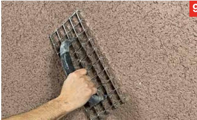
9. Nach dem Antrocknen wird der Fixit 793 Steinputz mit dem Schleifwunder in kreisenden Bewegungen gekratzt. Beim Kratzen darf kein Material am Werkzeug kleben bleiben.
