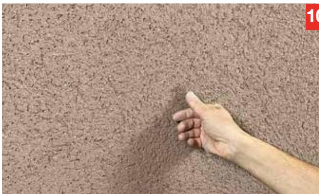
10. Die Ausbruchstellen können mit dem bereits abgekratzten Originalmaterial nachgebessert werden.
