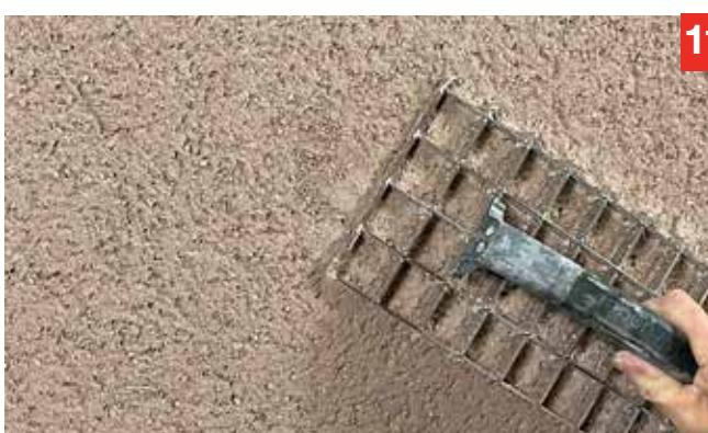
11. Die Ausbruchstellen können anschliessend gleichmässig gekratzt werden.
