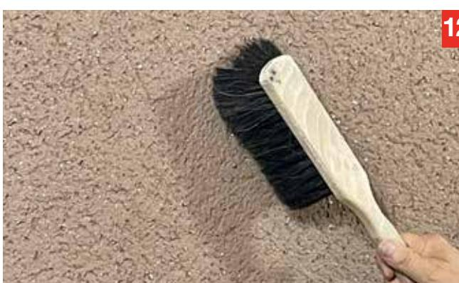
12. Nachdem der Putz komplett getrocknet ist, wird die Fassade abschliessend mit einem weichen Besen in kreisenden Bewegungen gereinigt.
