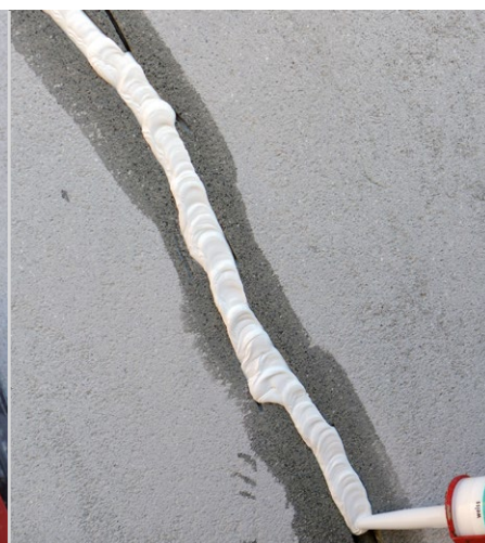
Fuge mit Acrylkitt füllen
