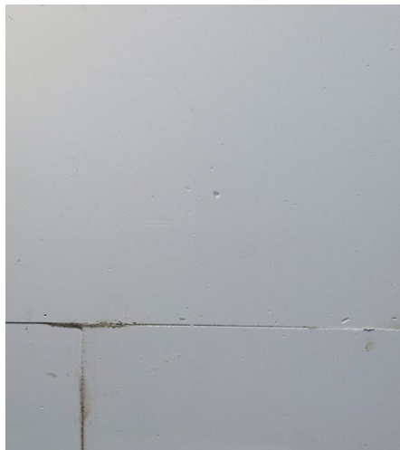
Fugen stumpf gestossen
