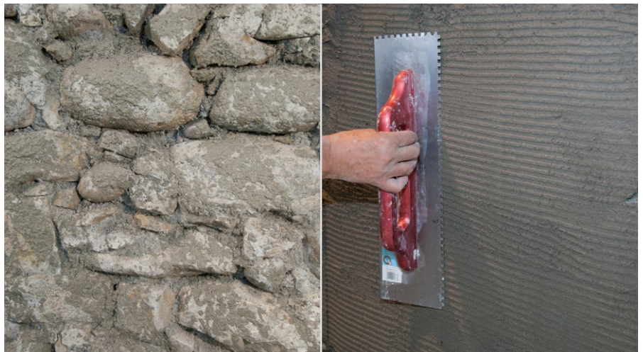
RÖFIX 671 Sanier-Vorspritzmörtel, 60 % deckend
