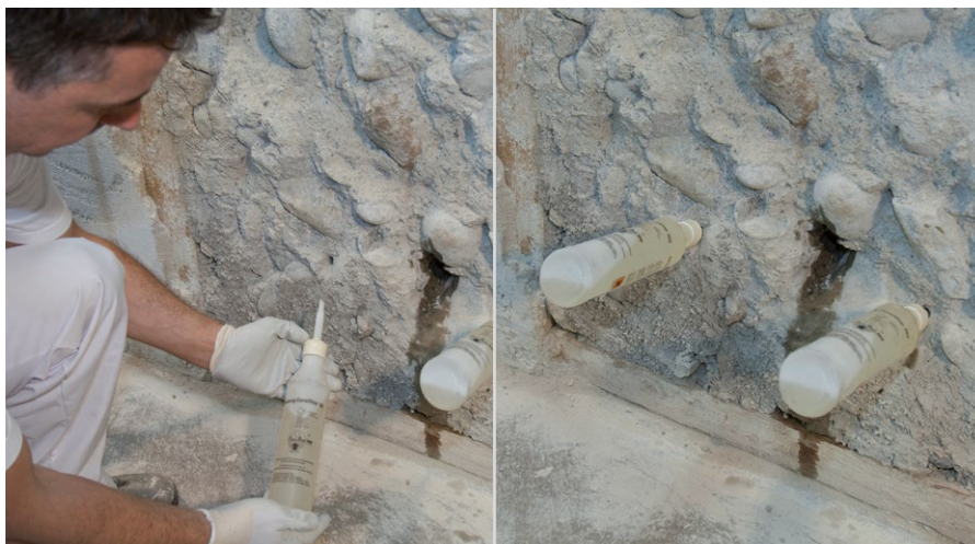
RÖFIX Cavastop 10–15 cm oberhalb des Bodens einbringen
