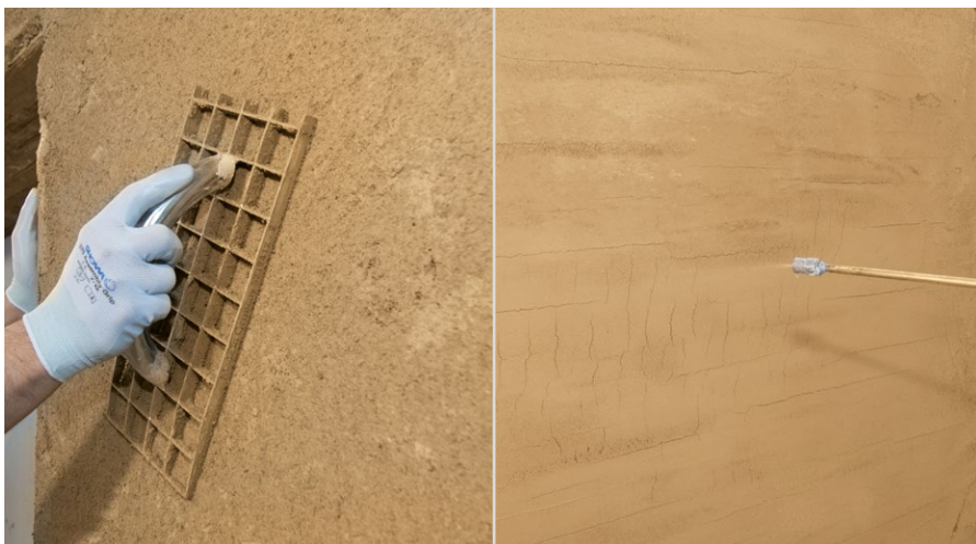
Plankratzen und vornässen von RÖFIX Geolehm®
