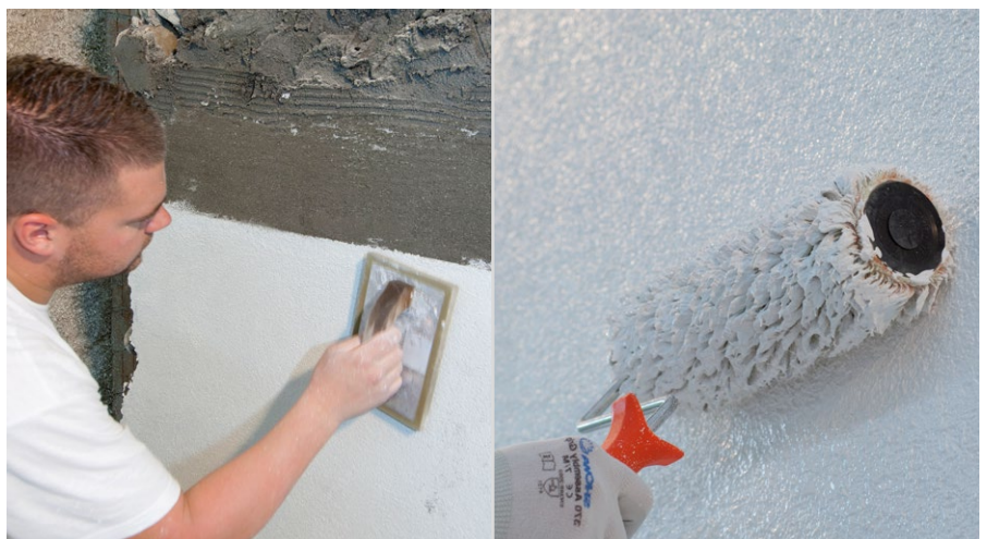
Abreiben und strukturieren des RÖFIX 340/341
