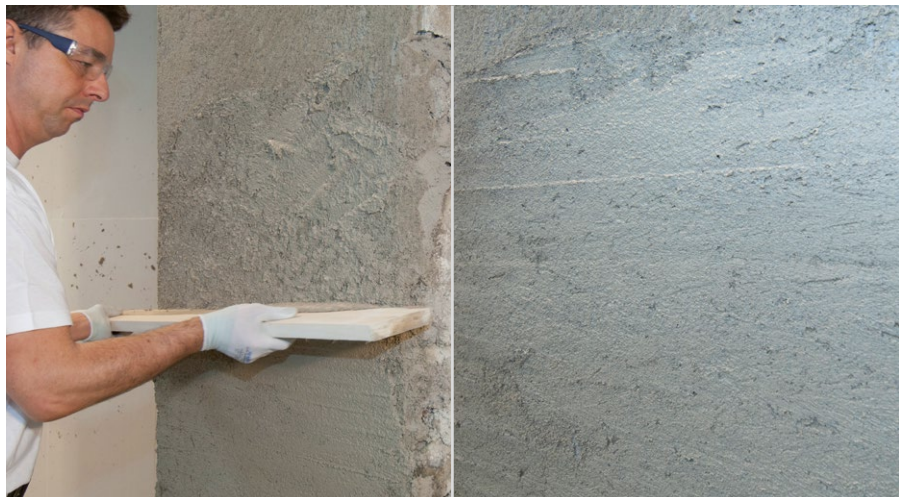
Abschweissen/Abziehen des Kalkputzes
