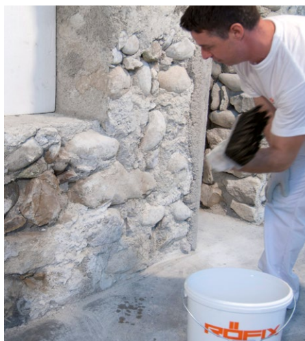
Anwurf RÖFIX Saniergrund mittels Malerbürste
