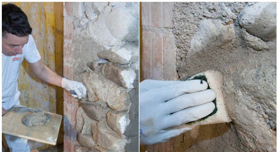
Natursteinmauerwerk ausfugen
