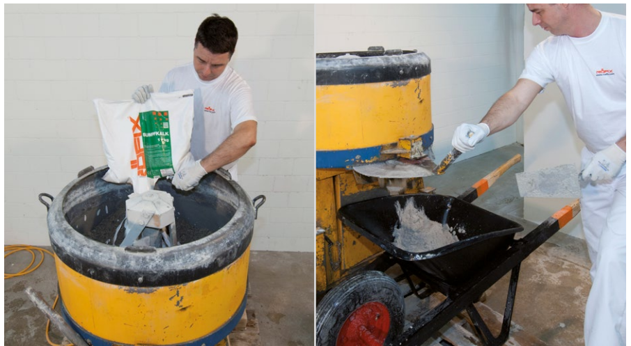
Anmischung des Baukasten-Systems
