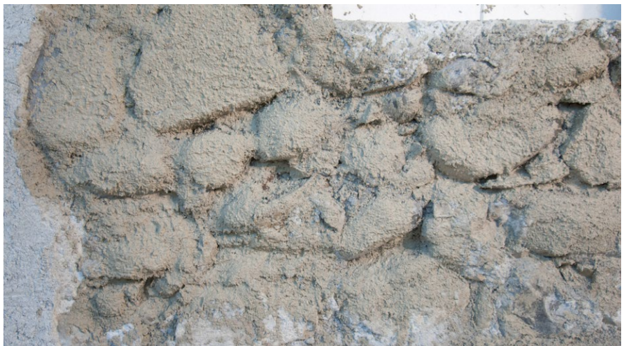
Griffige Oberfläche für nächste Putzlage
