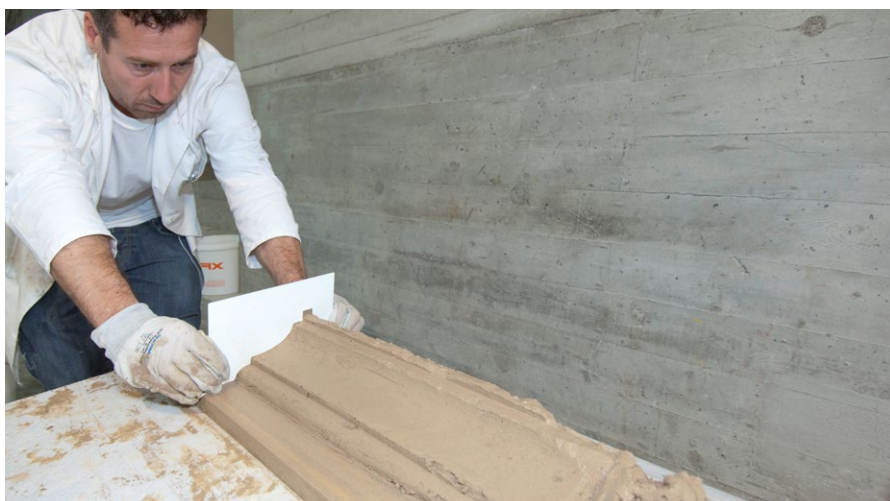
Abziehen von Zugprofilen mit Schablone
