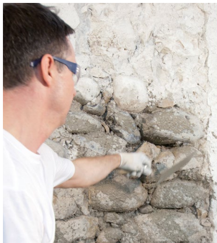
Anwurf mit RÖFIX 671 Sanier-Vorspritzmörtel, 60% deckend
