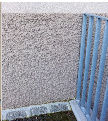
Sichtbarer Sockel-Fassaden-Übergang
