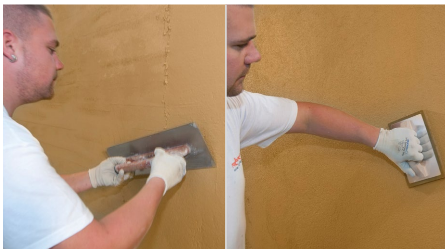
Auftrag der Feinputz-Schicht
