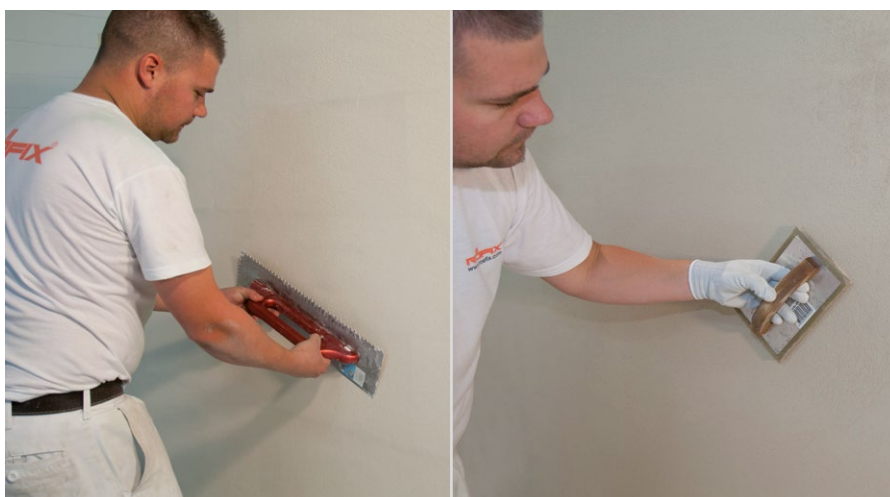
Auftrag des mineralischen Oberputzes RÖFIX CalceClima® Fino
