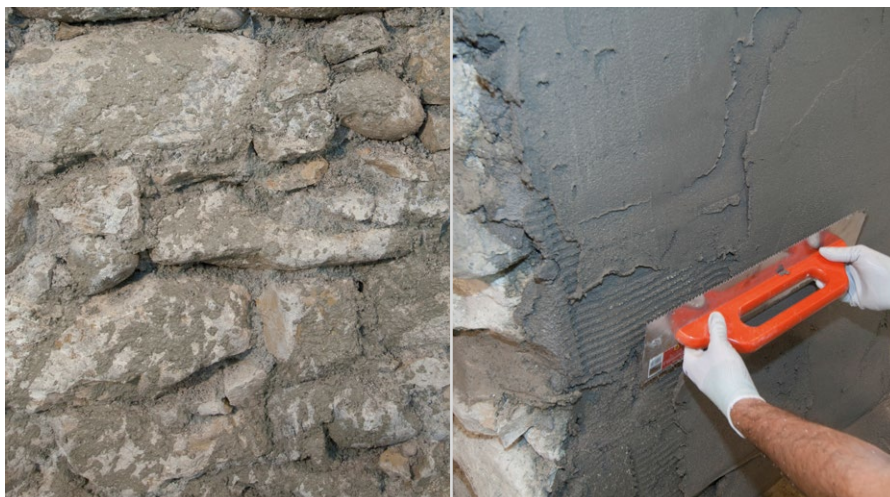
RÖFIX 671 Sanier-Vorspritzmörtel, 60 % deckend
