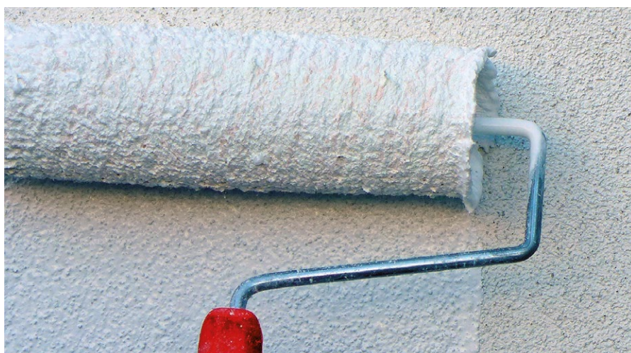
RÖFIX Fassadenfarbe auftragen
