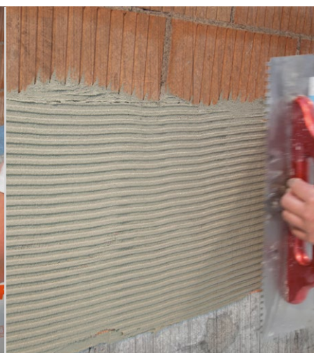
Armierspachtelung über Rissband
