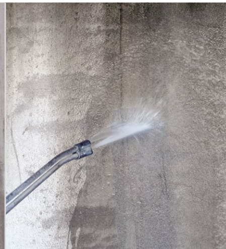
Fassadenputz nass reinigen
