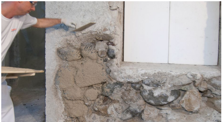
Anwerfen des Vorspritzmörtels
