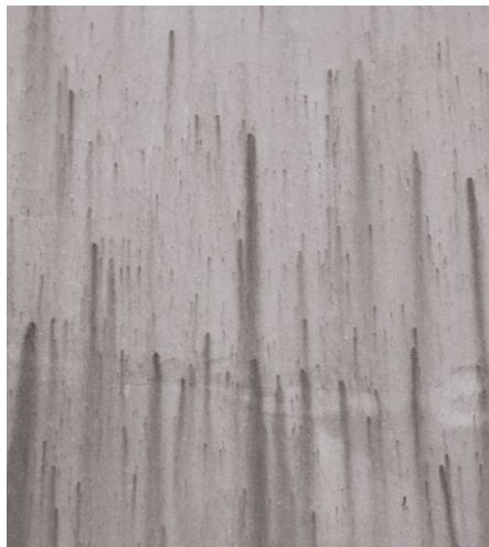
Algen-/pilzbefallener Fassadenputz
