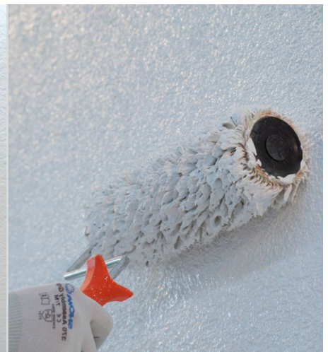
Beschichten mit dampfdiffusionsoffenen Farben
