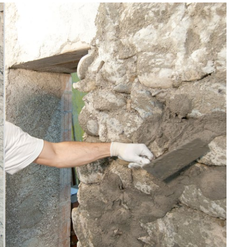
Stopfen/Anwerfen mit RÖFIX 648 Porengrundputz
