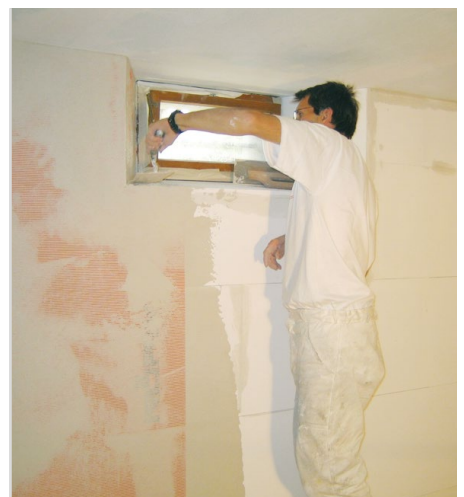
Montage mit RÖFIX Renopor® Anpasskeil
