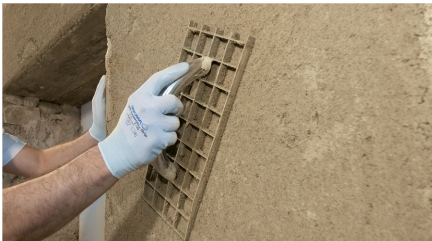
Plankratzen von RÖFIX CalceClima® Ambiente mit RÖFIX Schleifwunder
