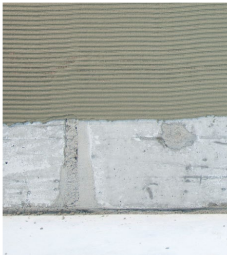
RÖFIX Haftbeschichtung auf Beton
