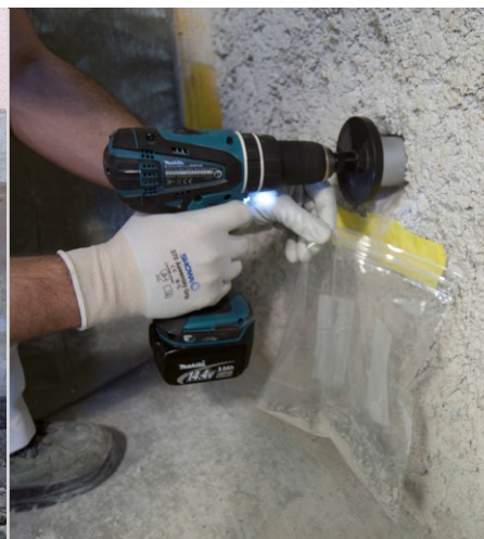
Putz auf Salzbelastung prüfen
