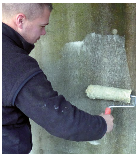
RÖFIX Algenkiller auftragen
