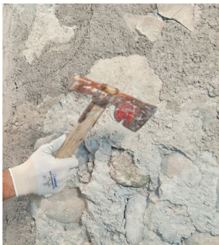
Abschlagen des Altputzes
