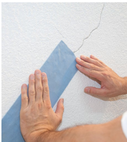
RÖFIX Rissband anbringen
