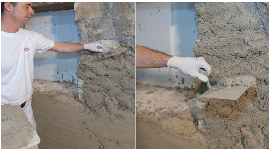
Auftragen des Kalkputzes
