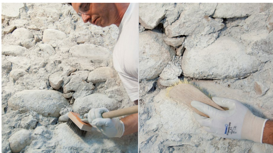
Freilegen und reinigen des Mauerwerks
