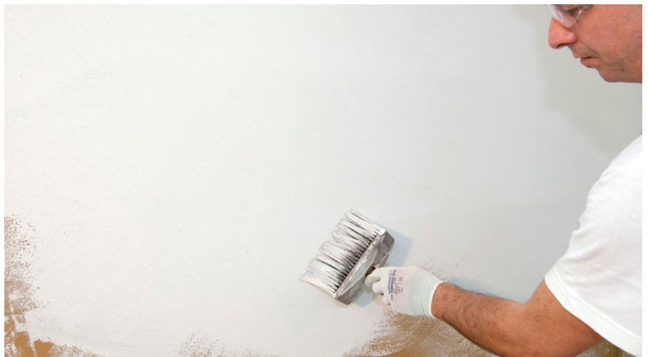
Bürstenauftrag in Fresco-Technik
