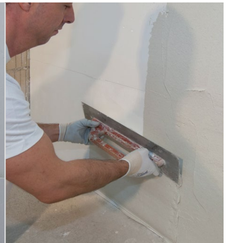
Armieren mit RÖFIX Renopor® Spezial-Klebspachtel
