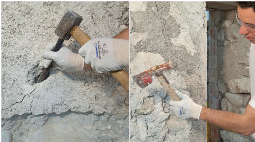
Abschlagen des Altputzes
