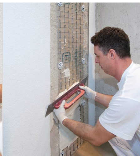
Rissbrücke (RÖFIX Stucanet) überarbeiten
