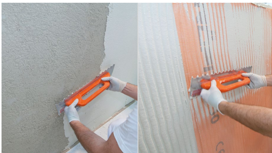
Armierung der Dämmputz-Schicht
