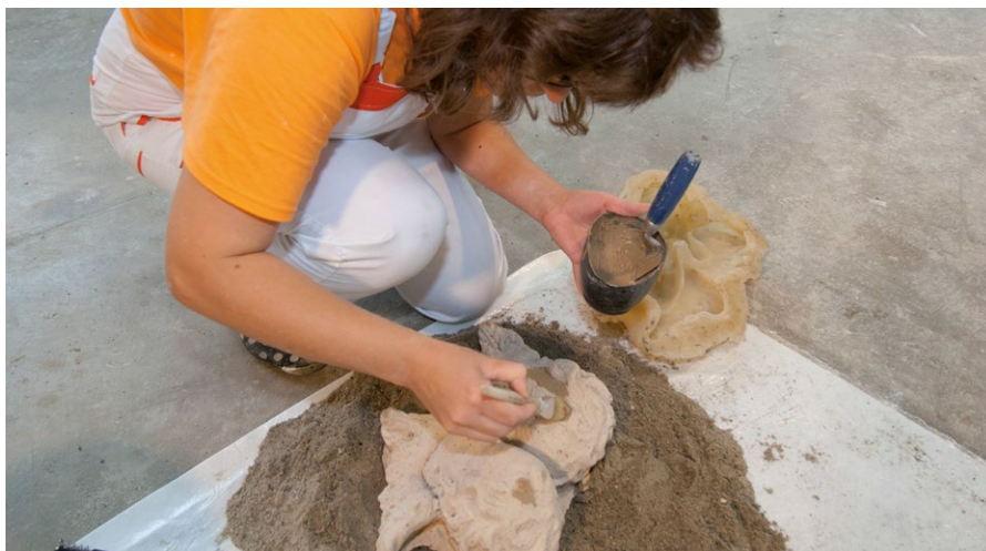
Überarbeiten von Gussteilen mit RÖFIX Belit Feinschlämme
