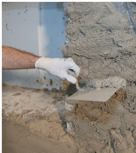
Auftragen des RÖFIX 697
