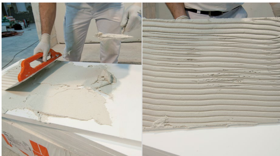
Vollflächig kleben mit RÖFIX Renopor® Spezial-Klebspachtel
