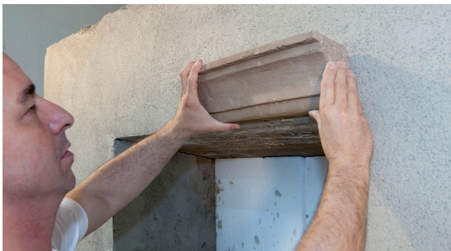
Montage von Dekorprofilen
