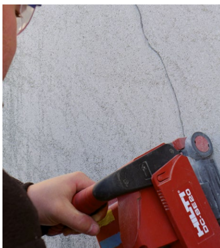
Kerbriss auffräsen
