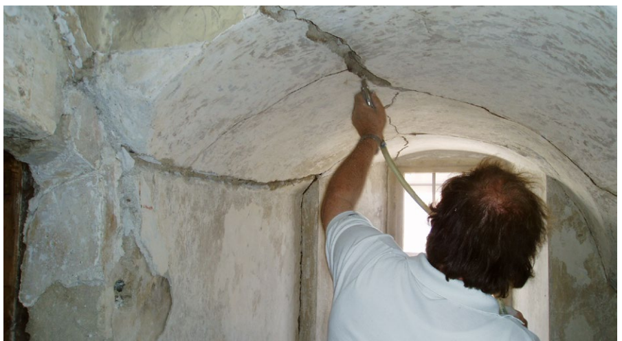
Auffüllen von Putzrissen
