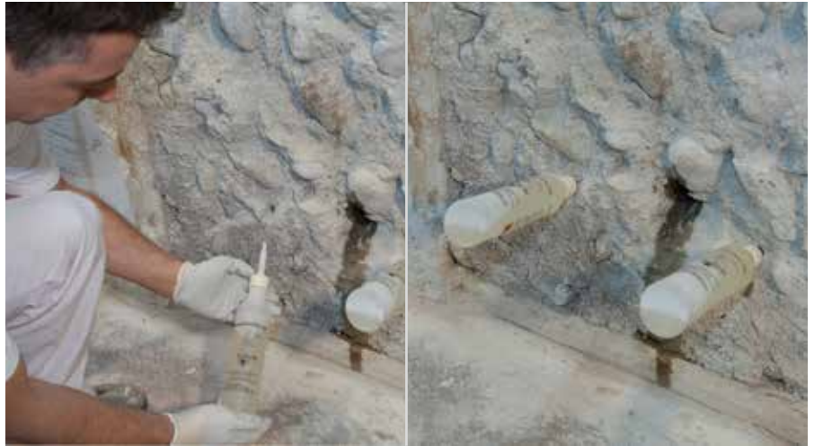
RÖFIX Cavastop 10–15 cm oberhalb des Bodens einbringen
