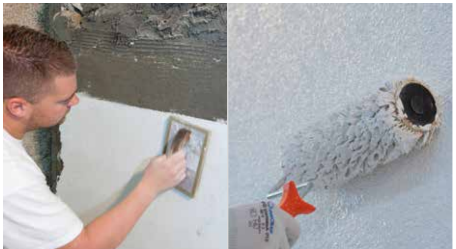
Abreiben und strukturieren des RÖFIX 340/341
