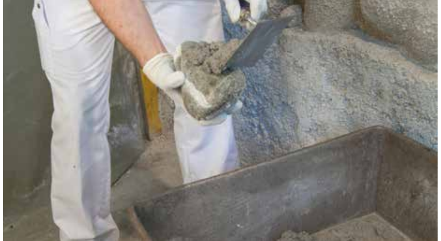
Schliessen von Fehlstellen
