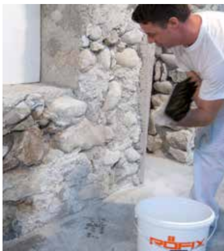
Anwurf RÖFIX Saniergrund mittels Malerbürste
