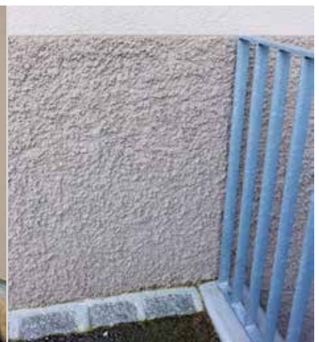
Sichtbarer Sockel-Fassaden-Übergang
