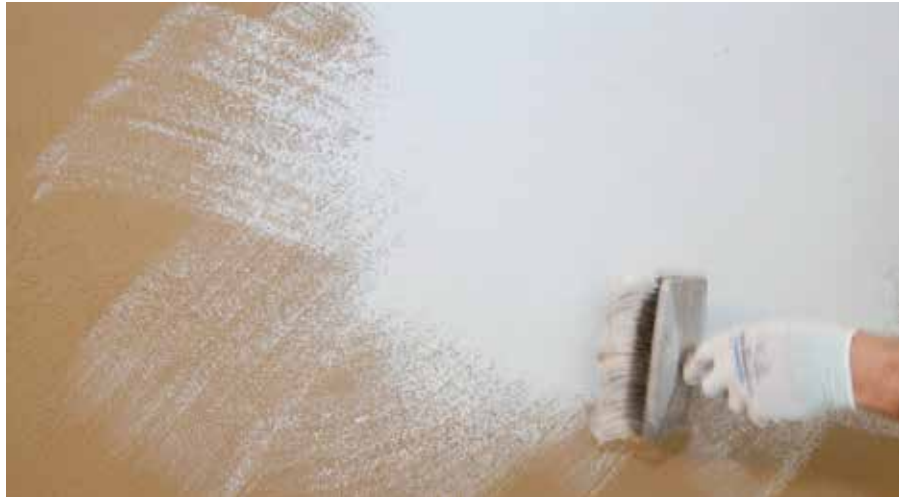
Kreuzschlag-Aufbringung mittels Malerbürste
