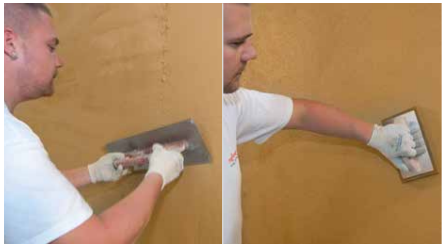
Auftrag der Feinputz-Schicht
