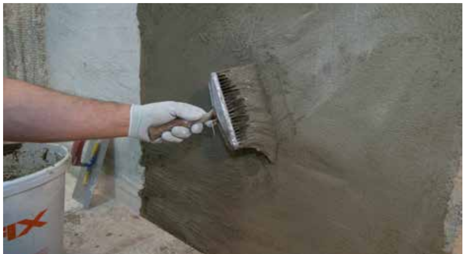
RÖFIX 636 Dichtungsschlämme mit max. 3 mm Schichtdicke auf RÖFIX 635 aufbringen
