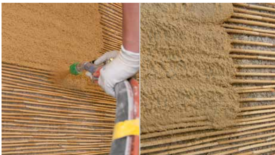
Auftragen von RÖFIX Geolehm®
