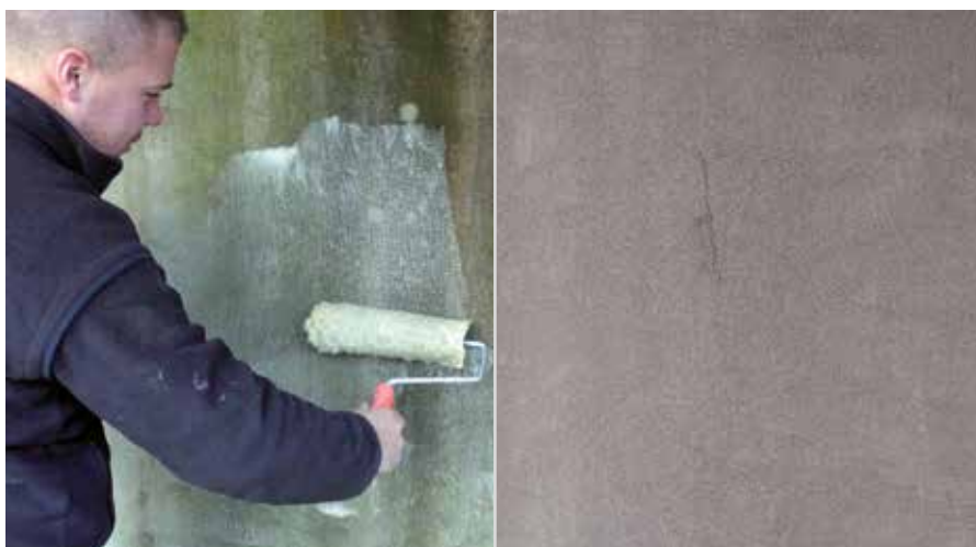
RÖFIX Algenkiller auftragen
