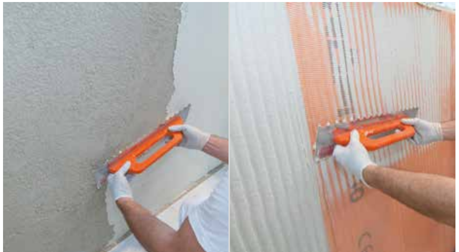
Armierung der Dämmputz-Schicht
