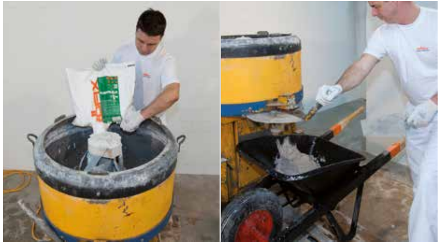
Anmischung des Baukasten-Systems
