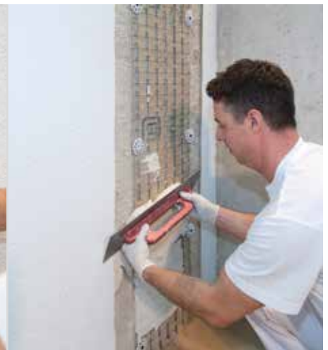
Rissbrücke (RÖFIX Stucanet) überarbeiten
