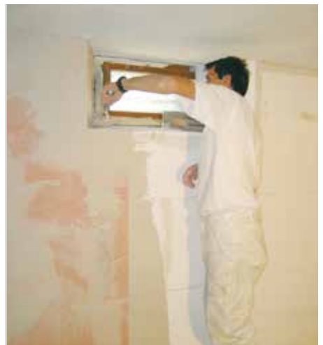
Montage mit RÖFIX Renopor® Anpasskeil
