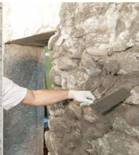
Stopfen/Anwerfen mit RÖFIX 648 Porengrundputz
