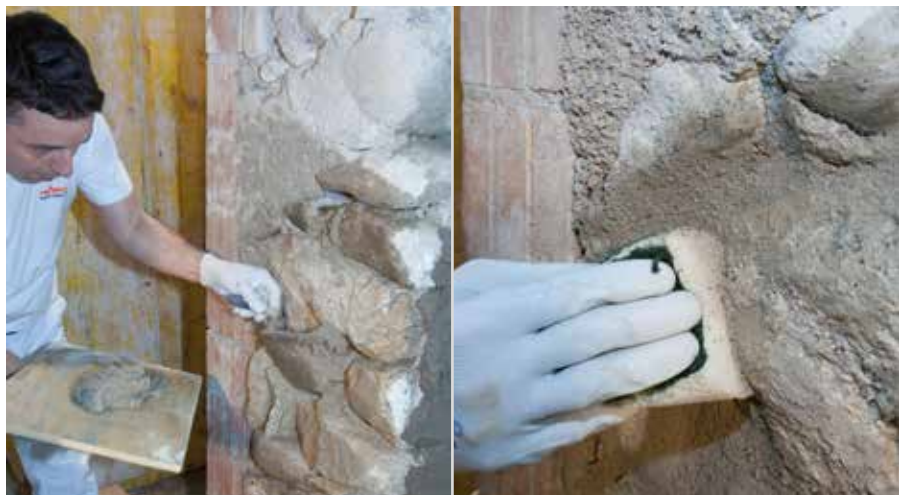
Natursteinmauerwerk ausfugen
