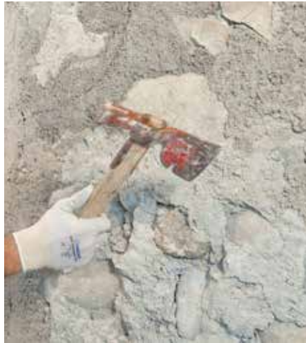
Abschlagen des Altputzes
