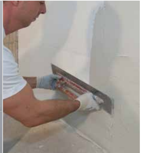
Armieren mit RÖFIX Renopor® Spezial-Klebspachtel
