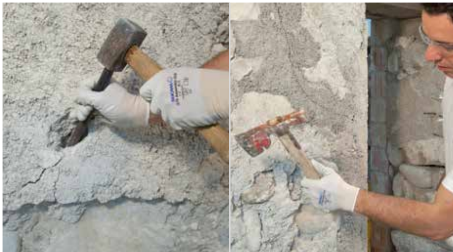
Abschlagen des Altputzes
