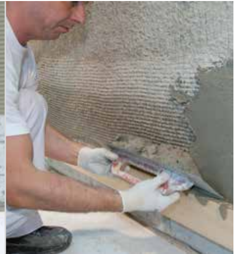
RÖFIX Sockelputz auf Backstein
