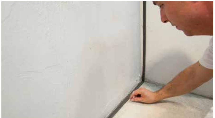
Montage des RÖFIX Dichtungsbandes an Wand- und Deckenanschlüssen
