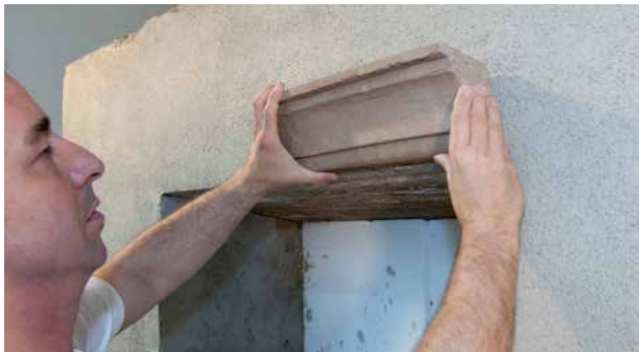
Montage von Dekorprofilen
