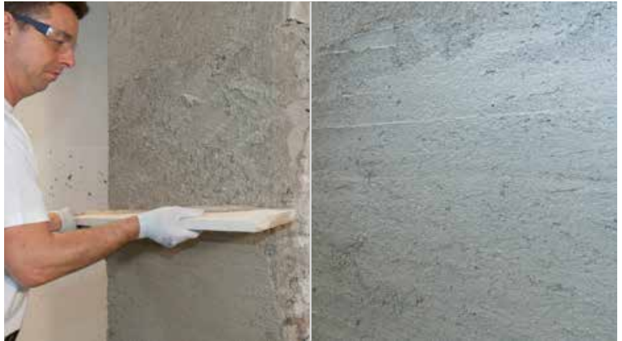
Abschweissen/Abziehen des Kalkputzes
