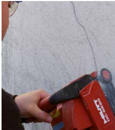
Kerbriss auffräsen
