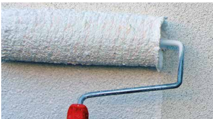
RÖFIX Fassadenfarbe auftragen
