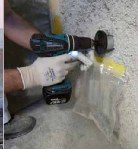
Putz auf Salzbelastung prüfen
