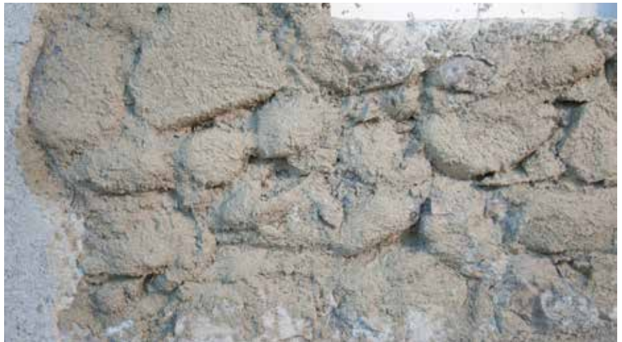
Griffige Oberfläche für nächste Putzlage
