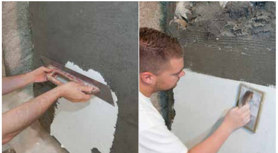
Aufziehen des RÖFIX 340/341
