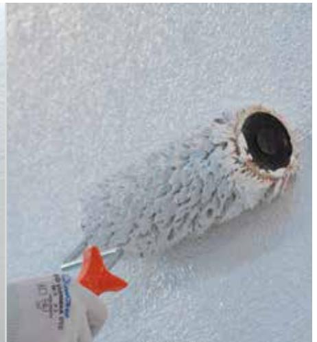
Beschichten mit dampfdiffusionsoffenen Farben
