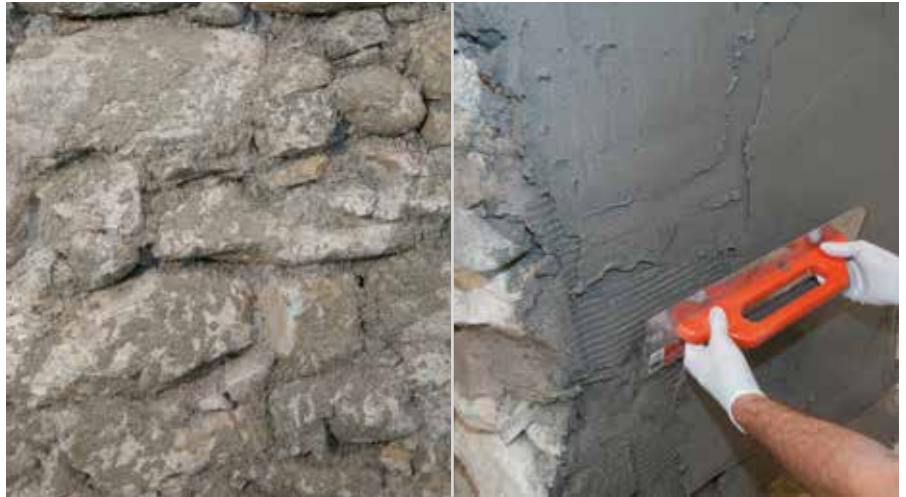
RÖFIX 671 Sanier-Vorspritzmörtel, 60 % deckend
