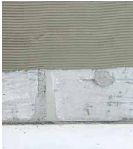
RÖFIX Haftbeschichtung auf Beton
