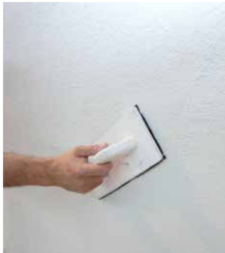
Strukturieren mit RÖFIX Renopor® Spezial-Klebspachtel
