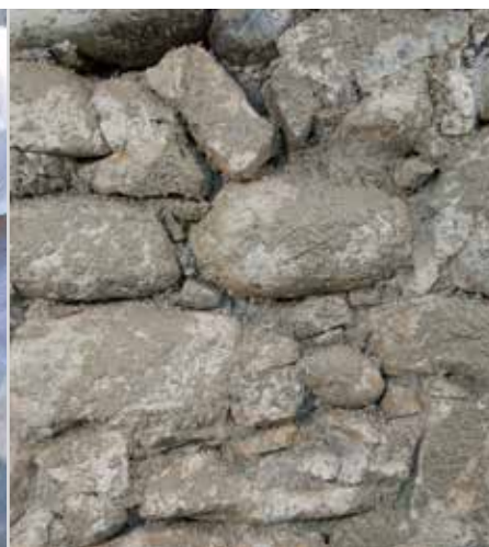
RÖFIX 671 Sanier-Vorspritzmörtel, 60% deckend
