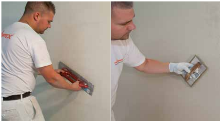
Auftrag des mineralischen Oberputzes RÖFIX CalceClima® Fino
