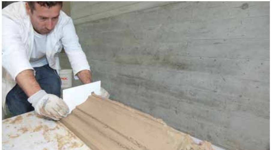
Abziehen von Zugprofilen mit Schablone
