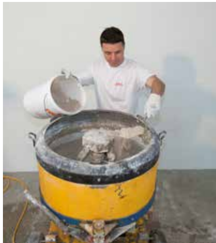
Sand und NHL einfüllen
