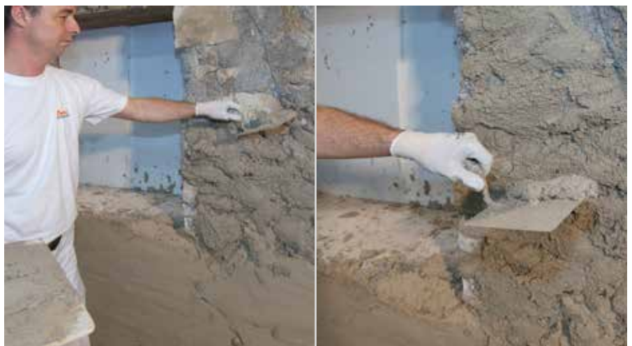
Auftragen des Kalkputzes
