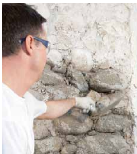
Anwurf mit RÖFIX 671 Sanier-Vorspritzmörtel, 60% deckend
