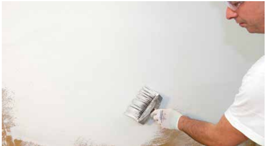
Bürstenauftrag in Fresco-Technik
