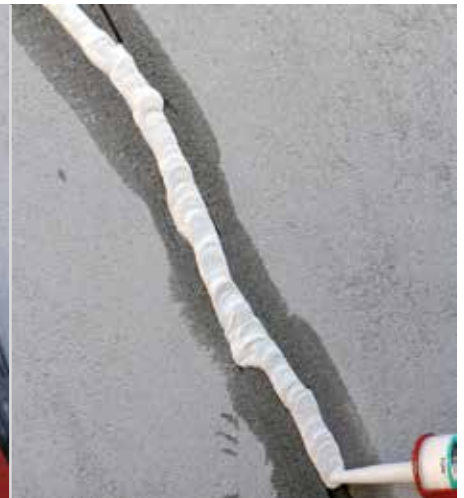
Fuge mit Acrylkitt füllen
