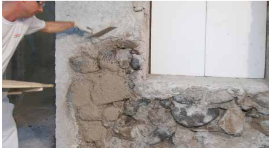
Anwerfen des Vorspritzmörtels
