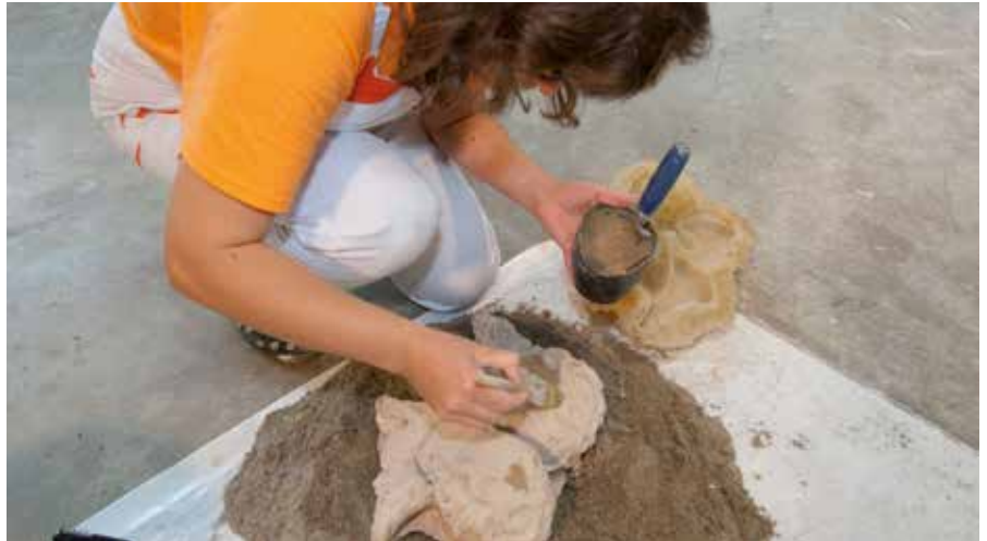
Überarbeiten von Gussteilen mit RÖFIX Belit Feinschlämme
