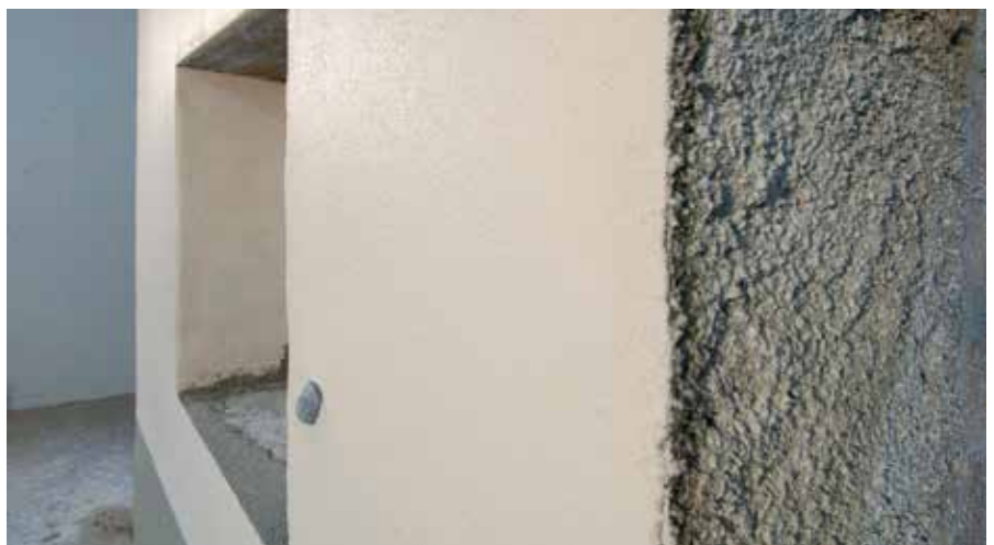
Aufbringen des Oberputzes (RÖFIX 380)
