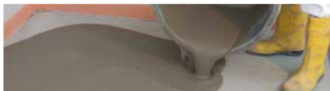
Нанасяне на саморазливна смес
