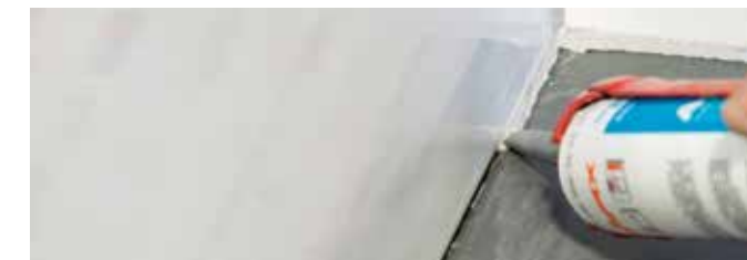
Уплътняване със силикон
