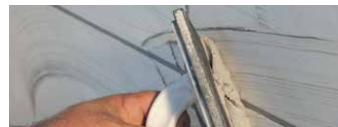
Запълване на fugите
