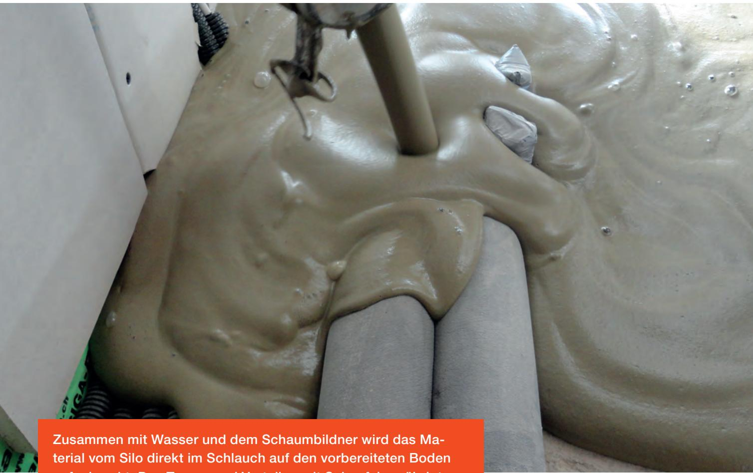
Zusammen mit Wasser und dem Schaumbildner wird das Material vom Silo direkt im Schlauch auf den vorbereiteten Boden aufgebracht. Das Tragen und Verteilen mit Schaufeln erübrigt sich, weil sich der RÖFIX POR® Schaummörtel mit seiner dünnen Konsistenz einfach und mühelos mit hoher Einbauleistung ausgleicht.
