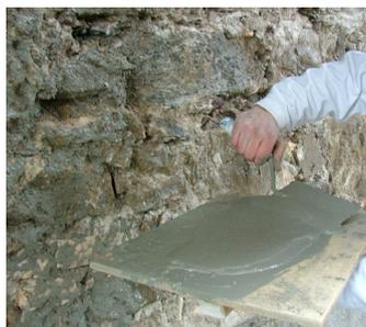
Anwurf mit Fixit 211 Zementmörtel mit Haftzusatz
