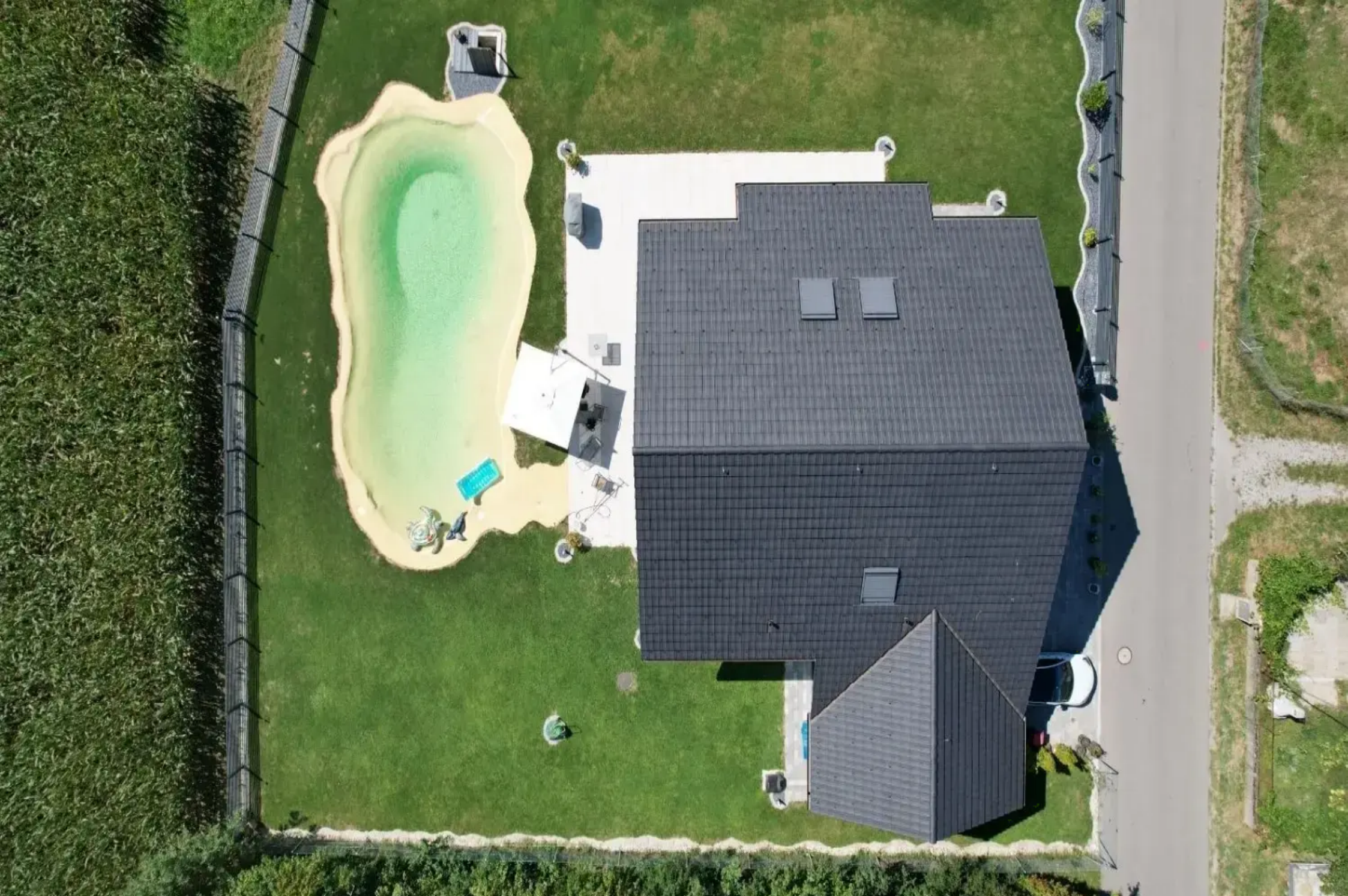
Piscine béton projeté Mettlen
