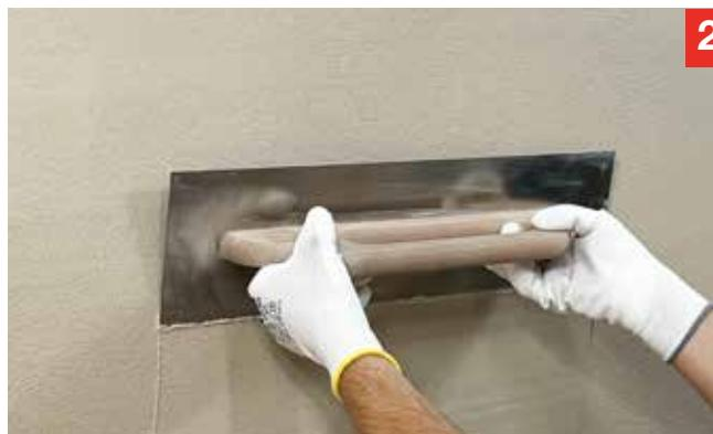
2. Après le séchage de la couche de base, éventuellement poncer les coups de truelle et appliquer le crépi décoratif Fixit 745 comme crépi de finition avec une épaisseur de grain et de couche d'environ 1,5 mm.
