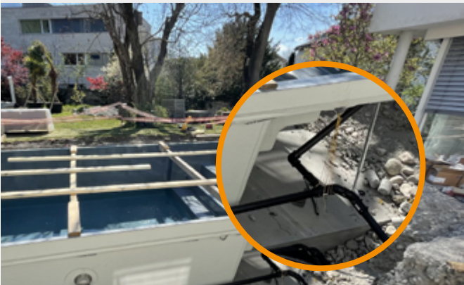
Sicherung der Stützen gegen Auftrieb
