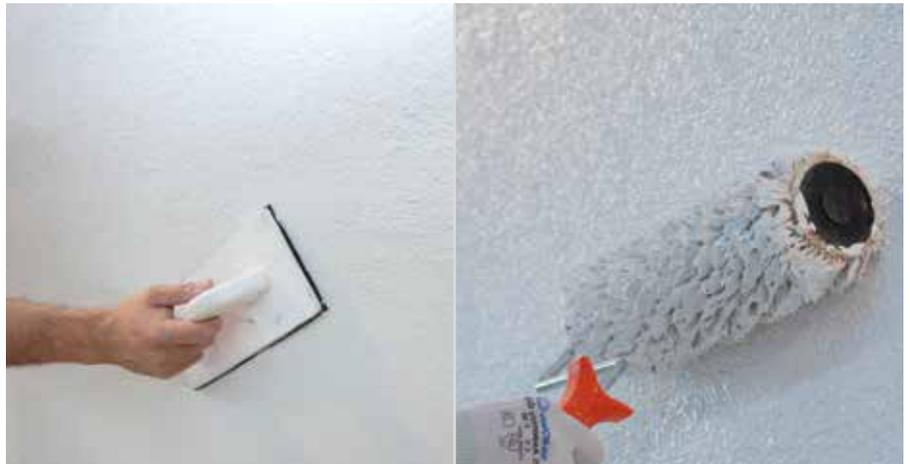
Structurer avec RÖFIX Renopor® Mortier-colle et réagréage spécifique
