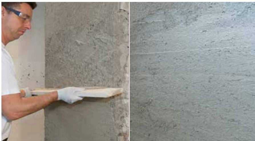
Nivellement/préparation de l'enduit à base de chaux pour le rendre rugueux | Surface rugueuse
