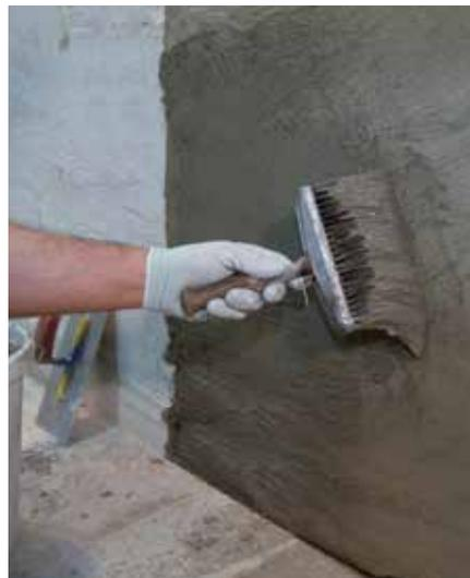
RÖFIX 636 Mortier osmotique imperméabilisant est une masse minérale imperméabilisante pour l'imperméabilisation de réservoirs, piscines, éléments de construction souterrains, installations d'épuration, tuyauteries, canaux de chauffage (min. B225/B25 jusqu'à 5 m de colonne d'eau).
