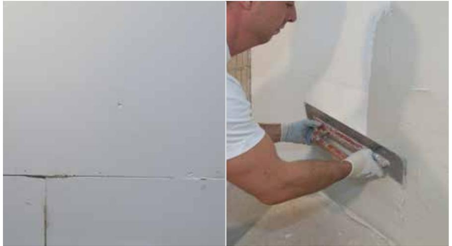
Joints raccordés bout à bout | Ragréage avec RÖFIX Renopor® Mortier-colle et réagréage spécifique
