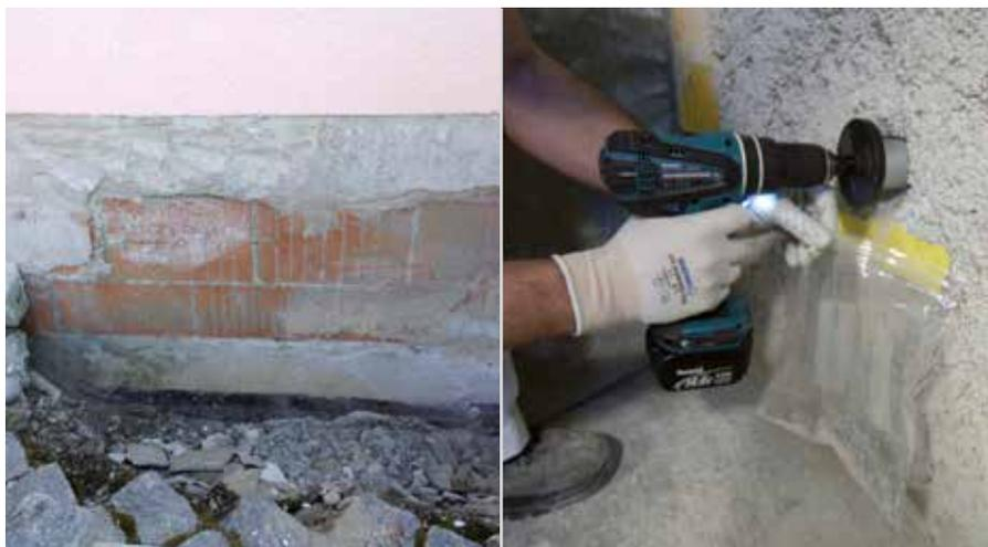
Domage du soubassement due à une stagnation      Essai de l'enduit à contenu salin
