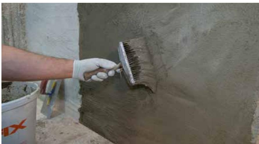
Appliquer RÖFIX 636 Mortier osmotique imperméabilisant d'une épaisseur max. de 3 mm sur RÖFIX 635
