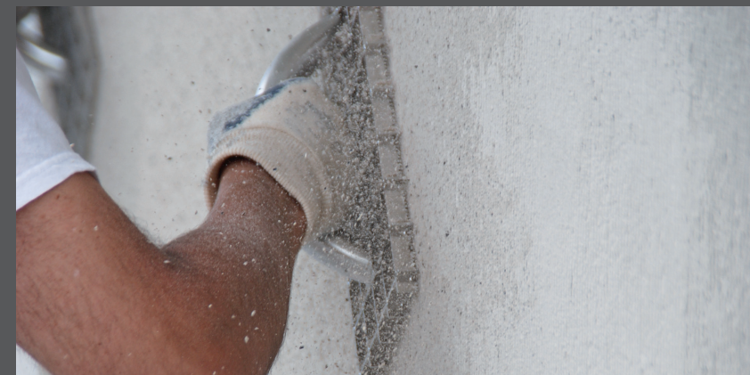
Die Oberfläche mit einem RÖFIX Schleifwunder abkratzen
