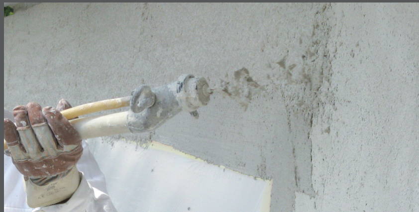
Der zweite Auftrag erfolgt nach Antrocknung der ersten Putzlage
