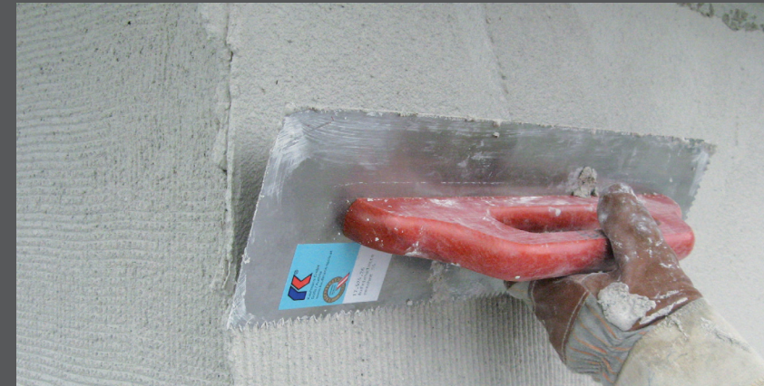
Mit der RÖFIX S6 Spitzzahntraufel die Oberfläche entlüften
