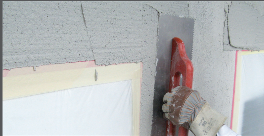
Der Auftrag der ersten Lage in Kornstärke
