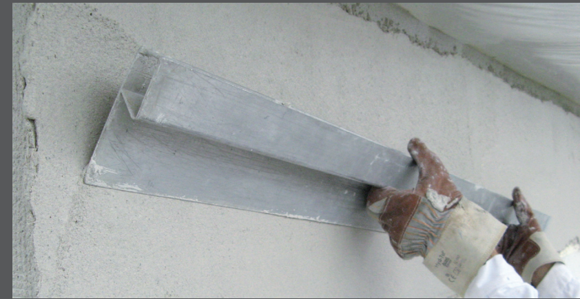
Mittels Abziehlatte die Oberfläche planeben abziehen
