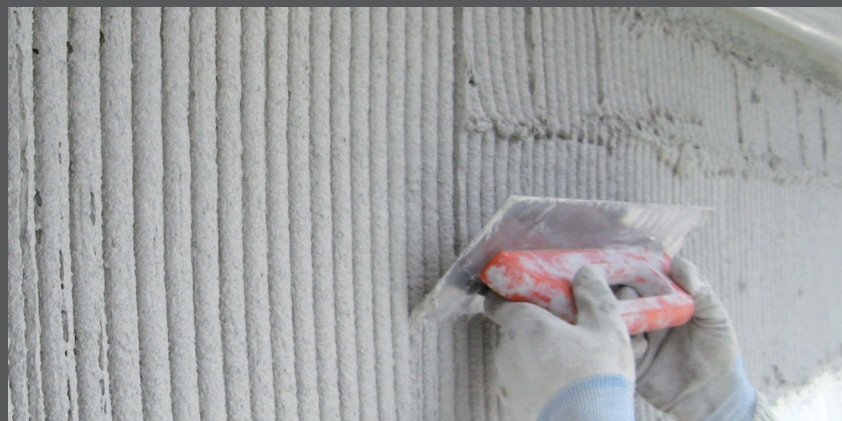
Mit der RÖFIX R16 Zahntraufel in einer Richtung durchkämmen
