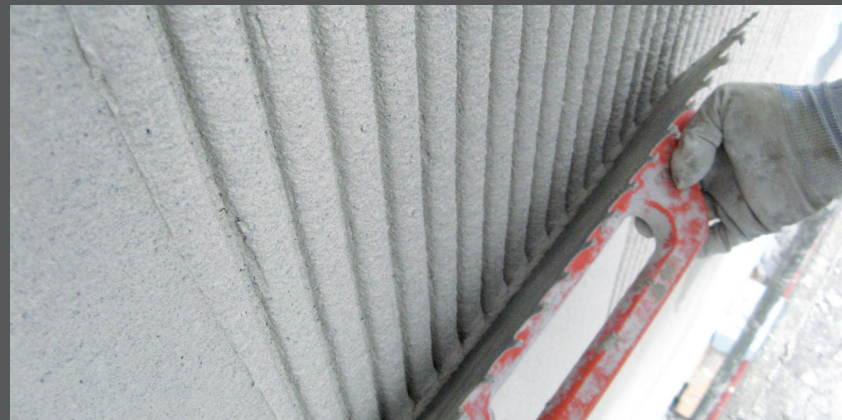
Mit der glatten Kellenseite im frischen Zustand glatt spachteln
