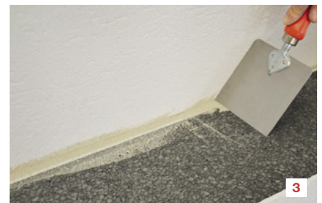
Kontrolle der Kleberkontaktfläche
