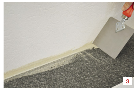
Kontrolle der Kleberkontaktfläche
