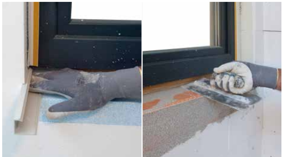
RÖFIX SOL-PAD priključni profil za prozorske klupice zalijepiti RÖFIX POLYMER-om, zatim površinu izolirati s RÖFIX OTIFLEX® 1K ili 2K.
