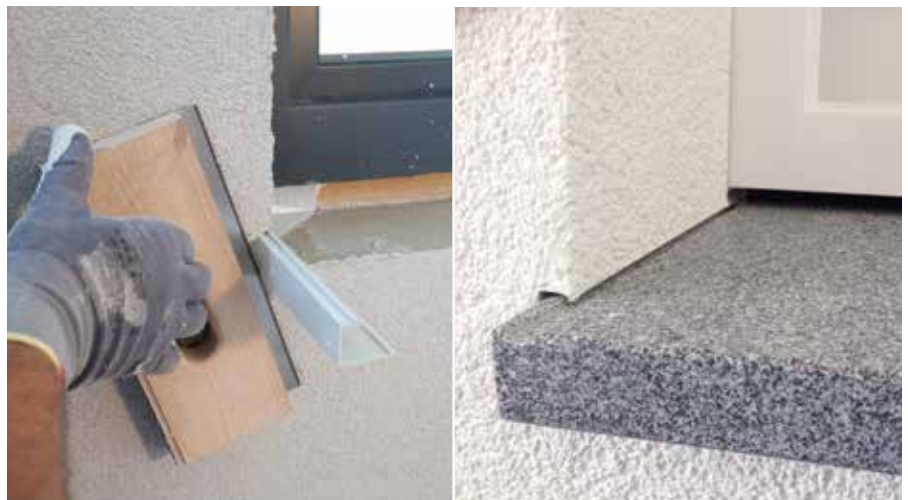
Rezanje viška RÖFIX SOL-PAD priključnog profila 2 mm od ruba i montaža prozorske klupice.
