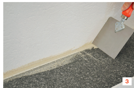
Kontrolle der Kleberkontaktfläche
