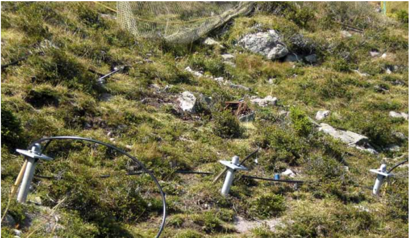
Progetto/luogo: paravalanghe Laugen – Tesimo (IT) Gruppo prodotti/prodotto: Calcestruzzo per iniezione/RÖFIX Creteolnject 995
