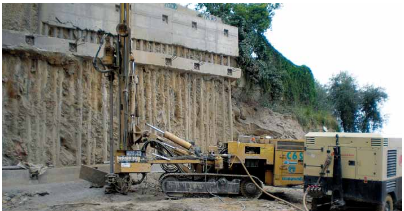
Progetto/luogo: Sonde per geotermia Genova (IT) Gruppo prodotti/prodotto: Calcestruzzo per iniezione/RÖFIX CreteoInject CC 854
