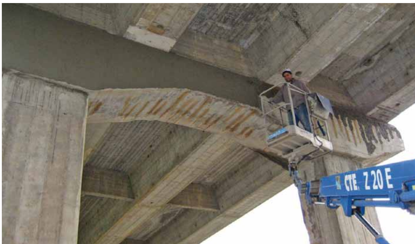
Progetto/luogo: risanamento del viadotto – Asti (IT) Gruppo prodotti/prodotto: Calcestruzzo per riparazioni/RÖFIX CreteoRepair CC 100
