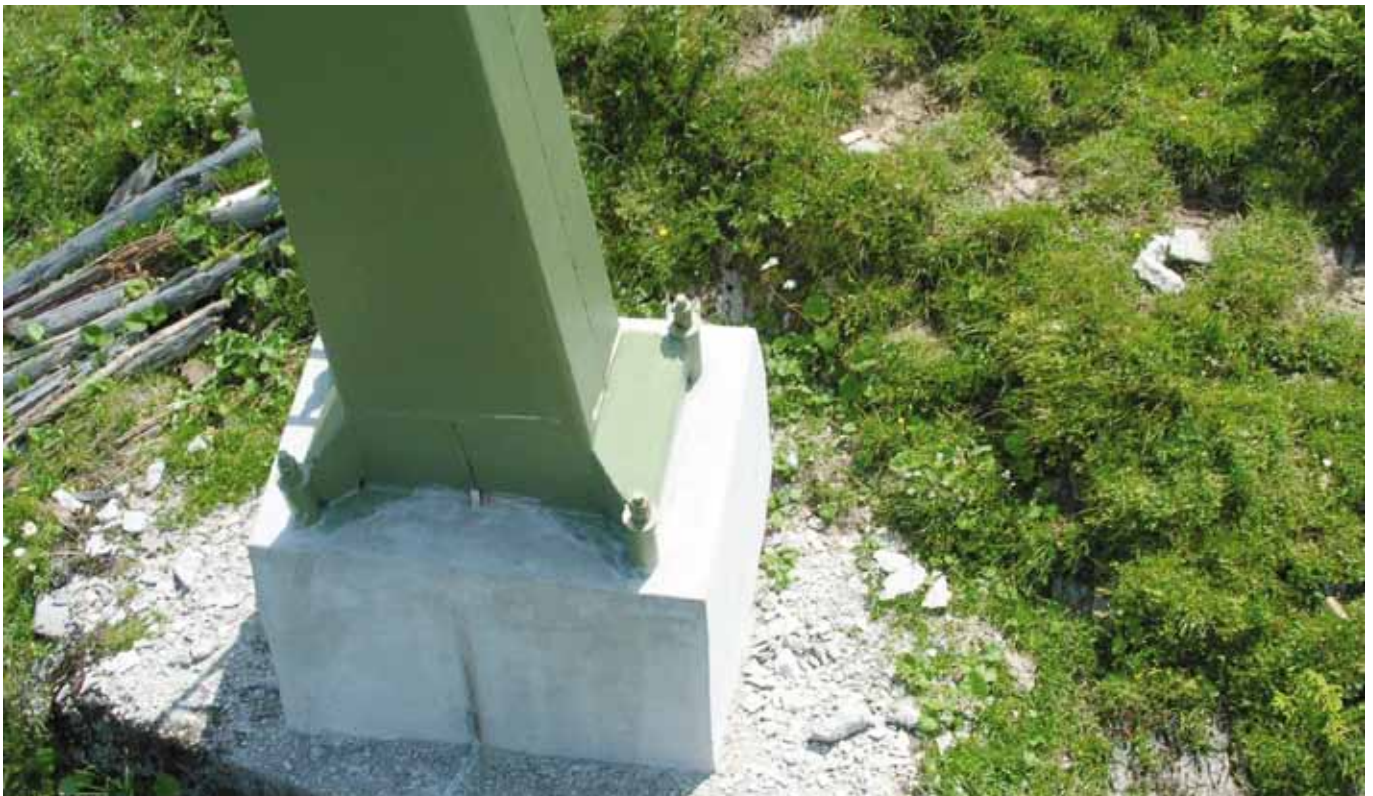
Progetto/luogo: ferrovia Hirschberg - Bizau (AT) Gruppo prodotti/prodotto: Calcestruzzo per riparazioni/RÖFIX CreteoRepair CC 100
