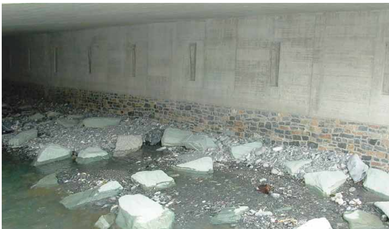
Progetto/luogo: risanamento alveo torrente a Chur (CH) Gruppo prodotti/prodotto: Sistemi di pavimentazione per esterno/RÖFIX CreteoGala CC 649 rapid
