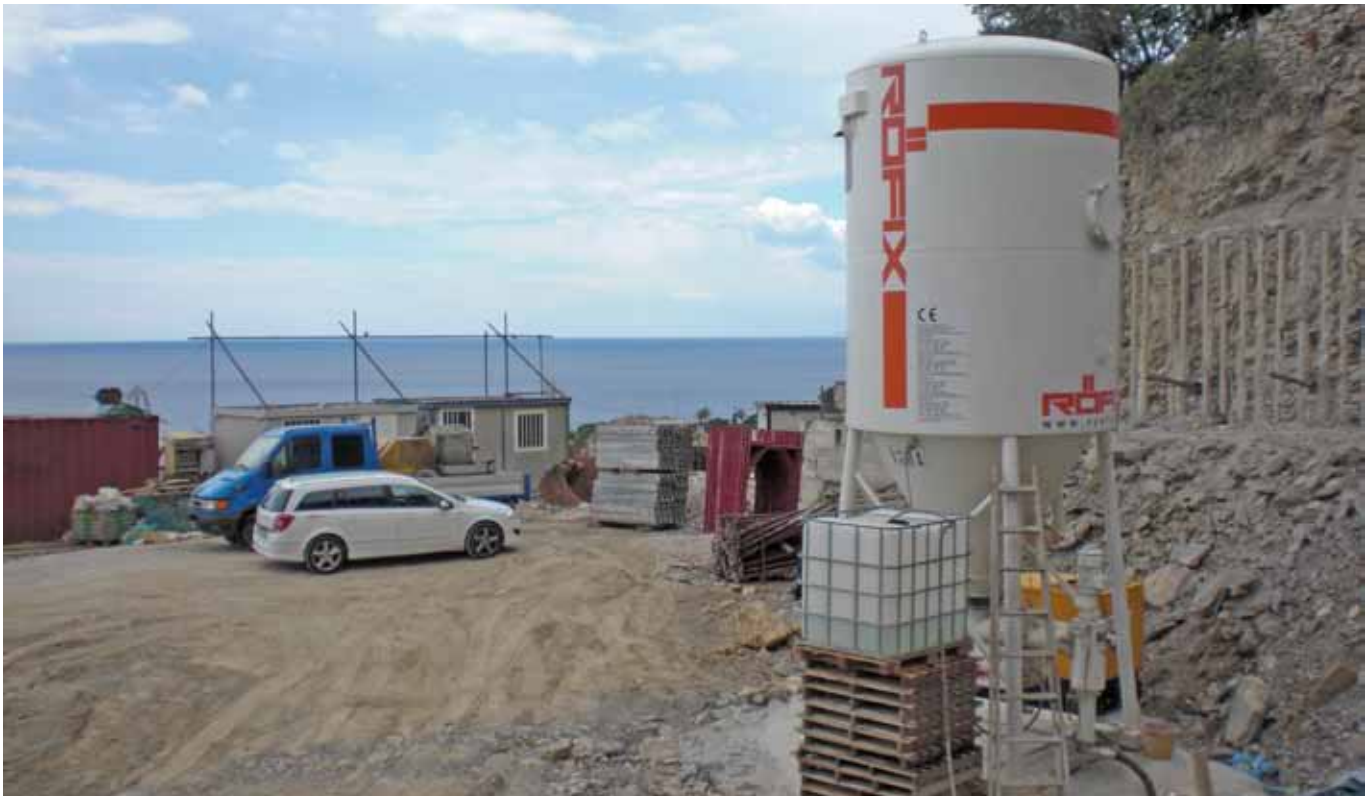
Progetto/luogo: micropali a Genova (IT) Gruppo prodotti/prodotto: Calcestruzzo per iniezione/RÖFIX CreteolInject CC 782
