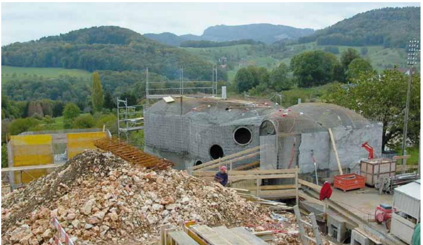
Progetto/luogo: Arboldswil (CH) Gruppo prodotti/prodotto: Calcestruzzo a spruzzo/RÖFIX CreteoShot RG8 S
