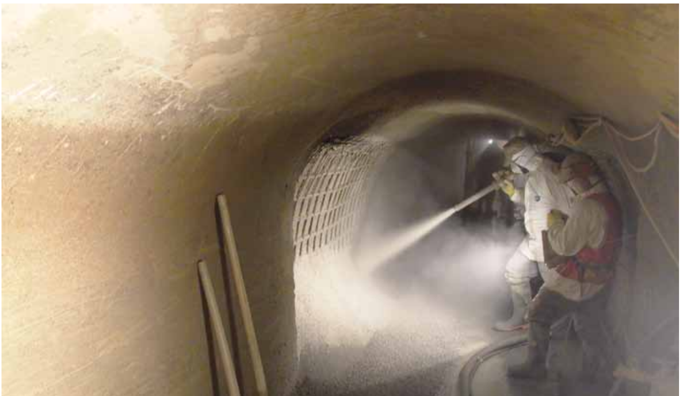
Progetto/luogo: risanamento cunicolo in pressione a Urnascha (CH) Gruppo prodotti/prodotto: Calcestruzzo a spruzzo/RÖFIX CreteoShot RG8 S
