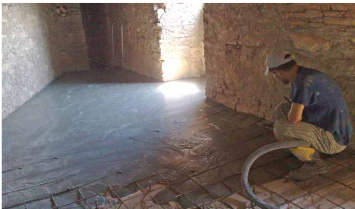
Progetto/luogo: rinforzo del solaio nella chiesa a Castenedolo (IT) Gruppo prodotti/prodotto: Calcestruzzo standard/RÖFIX CreteoStandard CC 254 Pump
