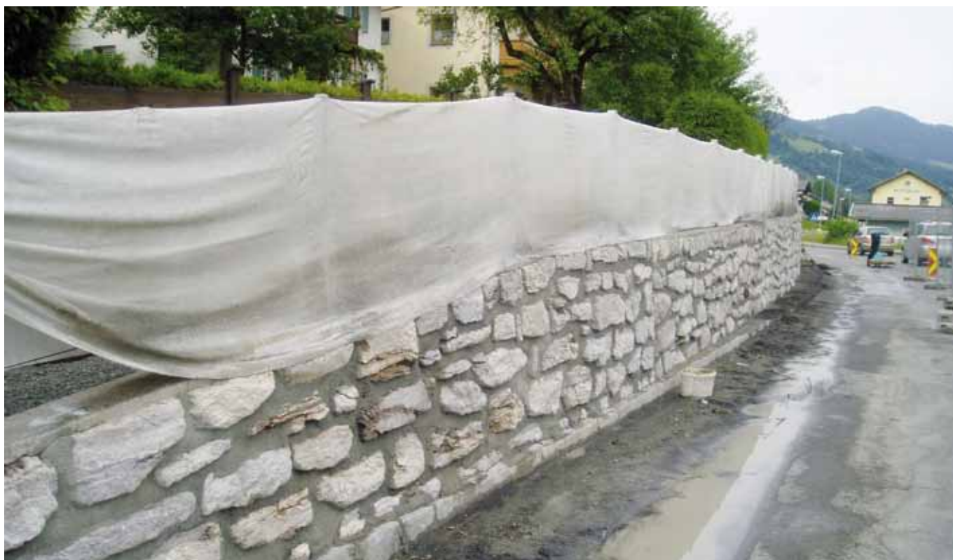
Progetto/luogo: Kopfgarten (AT) Gruppo prodotti/prodotto: Sistemi di pavimentazione per esterno/RÖFIX CreteoGala CC 649 rapid
