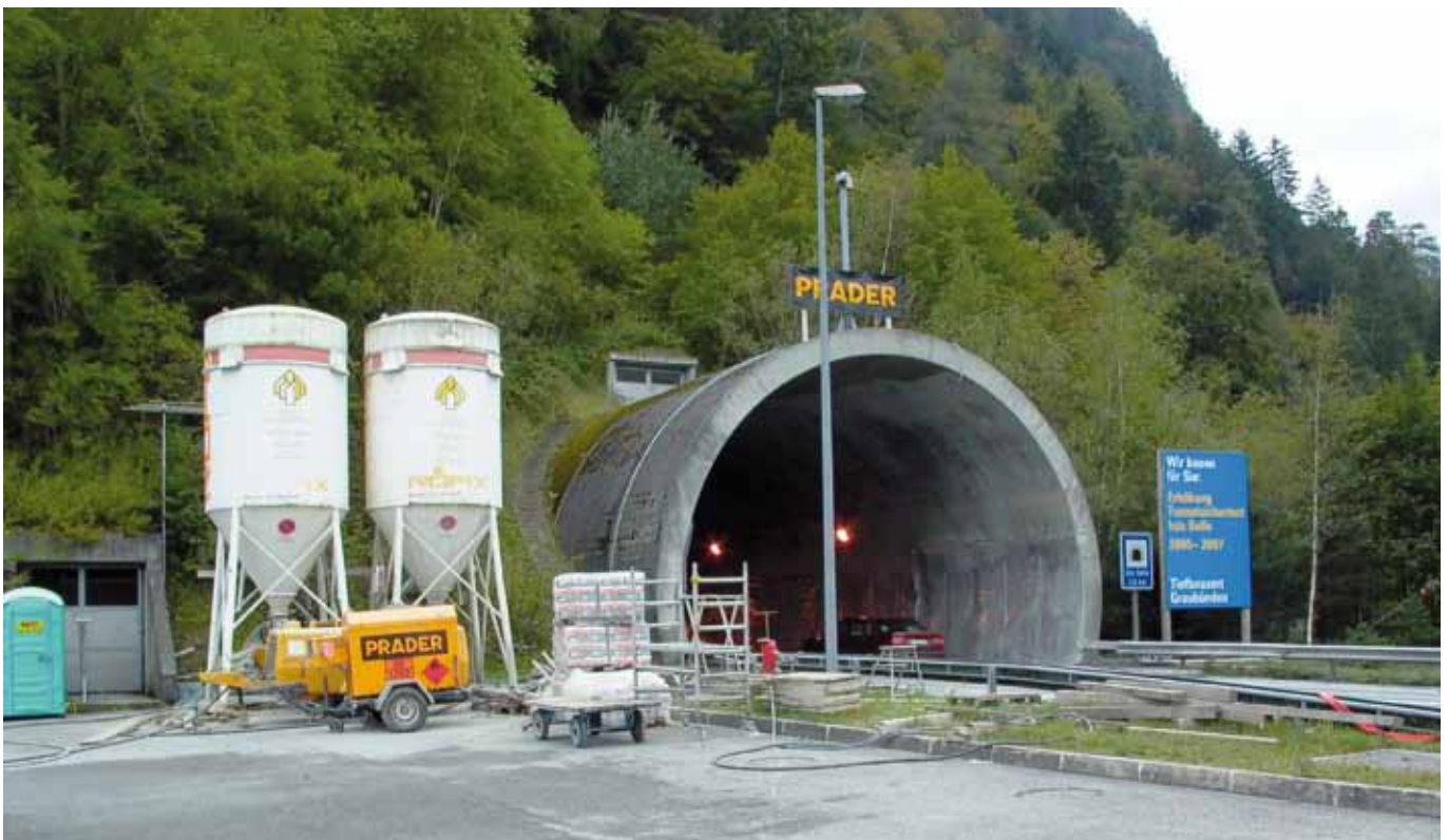
Progetto/luogo: risanamento galleria Isola Bella (CH) Gruppo prodotti/prodotto: Calcestruzzo per riparazioni/RÖFIX CreteoRepair CC198 S M; RÖFIX CreteoRepair CC 194 M
