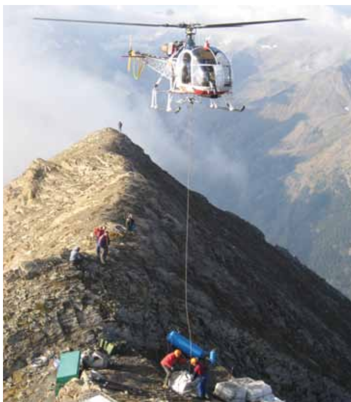
Progetto/luogo: paravalanghe Cogne - Aosta (IT) Gruppo prodotti/prodotto: Calcestruzzo per iniezione/RÖFIX CreteoInject 995
