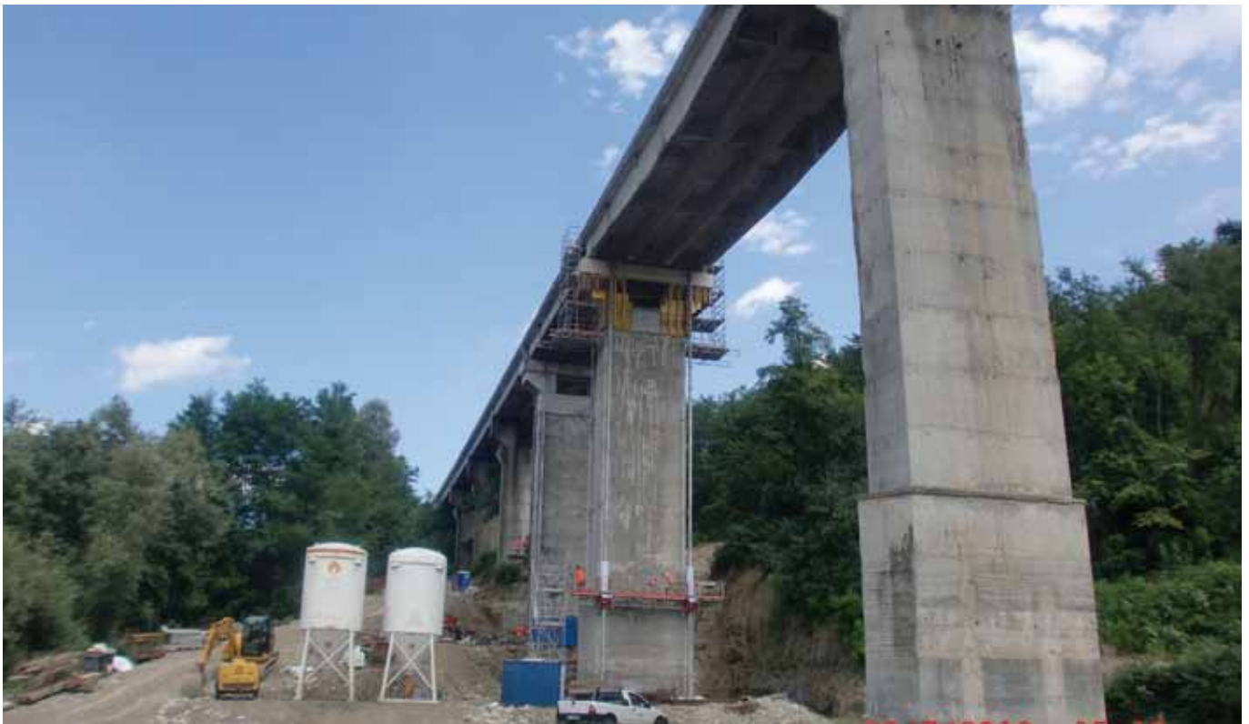
Progetto/luogo: viadotto autostrada Torino – Savona a Fossano (IT) Gruppo prodotti/prodotto: Calcestruzzo per riparazioni/RÖFIX CreteoRepair CC 194 M; RÖFIX CreteoRepair CC 194 SM
