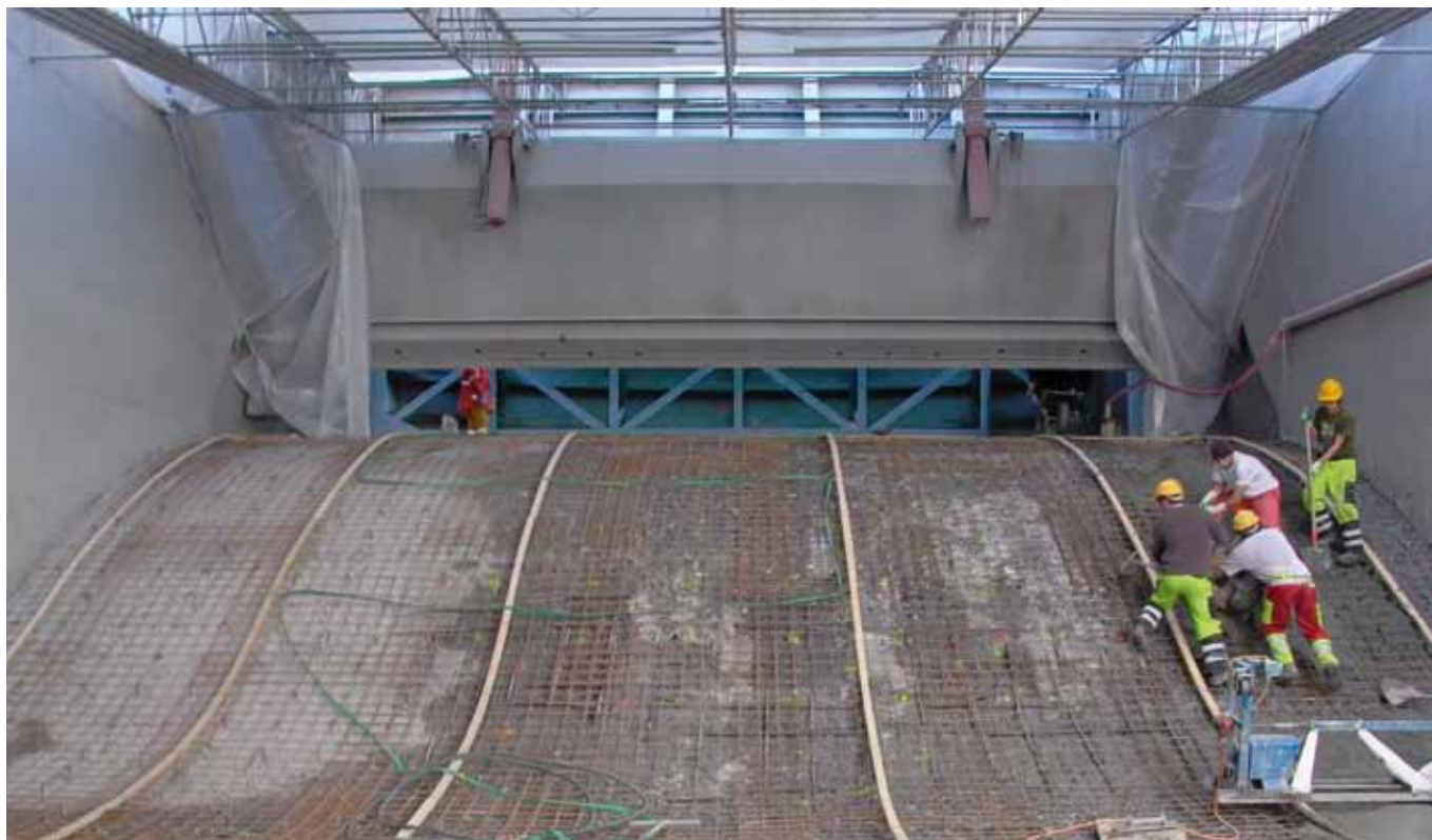
Progetto/luogo: centrale sul Reno di Reichenau (CH) Gruppo prodotti/prodotto: Calcestruzzo speciale/RÖFIX CreteoSpecial NOK
