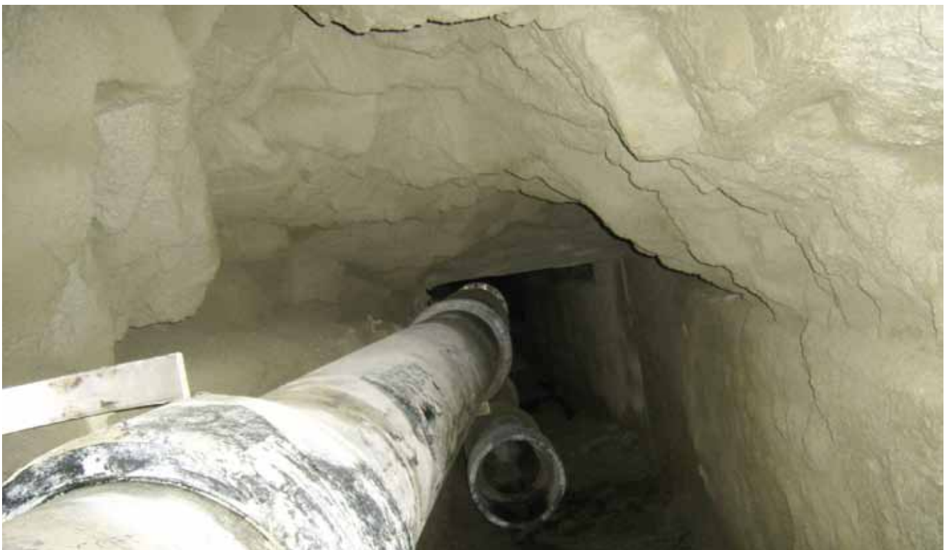
Progetto/luogo: risanamento alveo torrente – Lana (IT) Gruppo prodotti/prodotto: Calcestruzzo a spruzzo/RÖFIX CreteoShot RG8 S
