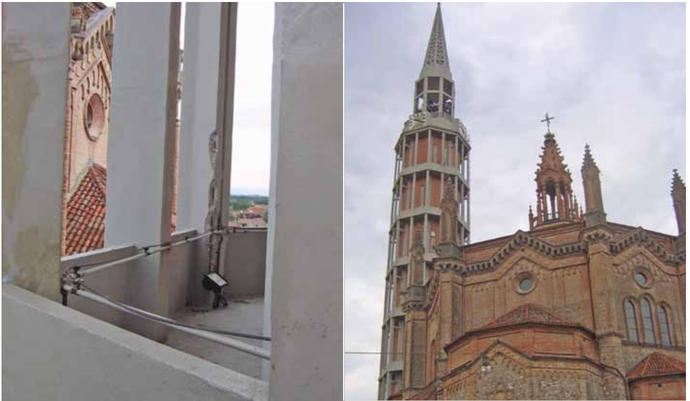
Progetto/luogo: risanamento campanile Mortegliano (IT) Gruppo prodotti/prodotto: Calcestruzzo per riparazioni/RÖFIX CreteoRepair CC 100
