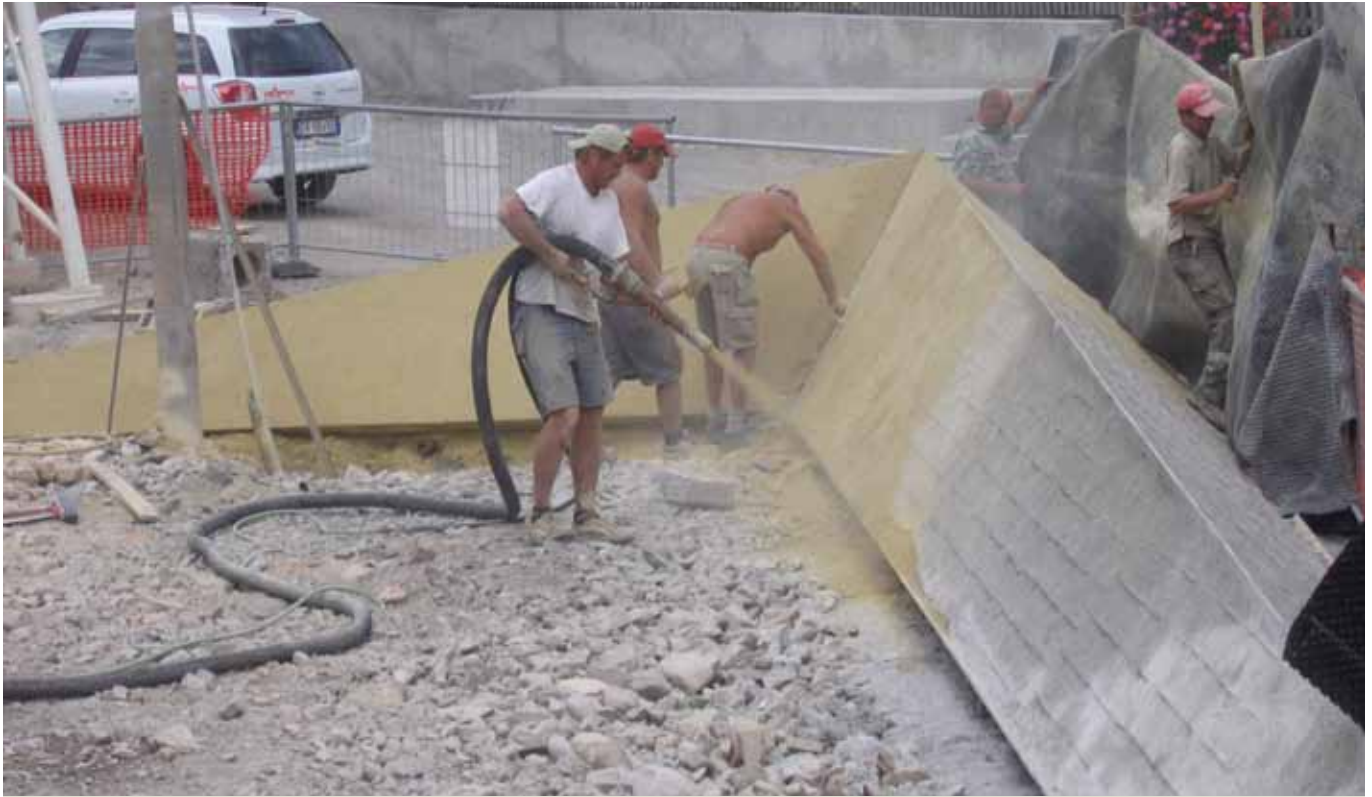
Progetto/luogo: nuova piazza centrale a Tubre (IT) Gruppo prodotti/prodotto: Calcestruzzo a spruzzo/RÖFIX CreteoShot RG8 S; RÖFIX CreteoShot RG 4 M colorato
