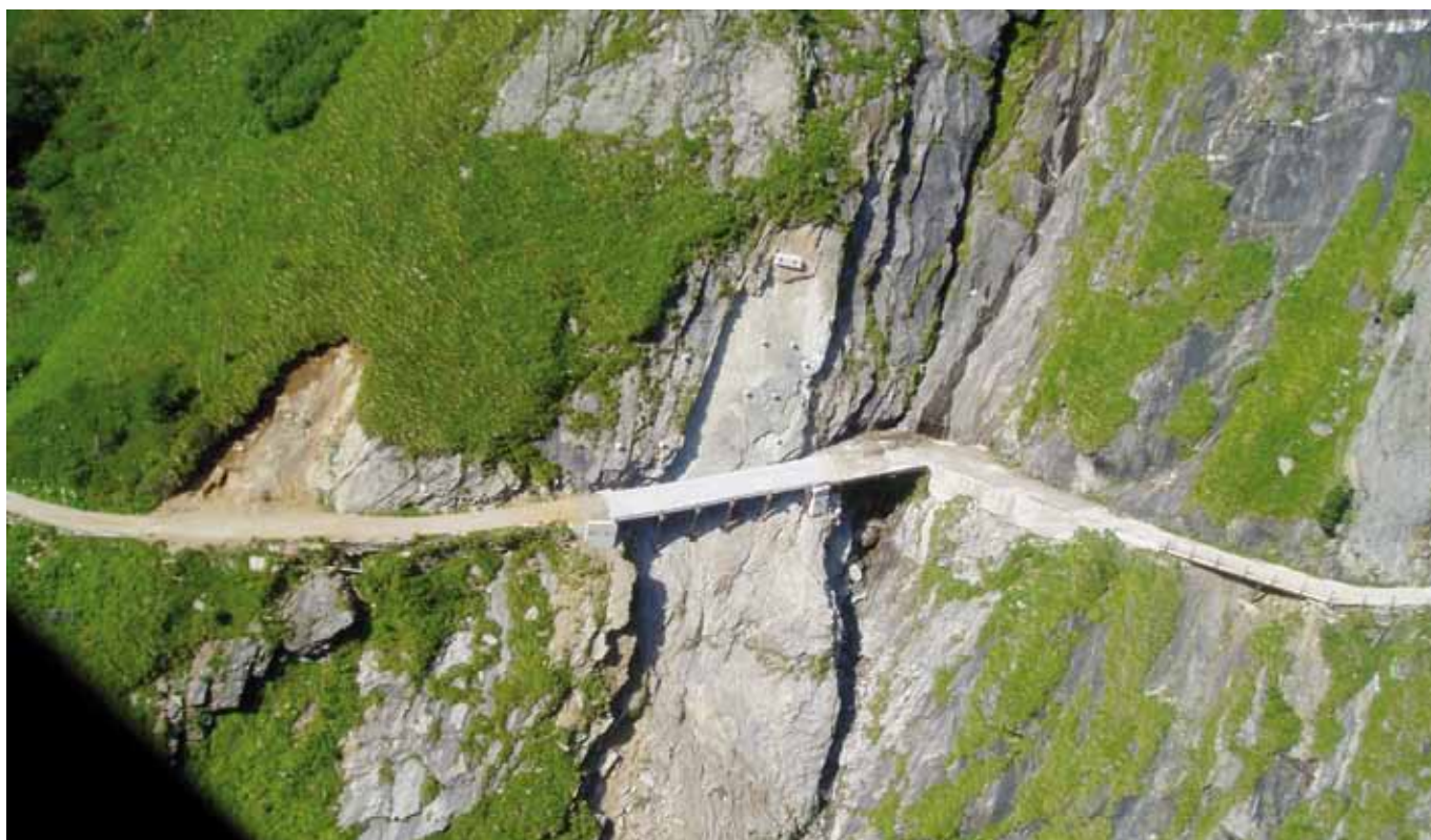
Progetto/luogo: strada di accesso a Zillergrund (AT) Gruppo prodotti/prodotto: Calcestruzzo standard/RÖFIX CreteoStandard 990 B30; Calcestruzzo per iniezione/RÖFIX CreteoInject 995
