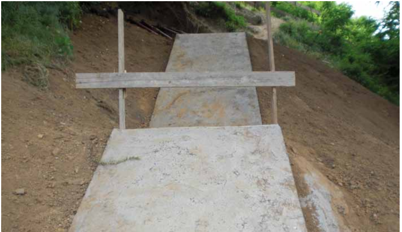
Progetto/luogo: le scale di Rivoli (IT) Gruppo prodotti/prodotto: Sistemi di pavimentazione per esterno/RÖFIX CreteoGala CC 633
