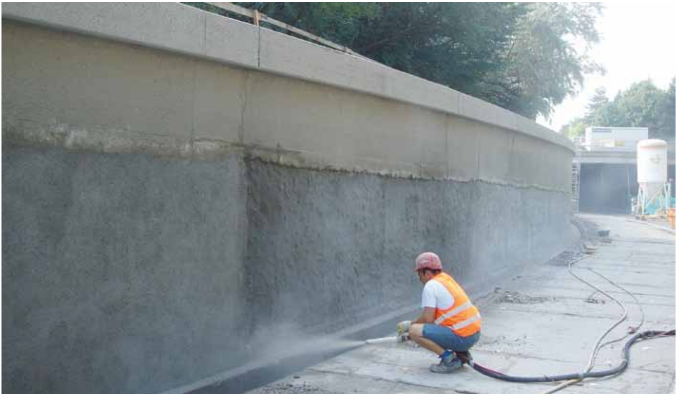
Progetto/luogo: risanamento sottopasso – Vienna Altmannsdorf (AT) Gruppo prodotti/prodotto: Calcestruzzo per riparazioni/RÖFIX CreteoRepair CC 194 M
