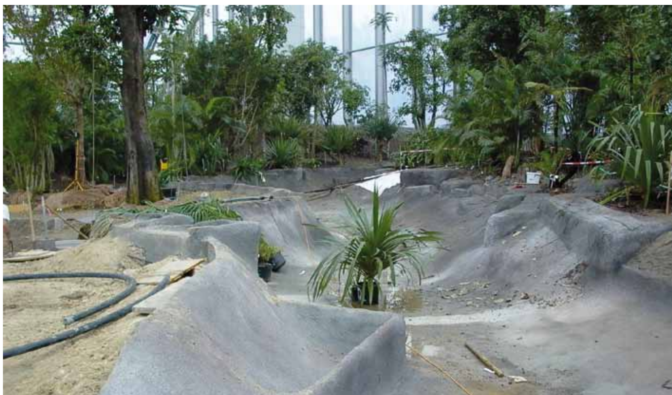
Progetto/luogo: giardino zoologico di Zurigo (CH) Gruppo prodotti/prodotto: Calcestruzzo a spruzzo/RÖFIX CreteoShot RG8 S
