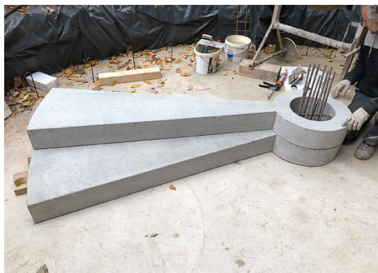
Abb. 18: Stufenfertigteile der Freitreppe
