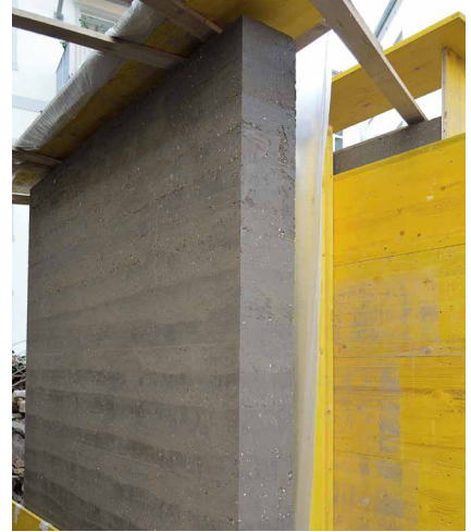
Abb. 13: Die Stampflehmwände aus dem Material des Aushubs mussten 3 Jahre im Hof ausharren, bis sie zum Einsatz kamen
