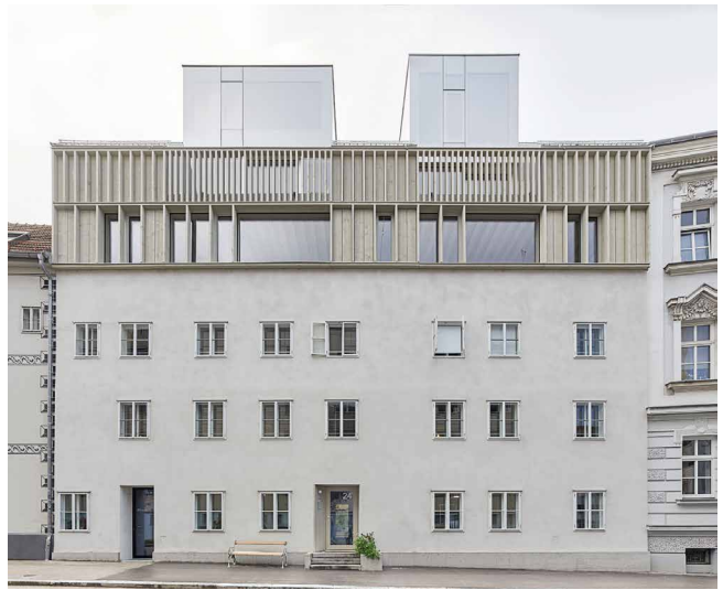
Abb. 4: Heutige Straßensicht mit Aufstockung
