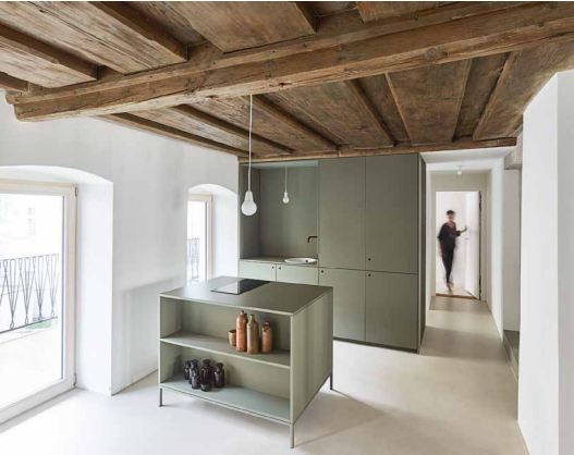
Abb. 10: (Wohn-)Küche in einem sanierten Geschoss. Die historische Holzdecke wurde mittels Holz-Beton-Verbundtechnik erhalten und ertüchtigt.
