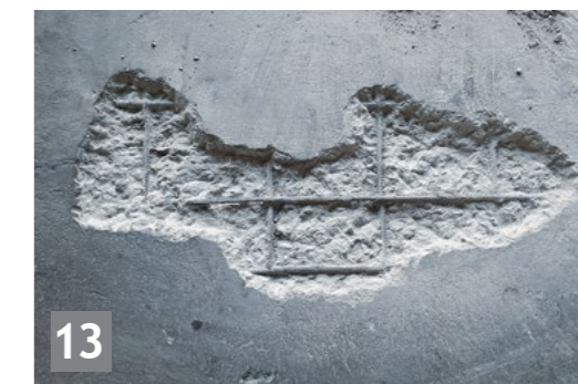
13 Ремонт і відновлення бетону
