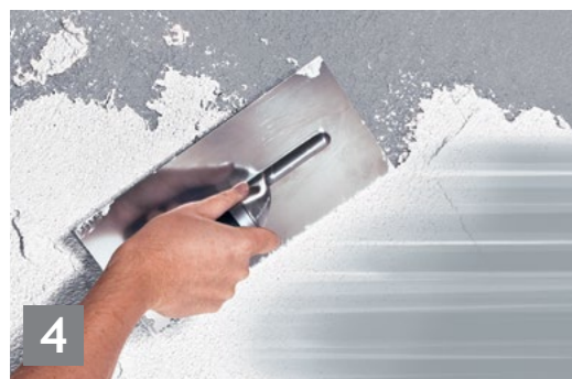
4 Декоративні фасадні штукатурки
