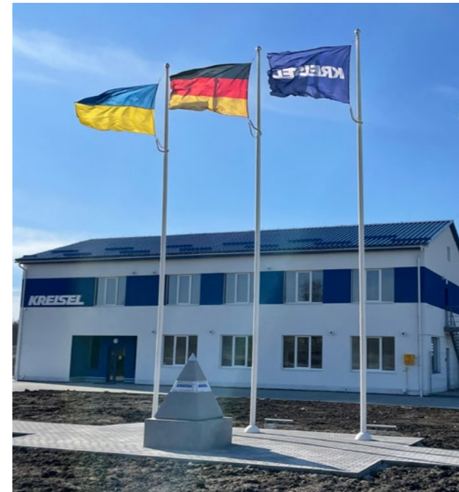
Завод КРАЙЗЕЛЬ с. Піски (Львівська обл.)
