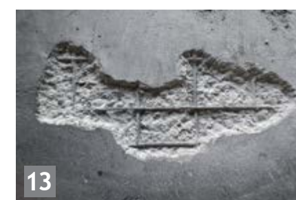
Ремонт і відновлення бетону
