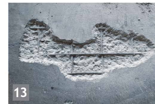
13 Ремонт і відновлення бетону
