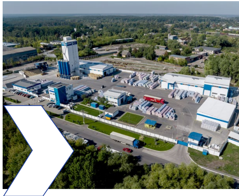
Завод КРАЙЗЕЛЬ м. Фастів (Київська обл.)
