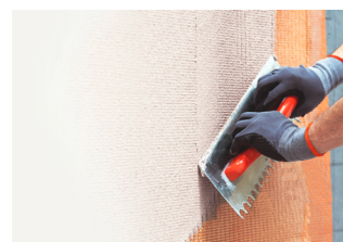
5 Armierung der Dämmputz-Schicht
