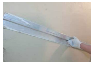
4 Planeben abziehen von RÖFIX CalceClima® Thermo
