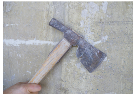
Kontrolle auf Hohlstellen
