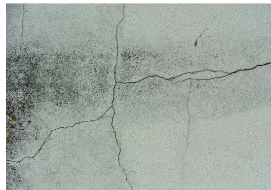
Schwindriss im abgebundenen Zustand
