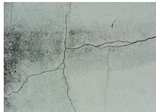
Schwindriss im abgebundenen Zustand
