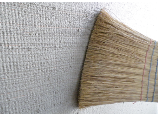
Zwischenschicht mit Besen aufreissen
