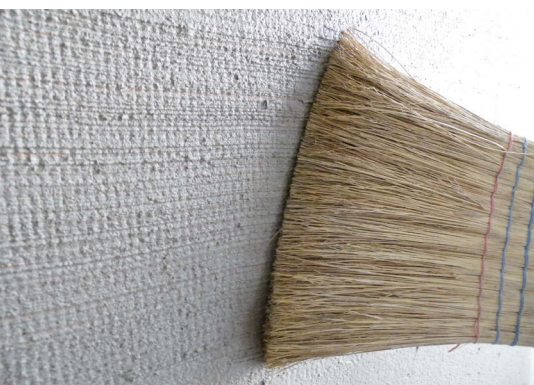
Zwischenschicht mit Besen aufreißen
