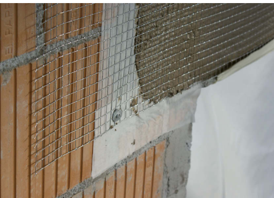
Armanet montieren
