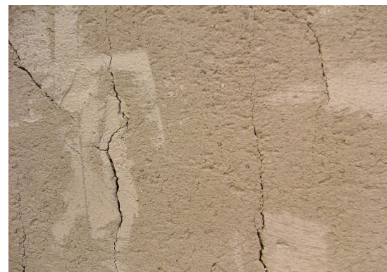
Schwindriss im frischen Zustand
