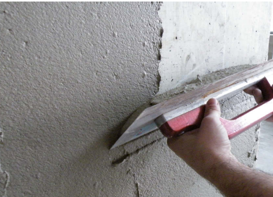
Riss-Sanierungspachtel auftragen
