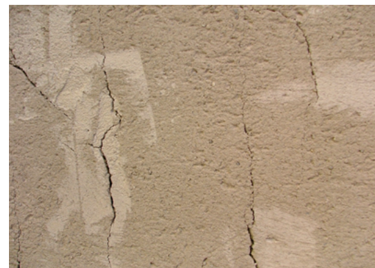
Schwindriss im frischen Zustand
