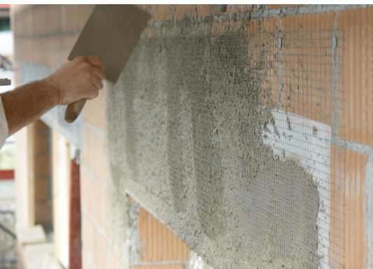
Zementmörtelanwurf
