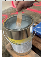
Mit Airless, Pinsel oder Rolle HASIT PP 306 Präventivschutz auftragen.
