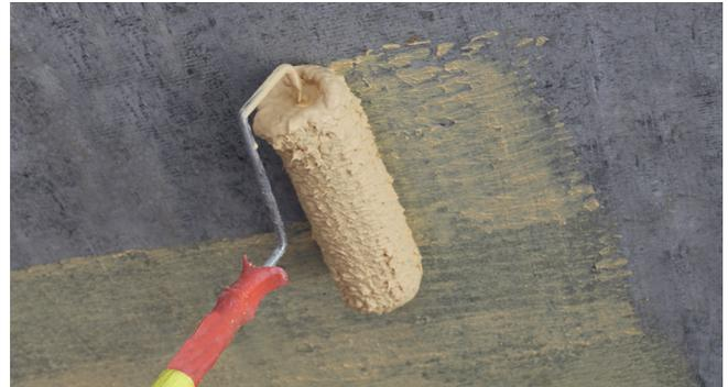
Bei einer Auftragsstärke > 20 mm auf Betonuntergrund wird empfohlen, vorgängig eine horizontal aufgekämmte Haftbrücke wie zum Beispiel Fixit 346 Quarzbrücke spezial (mit Zementzusatz vermischt) aufzutragen.
