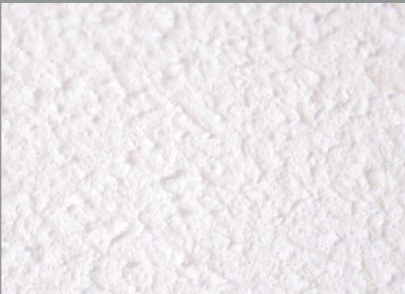
Fixit 740 Si Silikon-Silikatputz aussen Rustik, 1x aufgezogen, 1x Putzmeisterschicht, Nachbehandlung mit Lammfellrolle
