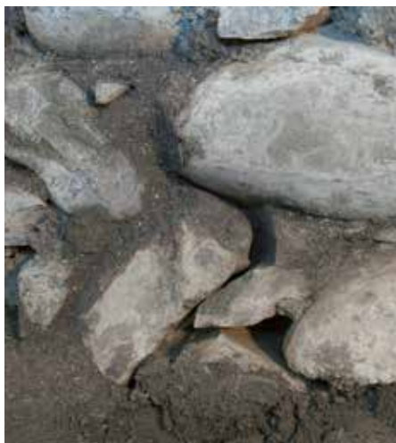
Praznine u zidu od prirodnog kamena
