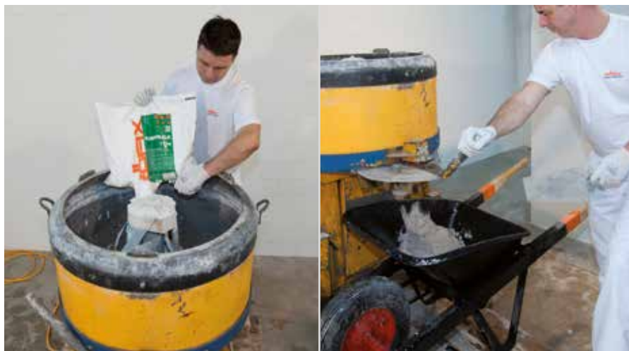
Mešanje BAUKASTEN sistema
