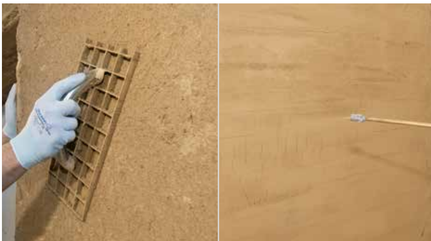
Izravnavanje strugalicom i vlaženje maltera RÖFIX Geolehm®
