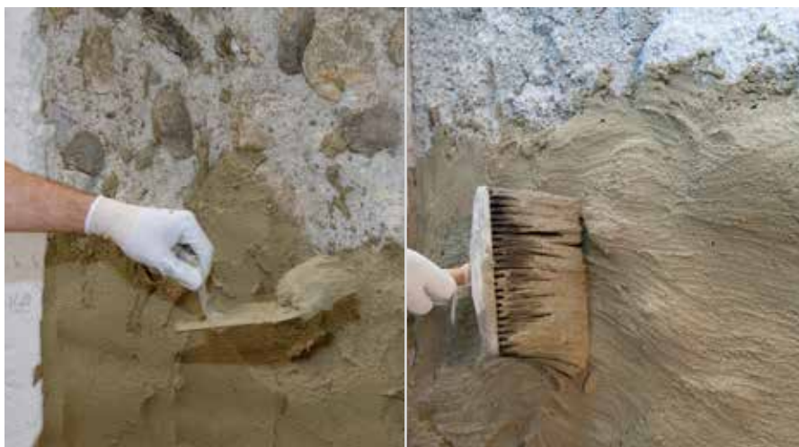
Nabacivanje i razmazivanje RÖFIX 635
