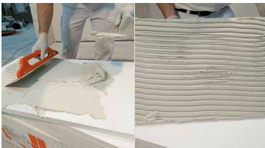
Postupak lepljenja uz 100%-tno prekrivanje površine sa RÖFIX Renopor® Specijalnim lepkom
