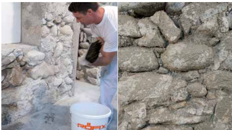
Nabacivanje RÖFIX Sanir grunda četkom
