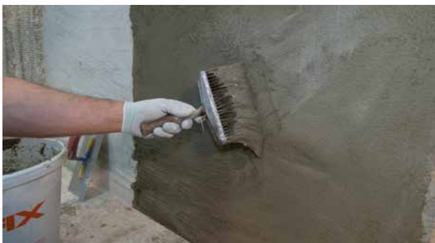
RÖFIX 636 Hidroizolaciona masa sa najvećom debljinom sloja od 3 mm nanosi se na RÖFIX 635
