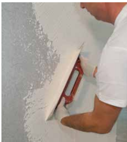
Nanošenje završnog maltera
