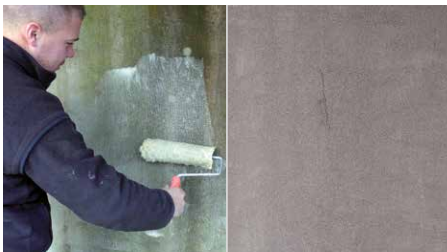
Nanošenje RÖFIX Algenkiller Uništavača algi
