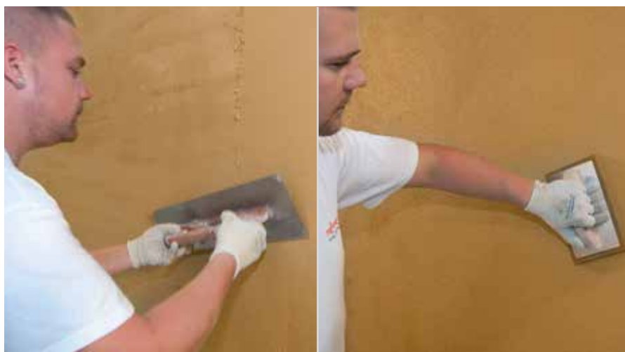
Nanošenje sloja finog maltera
