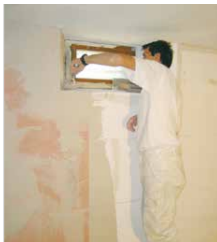
Montaža RÖFIX Renopor® Ivične prenosnice
