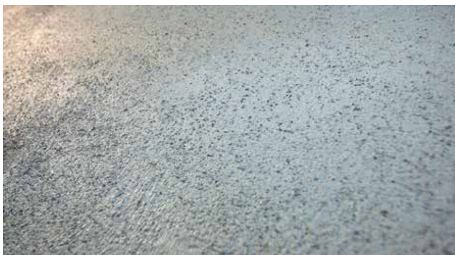
RÖFIX 397, 2. sloj strukturisan
