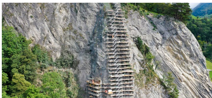
Stabilizzazione rocciosa Axenstrasse, Sisikon UR
