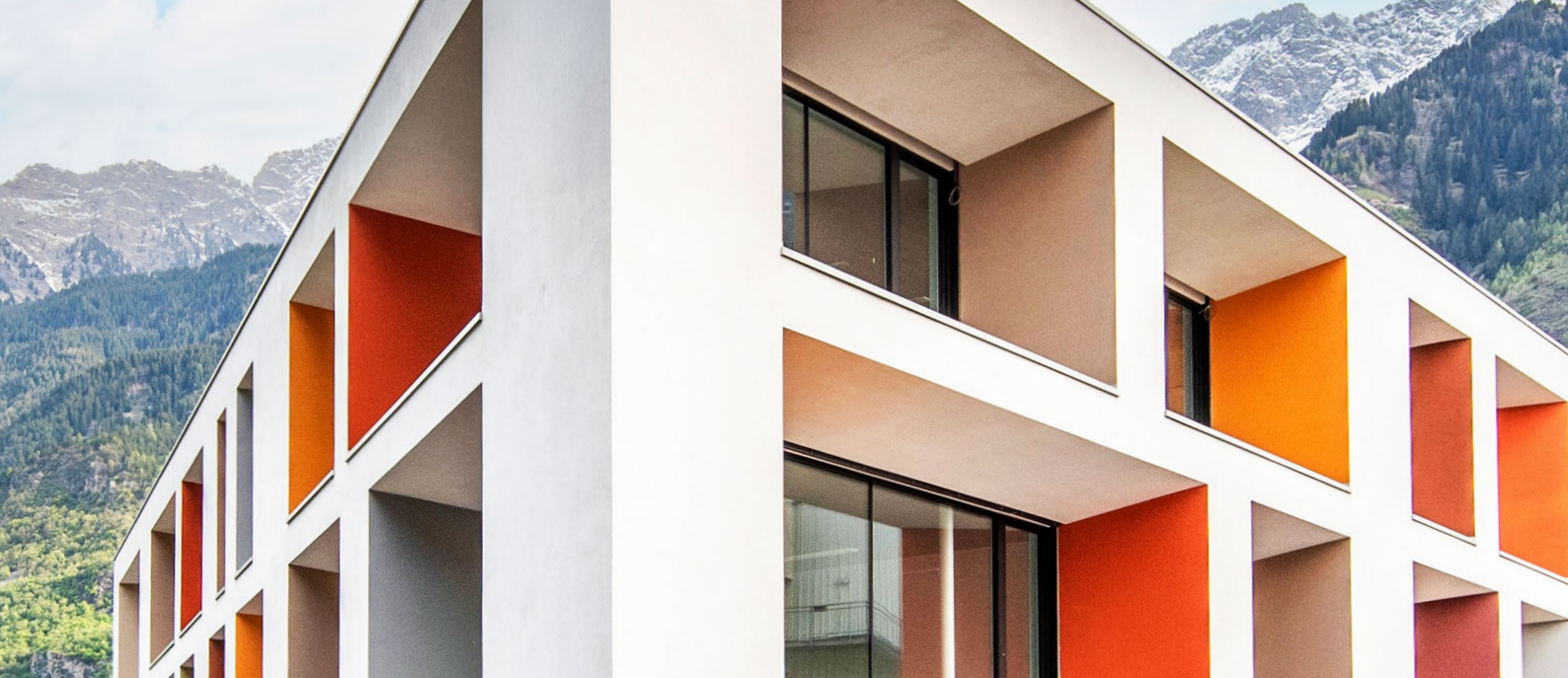
Sede centrale Röfix Italia, Parcines
