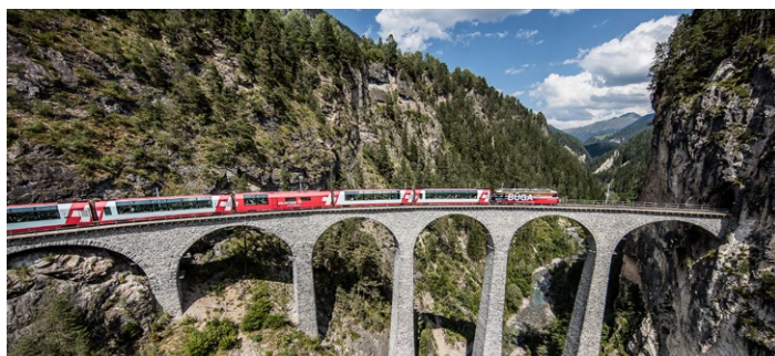
Viadotto Landwasser, Ferrovia Retica, Svizzera
