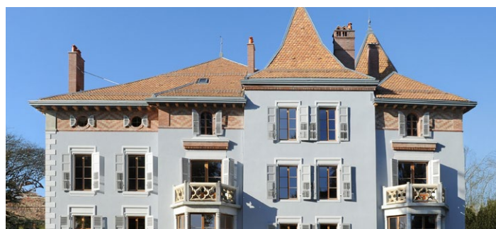
Intonaco termoisolante Villa, Morges VD
