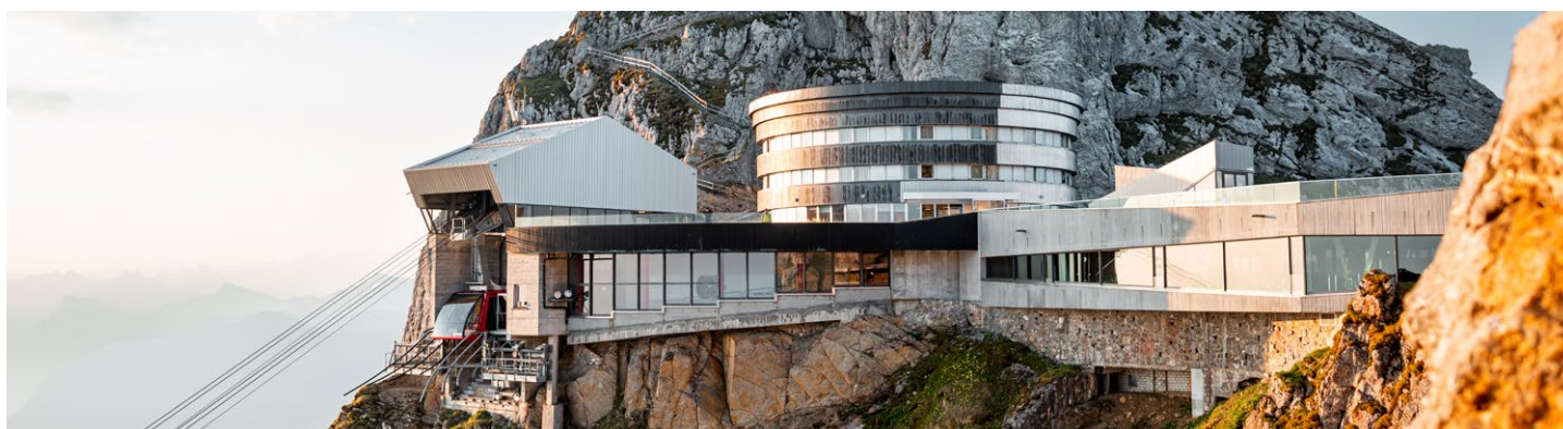
Ampliamento della sala d'attesa, stazione a monte Pilatus Kulm, Svizzera
