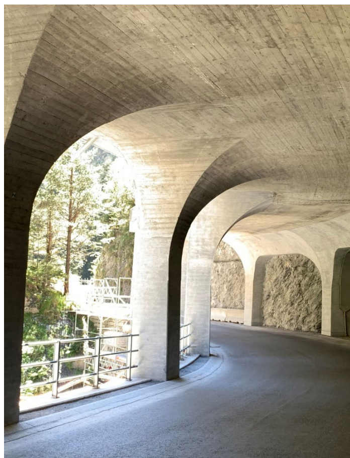
Ristrutturazione della galleria Viamala 1, Svizzera
