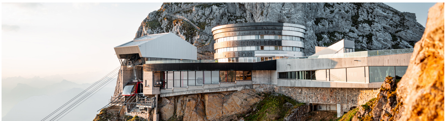
Laukimo salės praplėtimas "Pilatus Kulm mountain station", Šveicarija
