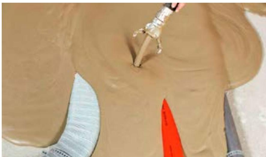
POR svojom tekućom konzistencijom idealno zapunjava sve instalacije, izravnava različite neravnine, te kvalitetno štiti instalacije od oštećenja uslijed daljnjih radova ili naknadnih točkastih opterećenja.
