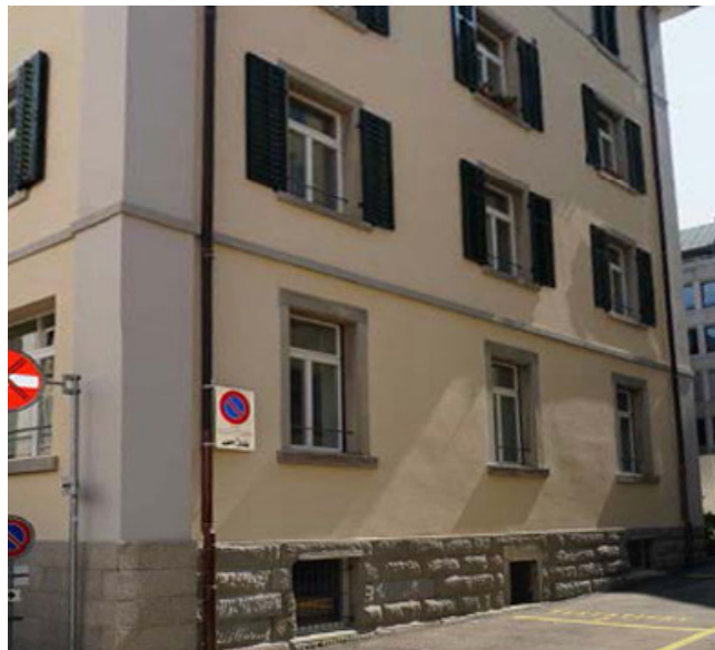
Lumière rasante sur la façade avec enduit isolant aérogel. L'isolation ne se voit pas.
