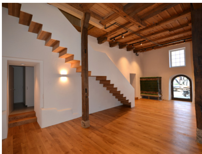
Isolation intérieure avec enduit isolant aérogel (1 er prix Aerogel Award de l'EMPA 2021)
