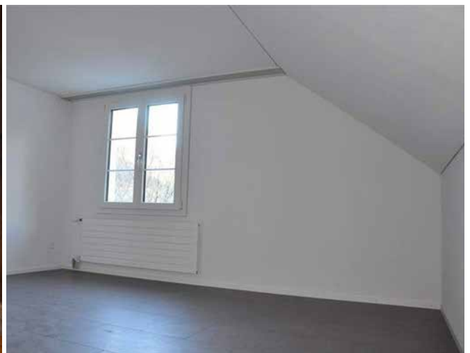
Isolation intérieure avec doublage
