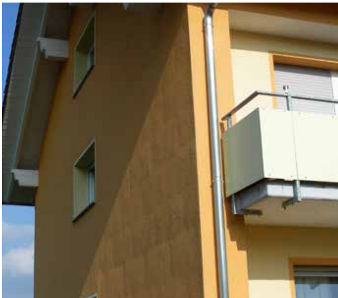
Lumière rasante sur la façade avec panneaux isolants. Les panneaux sont visibles, mais doivent être acceptés selon la norme SIA 243 "Isolation thermique extérieure crépie".
