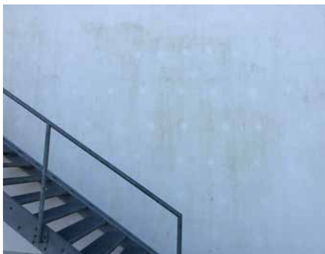
Une façade de 10 ans avec une isolation thermique extérieure crépie
