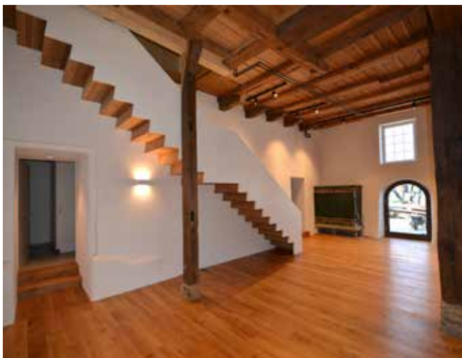
Isolation intérieure avec enduit isolant aérogel (1 er prix Aerogel Award de l'EMPA 2021)
