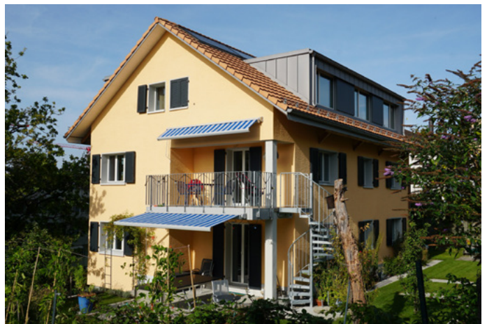
Assainissement d'un immeuble d'habitations, St. Ga
