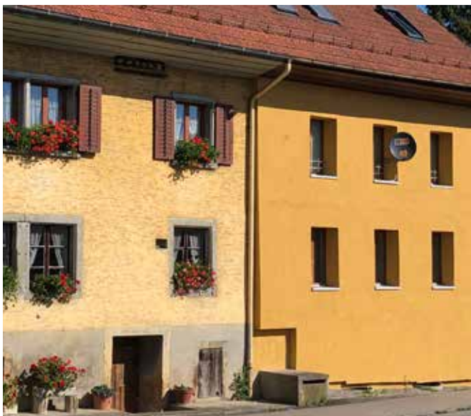
Cette façade (à droite) a certes été rénovée et isolée, mais l'histoire de la maison s'est perdue.
