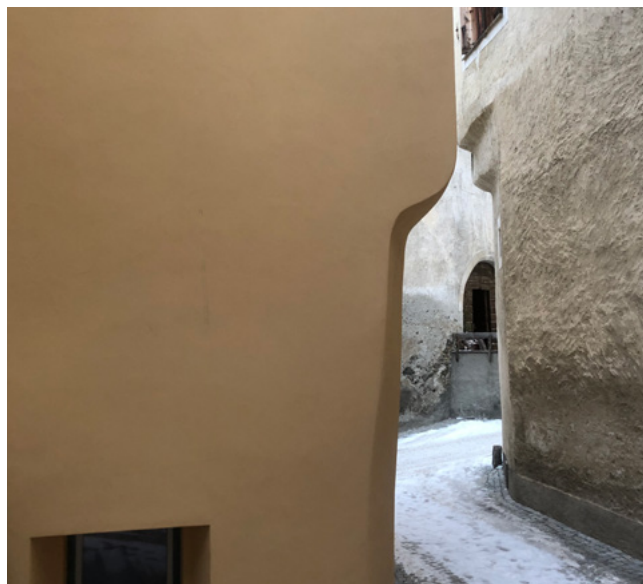
Ici, la façade avec un enduit isolant aérogel raconte une histoire compréhensible.
