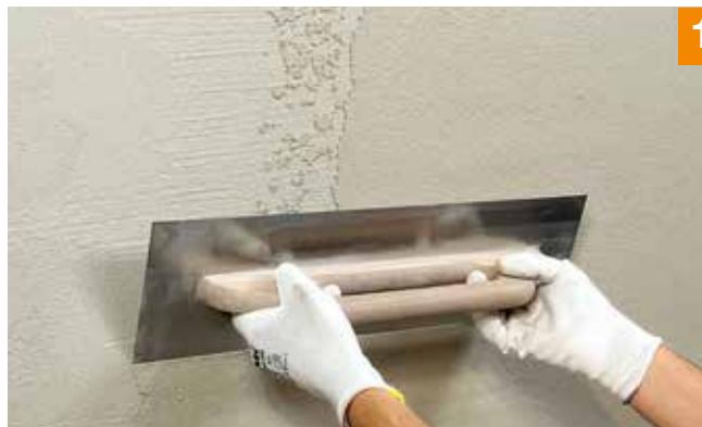
1. Auf die Armierungsschicht wird die Grundbeschichtung mit dem Fixit 745 Designputz auf Kornstärke (ca. 1,5 mm) aufgezogen.
