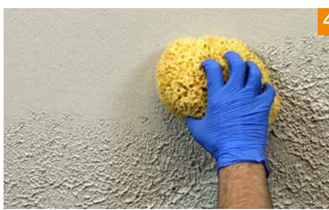
4. Als Variante kann der Fixit 745 Designputz in noch frischem Zustand auch mit einem Schwamm abgetupft werden.
