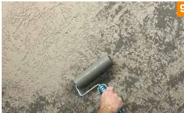
9. Für einen zweifarbigen Effekt wird die Putzoberfläche mit einer kurzflorigen Moosgummi- oder Tapezierwalze und andersfarbiger Fixit 786 Si Silikat-Silikon-Überrollfarbe kreuz und quer und mit leichtem Druck abgerollt.
