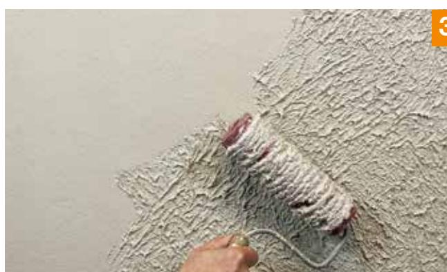
3. Der noch frische Fixit 745 Designputz wird mit der Reliefwalze «Maserung» kreuz und quer strukturiert. Die Reliefwalze muss in regelmässigen Abständen gereinigt werden.
