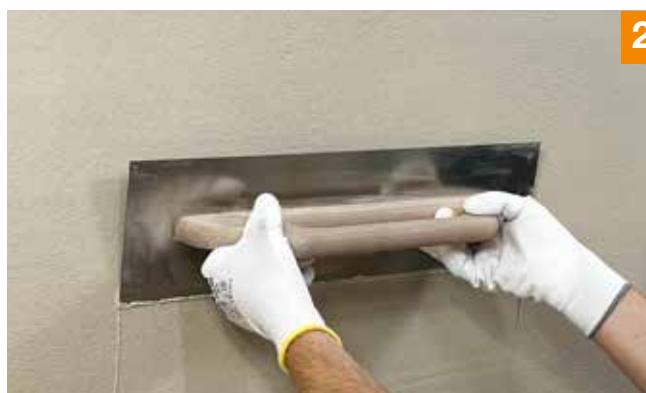
2. Nachdem die Grundbeschichtung getrocknet ist, wird der Fixit 745 Designputz als Deckputz mit einer Korn- und Schichtstärke von ca. 1,5 mm aufgezogen.
