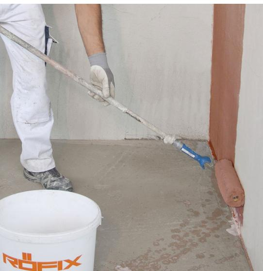
RÖFIX Betonkontakt Betonhaftgrund ist ein Lösungsmittelfreier Haftvermittler für Unterputze auf kritischen Untergründen zur Verbesserung der Haftung von Kalk-Gips-, Kalk-Zement- Grundputzen auf Beton und ungleich saugenden Untergründen.
