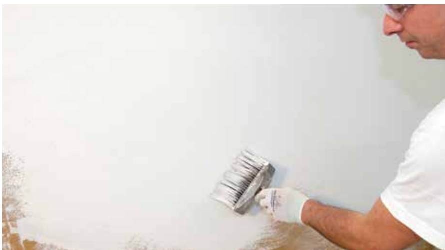
Nanošenje četkom fresco tehnikom
