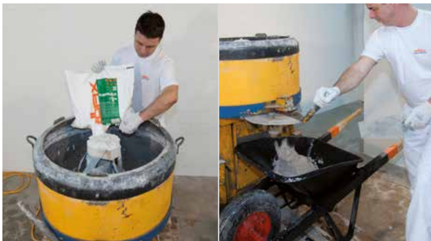
Miješanje BAUKASTEN sistema
