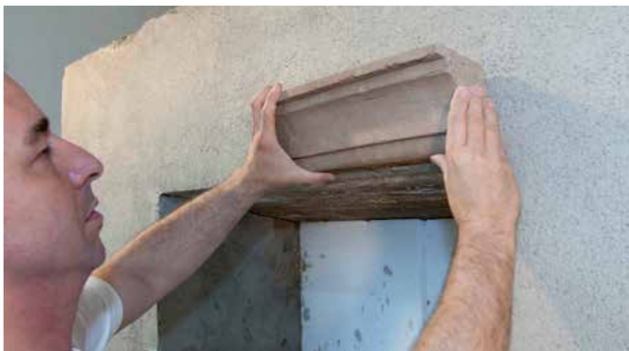
Montaža dekorativnih profila
