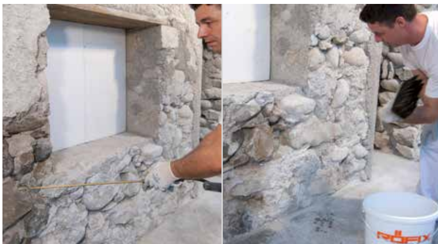
Navlaživanje podloge prskalicom za prskanje stabala
