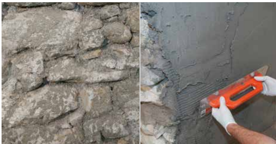
RÖFIX 671 Špric za saniranje uz 60 %-tno prekrivanje površine
