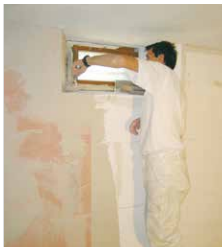
Montaža RÖFIX Renopor® Ivične prenosnice
