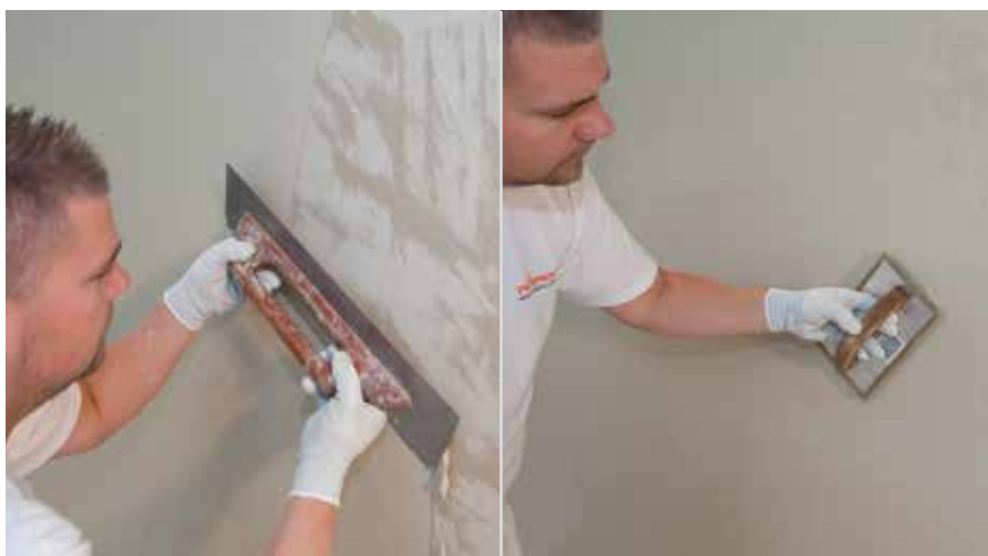
Nanošenje RÖFIX CalceClima® Fino
