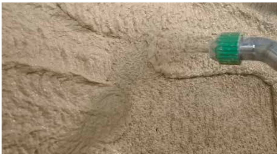
Nanošenje RÖFIX CalceClima® Thermo
