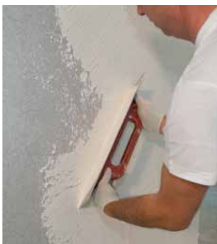
Nanošenje završnog maltera
