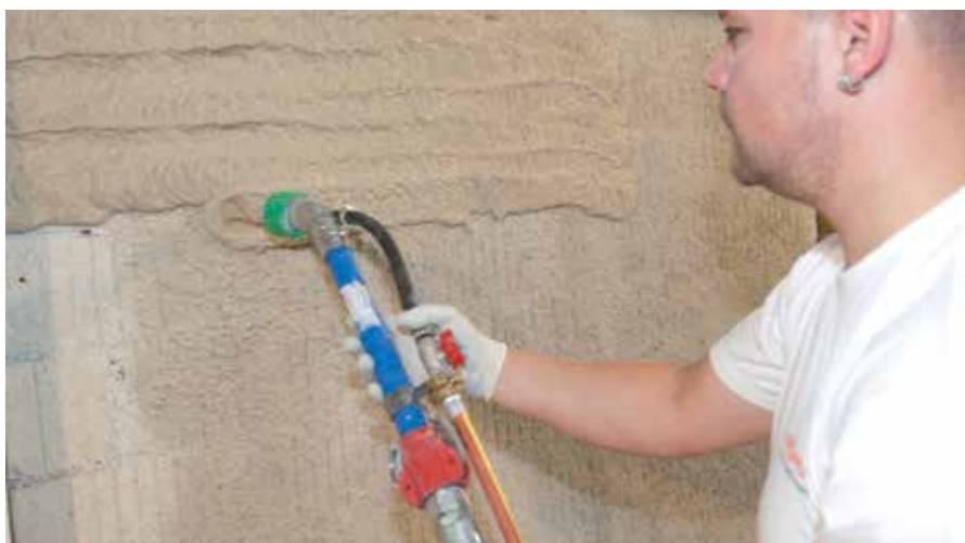
Nanošenje RÖFIX CalceClima® Ambiente
