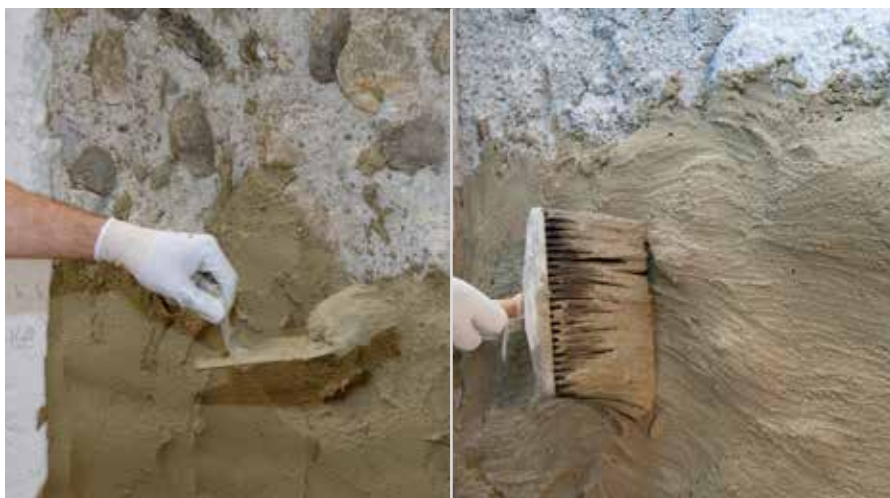
Nabacivanje i razmazivanje RÖFIX 635
