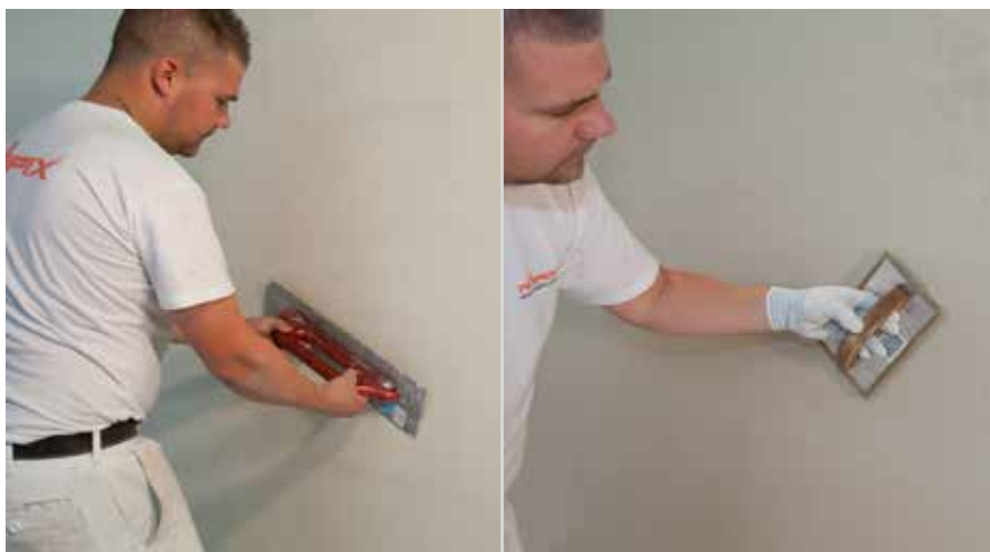
Nanošenje mineralnog završnog maltera RÖFIX CalceClima® Fino
