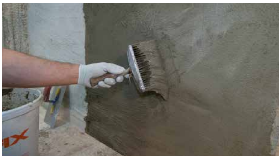
RÖFIX 636 Hidroizolaciona masa s najvećom debljinom sloja od 3 mm nanosi se na RÖFIX 635
