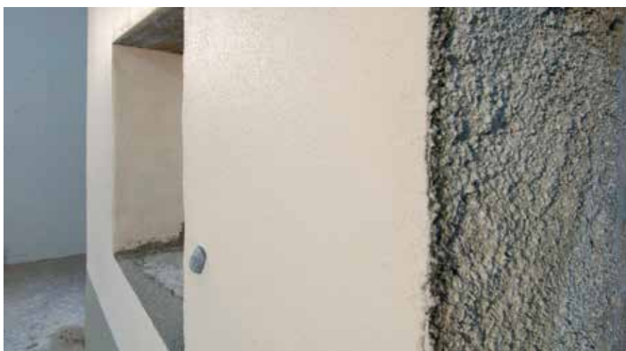
Nanošenje završnog maltera (RÖFIX 380)
