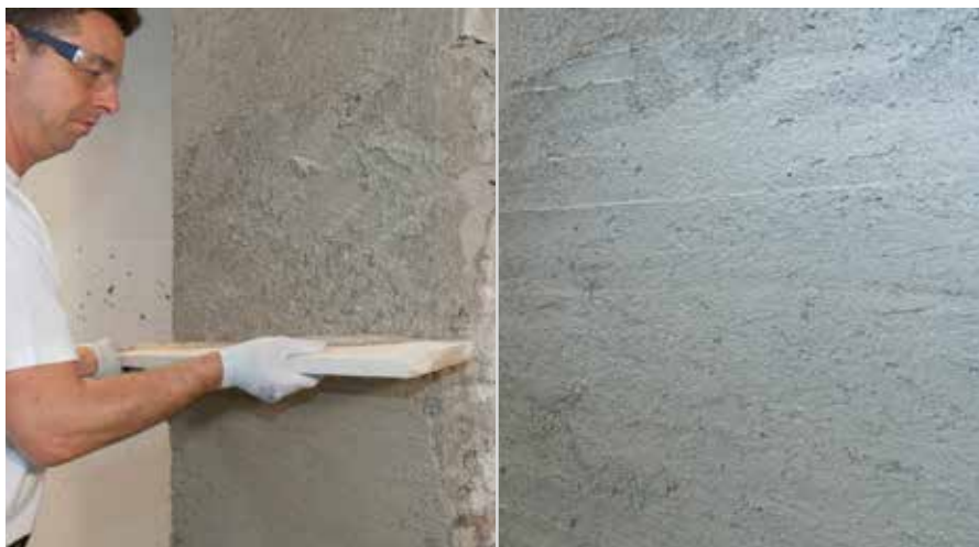
Skidanje/izvlačenje krečnog maltera
