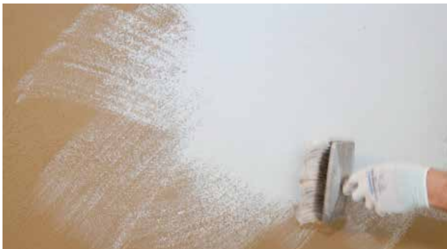
Nanošenje krstastim potezima molerskom četkom pod pravim uglom
