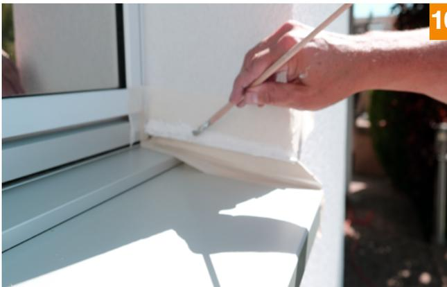
10. Sichtbare Fugendichtbänder können mit einer geeigneten Fassadenfarbe, im gewünschten oder bestehenden Farbton, schwach deckend beschichtet werden.
