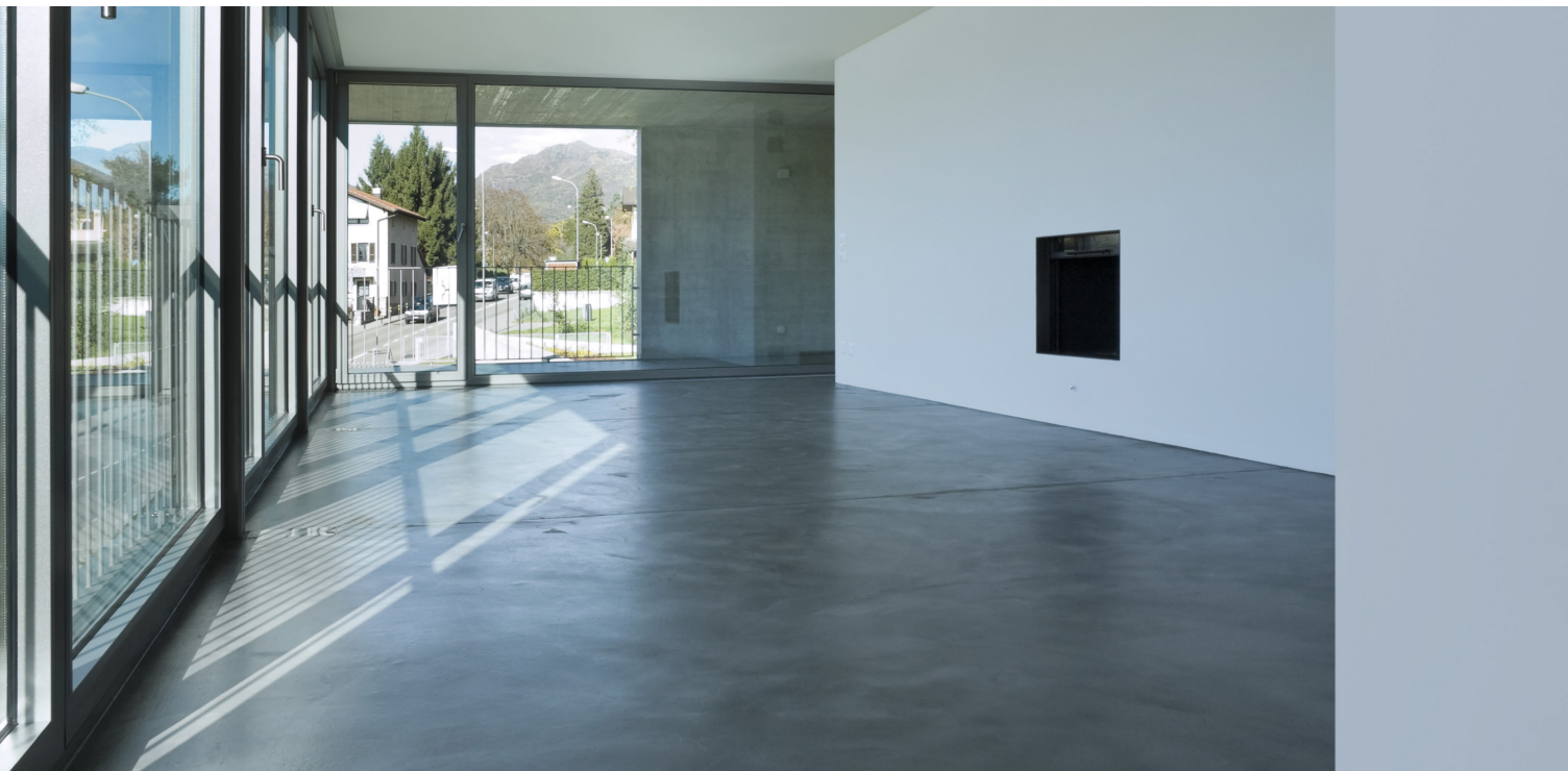
Ново строителство с бетонен замаз, Германия
