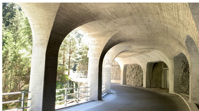
Ремонт на „Galerie Viamala 1“, Швейцария
