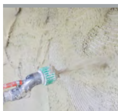
3 Nanos toplotnoizolacijskega ometa
