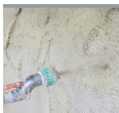
3 Nanos toplotnoizolacijskega ometa
