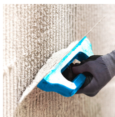
5 Izvedba armirnega sloja z ustrezno malto in mrežico
