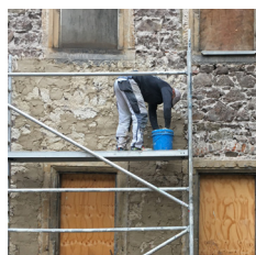
2 Morebitna pripravljala dela kot nanos obrizga in/ali nosilca ometa ipd.
