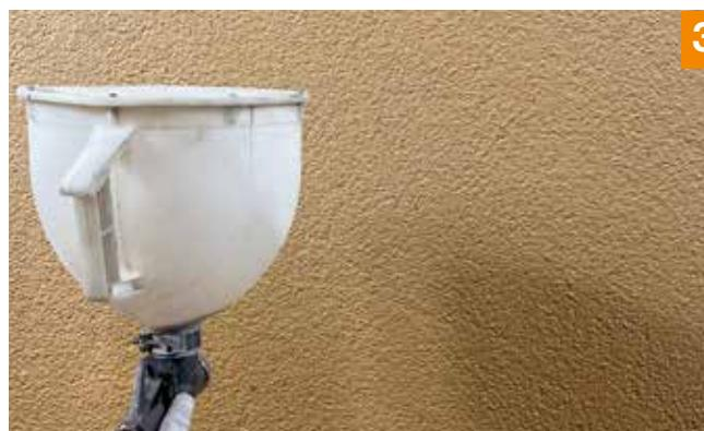
3. Das Einblasen der Glitzer-Effektmischung aus Glas erfolgt mit der Trichterpistole in leicht kreisenden Bewegungen direkt in den zweiten, noch nassen Anstrich.
