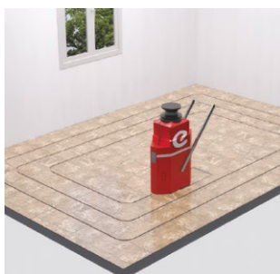
Fresatura della pavimentazione
