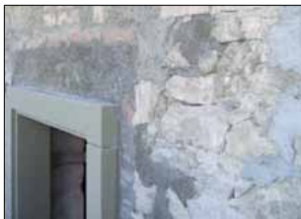
Rimozione del vecchio intonaco e riempimento delle cavità. Se necessario applicare uno strato di intonaco di livellamento.
