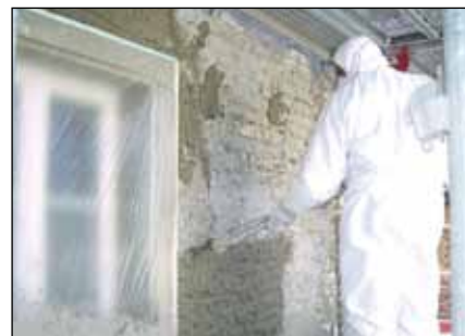
Applicazione meccanica del collante RÖFIX AeroCalce IA 780 COLL.
