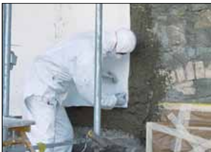
Nella malta ancora fresca annegare RÖFIX AeroCalce IB 980 con giunti strettamente accostati e senza malta.
