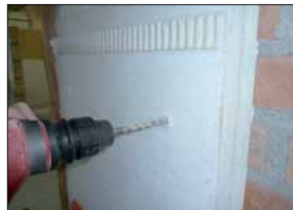
Praticare il foro vero e proprio con un trapano con punta da 8 mm.
