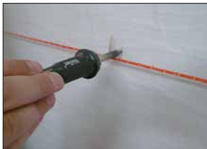
Con una cesoia a lama calda o altro idoneo strumento praticare un piccolo foro nella stuoia in feltro.
